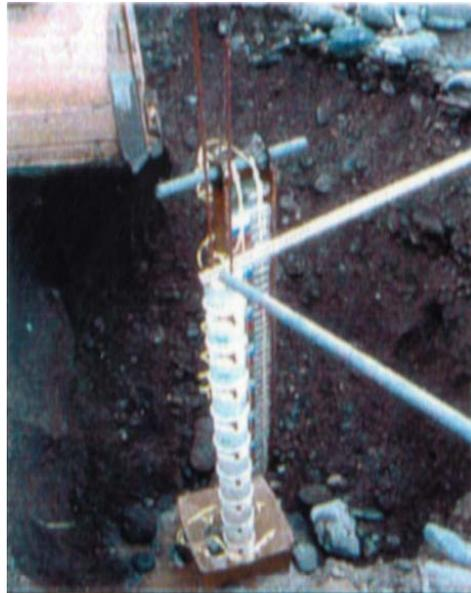
図－ 8.8 洗掘センサー (姫川)
