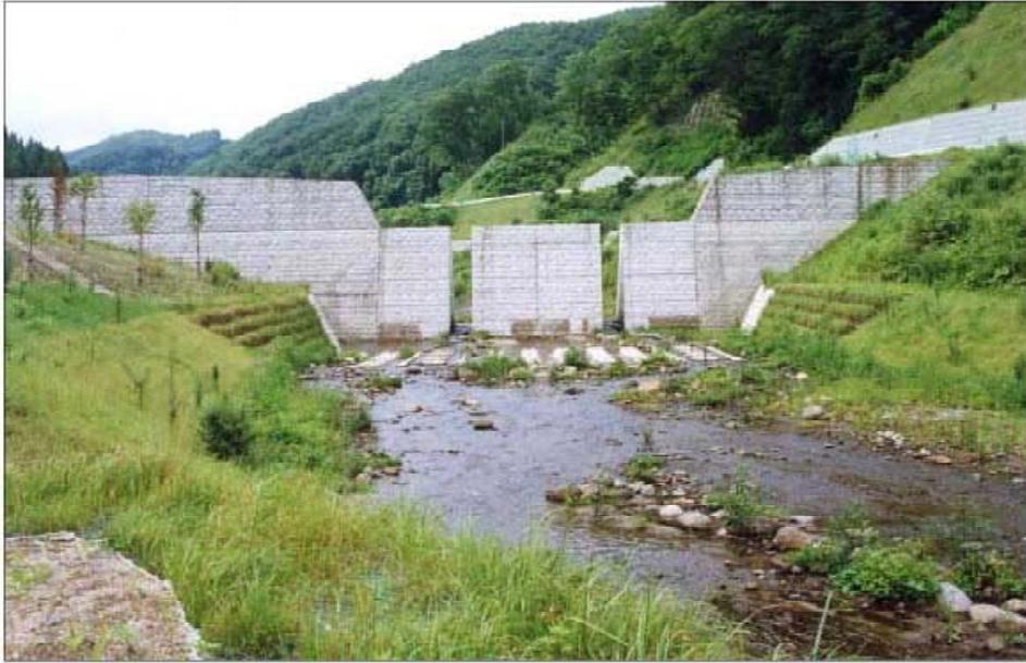
図－ 8.19 スリット型砂防ダム（淵沢川 十和田湖町淵沢地内）（参考文献<sup>3)</sup>より）
