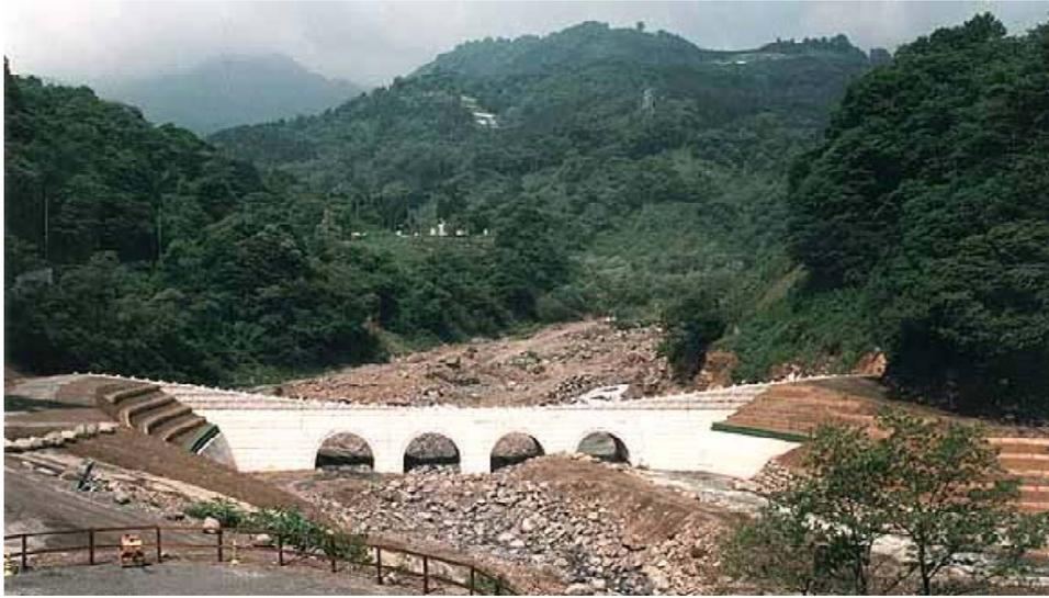
図－ 8.18 浦川スーパー暗渠砂防ダム（参考文献<sup>2)</sup>より）
