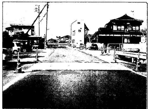
写真-1 ハンプ設置状況
