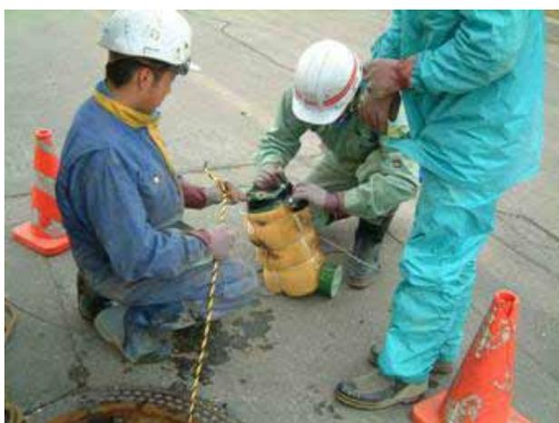
写真 4.3.1 管渠内固形物の採取作業
