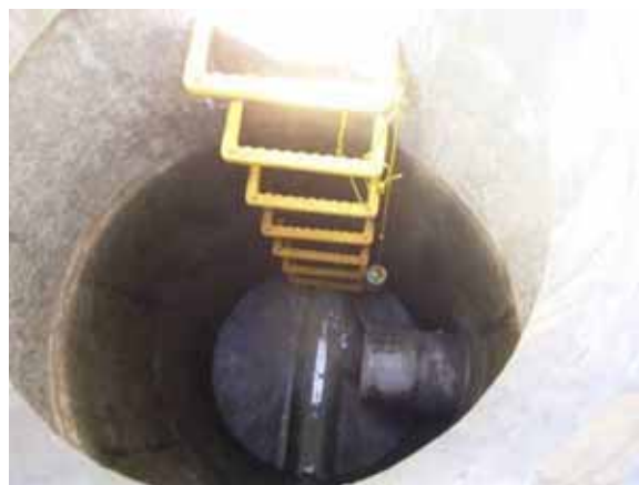
写真 4.8.1 拡散式硫化水素測定器の設置状況
