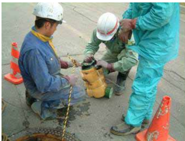
写真 4.3.1 管渠内固形物の採取作業
