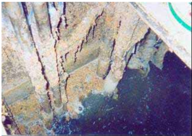
写真 5.3.3 第一中継ポンプ場壁面の状態
