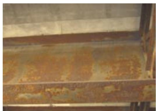
写真-5.5 耐候性鋼材に安定錆が形成されていない状態の例
