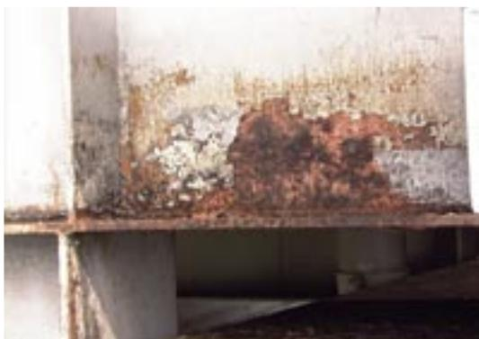
写真-1.1 集中的に錆が発生した例
