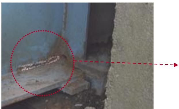
写真-1.13 腐食と同時に亀裂を生じた例
