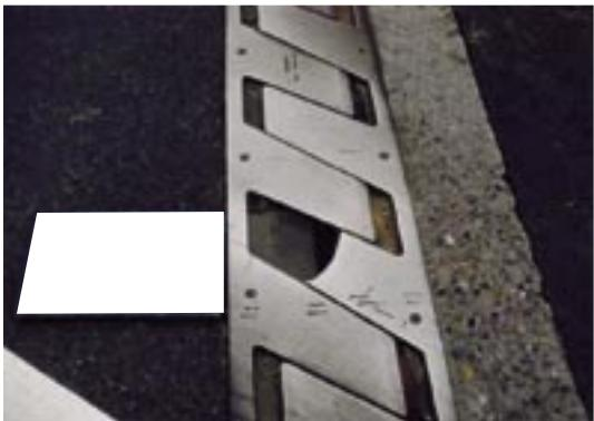
写真-4.3 伸縮装置に生じた例
