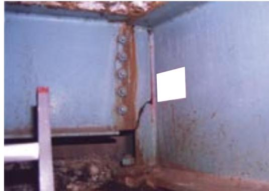
写真-4.2 端横行で破断しているとみなせる程度に断裂した例
