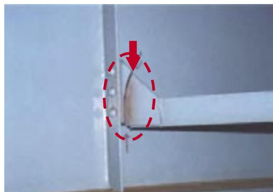
写真-2.9 亀裂の進展により破断が生じた例
