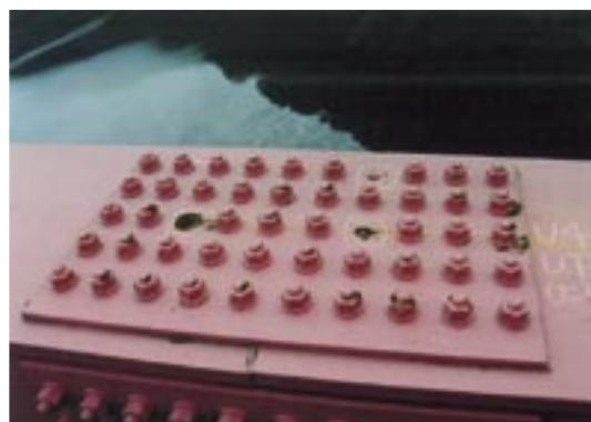
写真-3.2 ボルトが脱落した例
