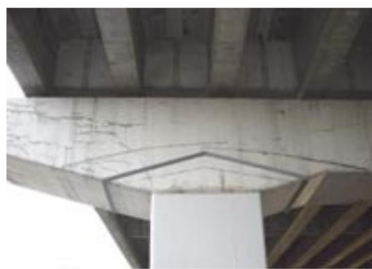
写真-5.12 コンクリート部材の塗装変状が生じた例
