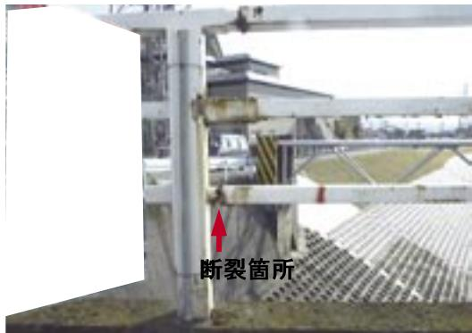
写真-4.5 腐食が進展して高欄で破断が生じた例
