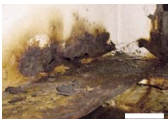
写真-1.15 腐食と同時に亀裂(断面欠損)を生じた例
