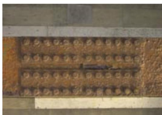
写真-5.6 耐候性鋼材に安定錆が形成されていない状態の例
