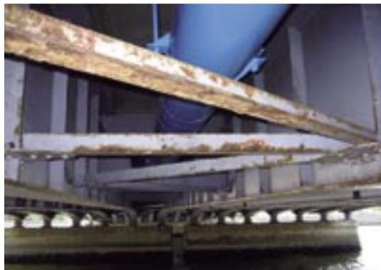
写真-5.7 鋼材の腐食の例
