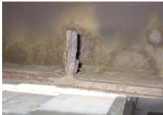
写真-5.10 耐候性鋼材に断面欠損が生じた例
