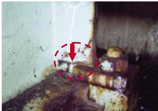
写真-2.6 亀裂が生じた例
