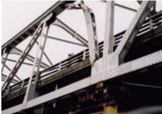
写真-4.7 斜材に破断と変形が生じた例
