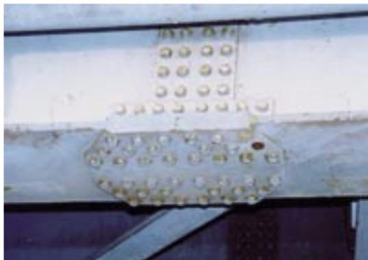
写真-3.1 ボルトが脱落した例
