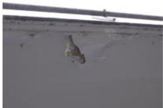
写真-5.11 コンクリート部材の塗装こみれが生じた例
