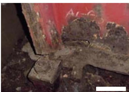
写真-1.14 腐食と同時に亀裂(断面欠損)を生じた例
