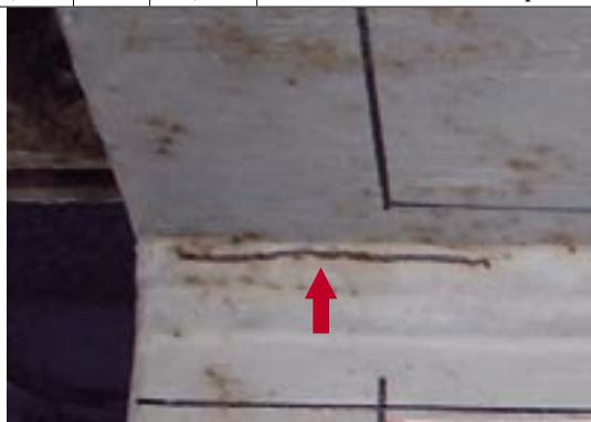
備考 ① 鋼製橋脚の隅角部の溶接部
