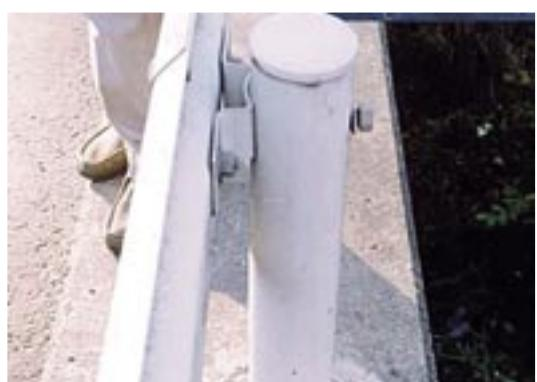
写真-3.5 ボルトにゆるみが生じた例
