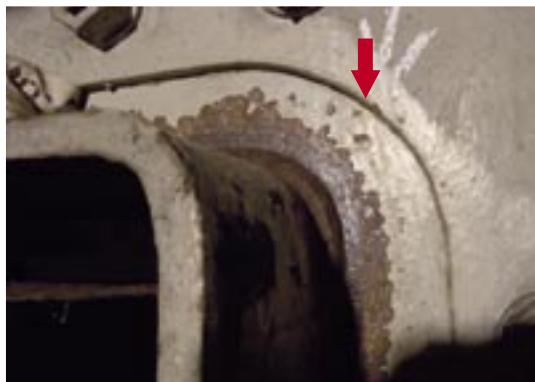
写真-2.1 柵端切欠きR部に生じた例
