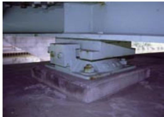
写真-1.6 断面欠損を伴わないと見なせる程度の軽微な錆が発生した例
