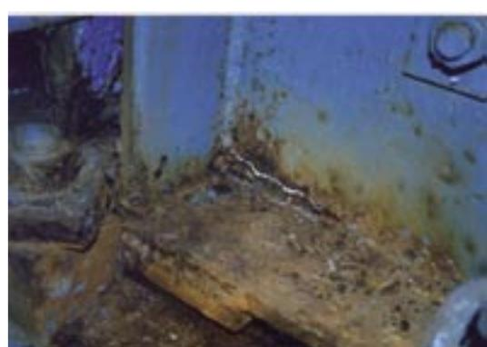
写真-2.5 鋼と同時に亀裂が生じた例
