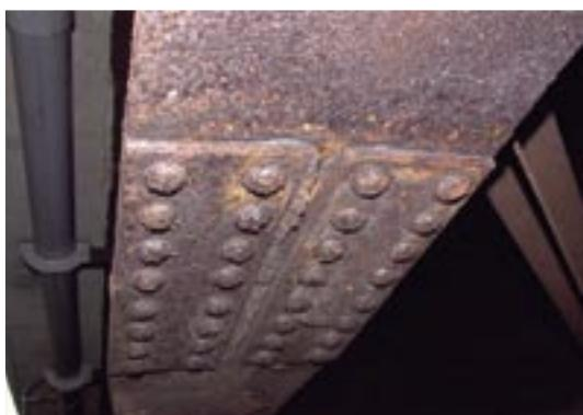
写真-1.7 耐候性鋼材の錆の状態が一様でなく、断面欠損を伴う例
