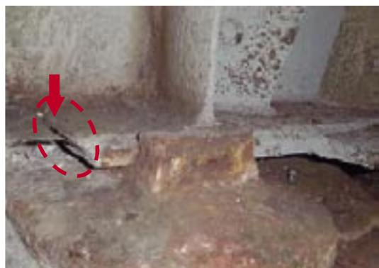
写真-2.8 腐食による表面減少と同時に亀裂が生じた例
