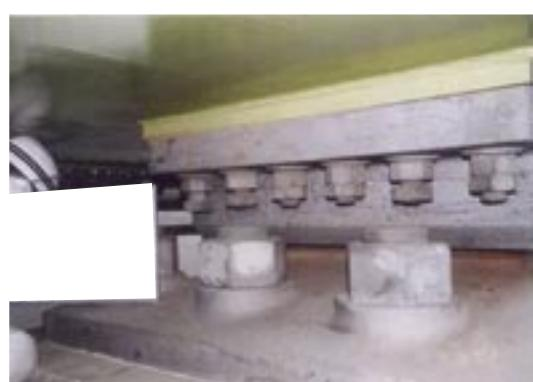
写真-3.6 ナットにゆるみが生じた例
