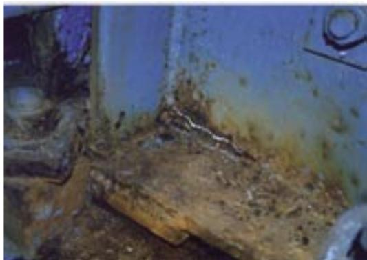
写真-1.11 腐食と同時に亀裂を生じた例
