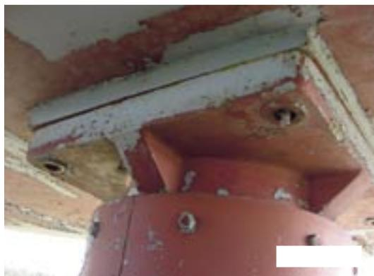
1) セットボルトの破断
