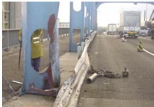
写真-4.6 吊り材に破断しているとみなせる程度の断裂と変形が生じた例
