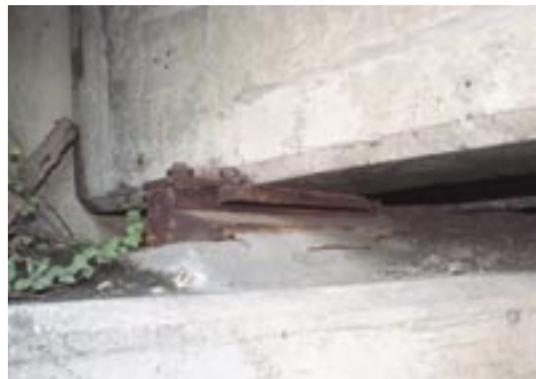
写真-5.8 鋼材の腐食の例
