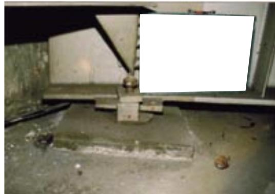
写真-3.8 支承アンカーボルトのゆるみが生じた例
