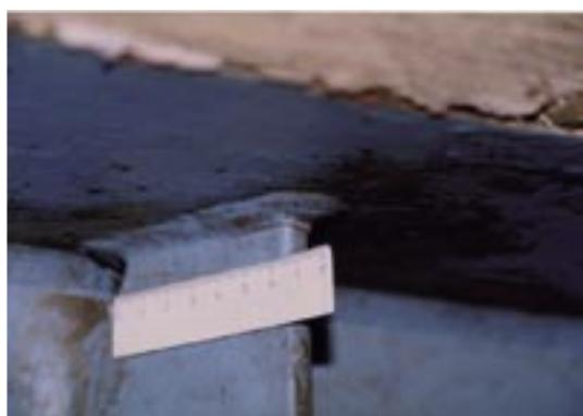
写真-2.2 垂直補剛材の溶接部に生じた例
