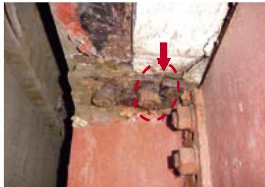
写真-2.7 亀裂が生じた例
