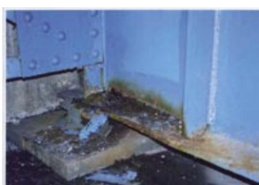
写真-1.4 桁端部、支承部周辺での滯水、塵埃等の堆積による腐食の例
