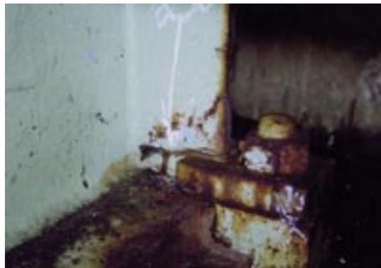
写真-1.12 腐食と同時に亀裂を生じた例
