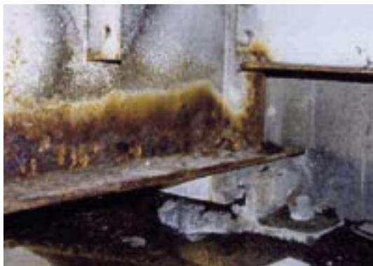
写真-1.5 断面欠損を伴う錆が発生した例
