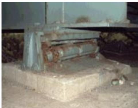
写真-3.7 支承ローラーが脱落した例
