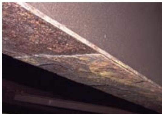
写真-1.2 耐候性鋼材に断面減少を伴う異常な錆が発生した例
