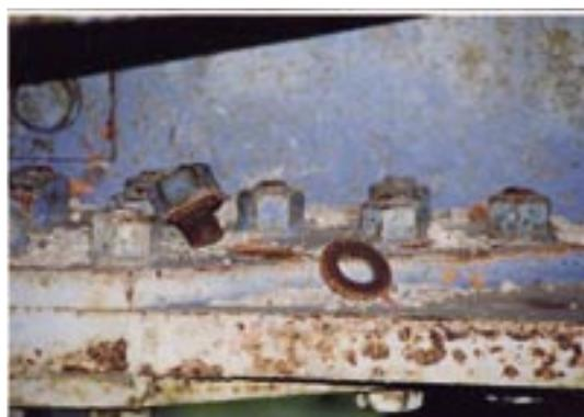
写真-3.4 ボルトが脱落した例
