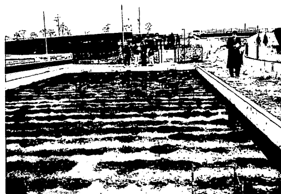
写真-8 植生浄化施設 (山寺川市街地排水対策事業施設)
