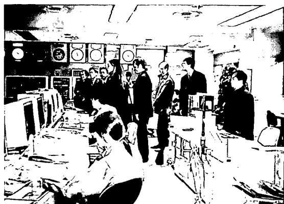
写真-3 中央監視室 (芝浦処理場)
