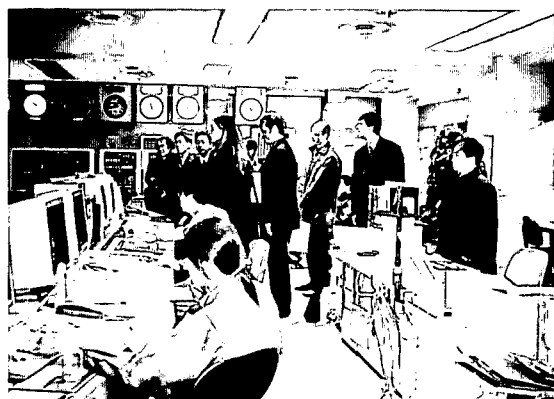
写真-3 中央監視室 (芝浦処理場)
