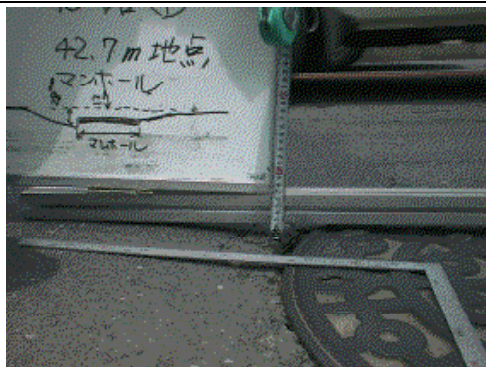
車輪通過位置にあるマンホール周りの路面不整
