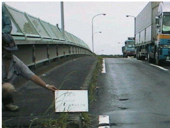
橋梁伸縮装置部（進入部）の顕著な段差
