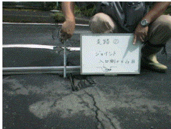
橋梁伸縮装置部（進入部）の顕著な段差
