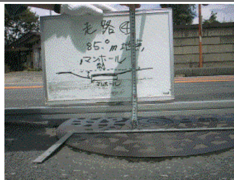
車輪通過位置にあるマンホール周りの路面不整
