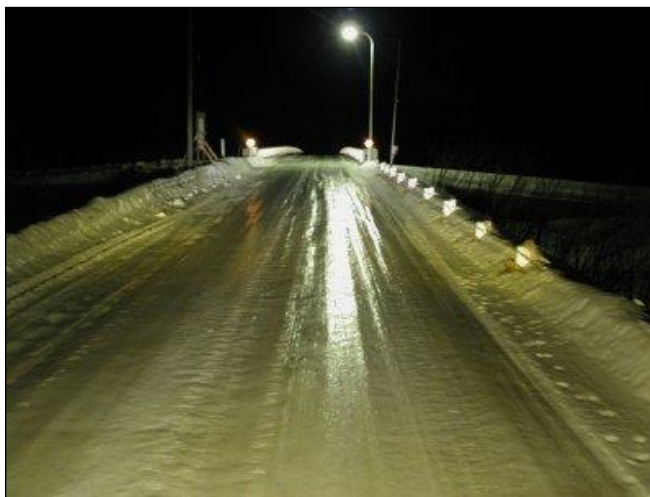
写真 2 非常に滑りやすい路面（通称、つるつる路面）
