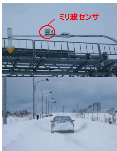
写真 7 矢羽根支柱（ミリ波センサ、振動計測装置取り付け後）
