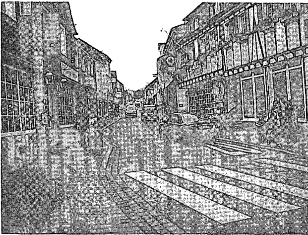
写真-2 ムッフ(独)における、沿道建物と狭さく (連邦道路 Bundesstrasse 56 号線)
