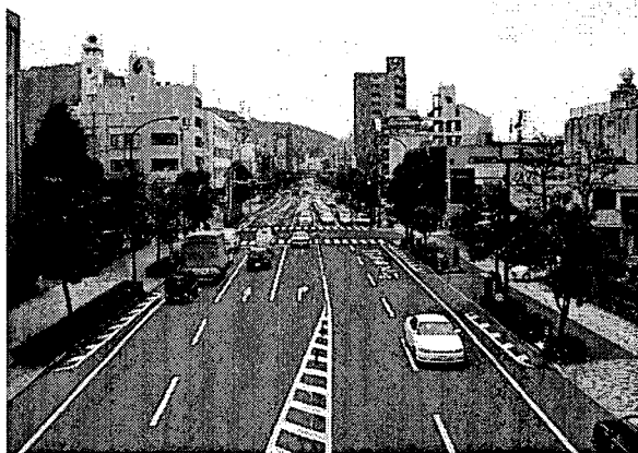
写真-1 再構築後の状況
