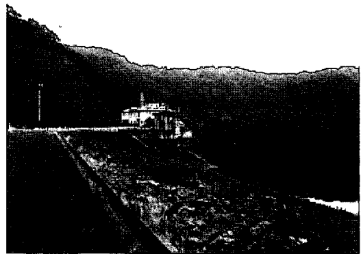
写真6.6 樽水ダムの上流面
