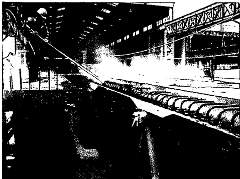
写真-4.3.16.1 高圧水による打継目処理状況
