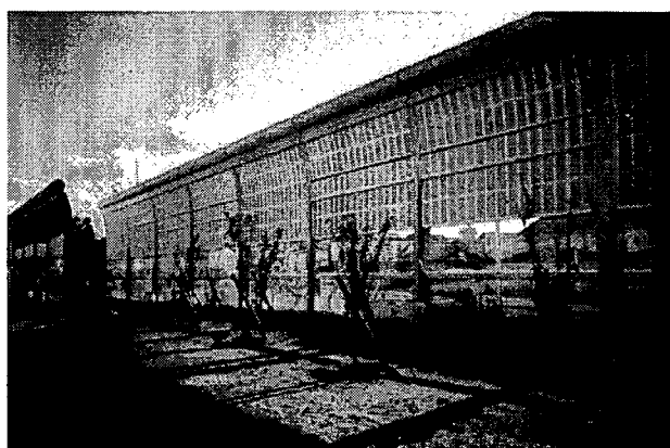
図－１ 光触媒の遮音壁への適用例（名古屋市守山区）
