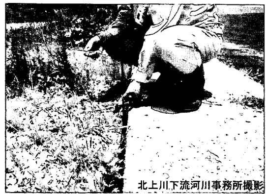
北上川下流河川事務所撮影 写真5. 10 被災直後の月浜地区、低水護岸と背後の地盤に間隙(北上川左岸2.2k)
