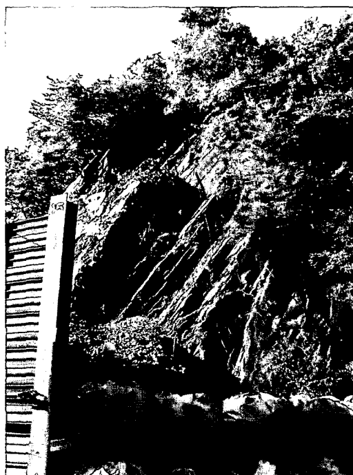
写真8.4 世田米子飼沢地区 落石状況
