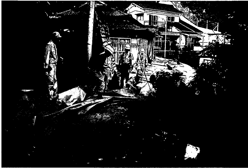
写真G 8.1 急傾斜地崩壊危険箇所における斜面のり肩のき裂の発生 (宮城県牡鹿町前浜地区)
