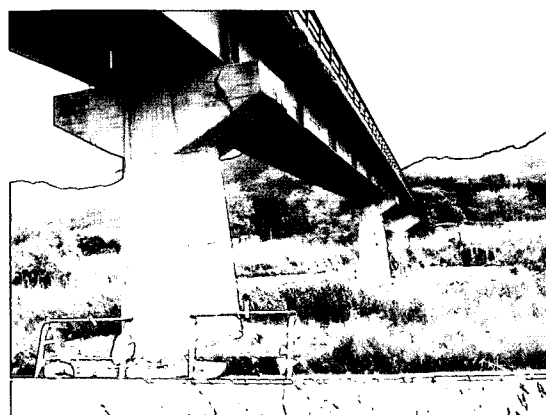
写真7.6 村道船渡線船渡橋 (RC橋脚)
