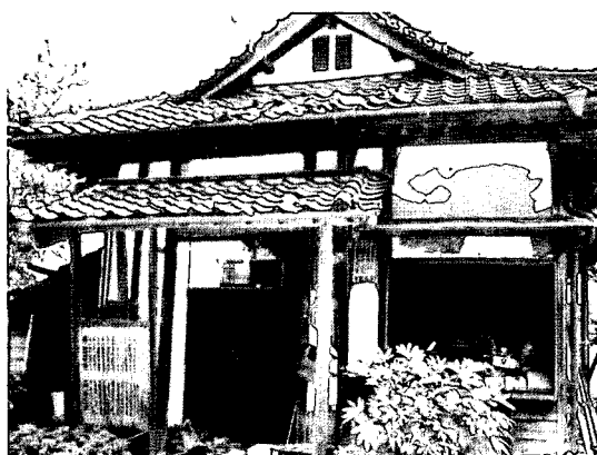
写真 10.12 木造平屋建て外壁の被害
