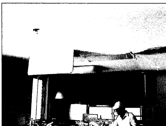
写真 10.15 台所収納の落下
