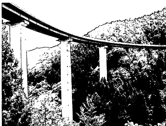
写真 7.19 国道343号笹の田大橋 (岩手県大東町、ハイピア50m程度、ループ橋)
