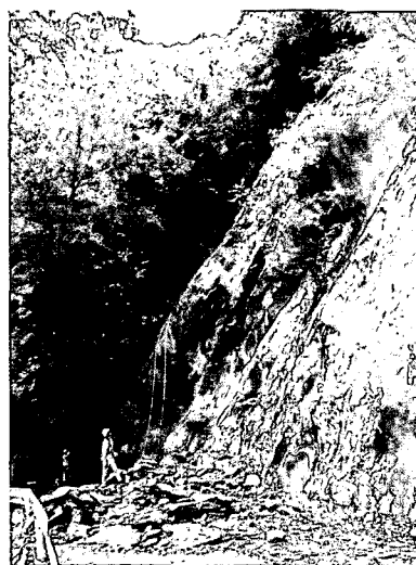
写真8.5 甲子町(その1)地区 落石状況
