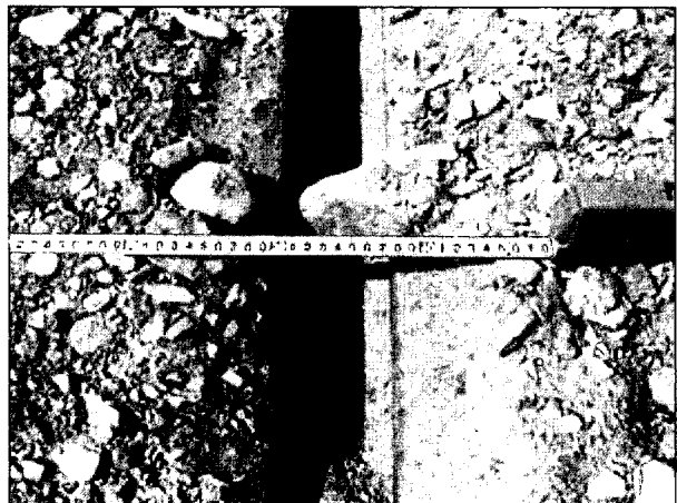
写真 9.1 噴砂痕(岸壁法線から陸側 60m付近)
