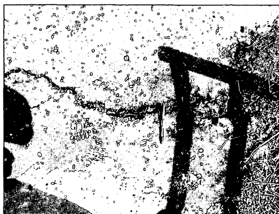
写真 6.6 衣川 5 号ダム天端 右岸側舗装部亀裂
