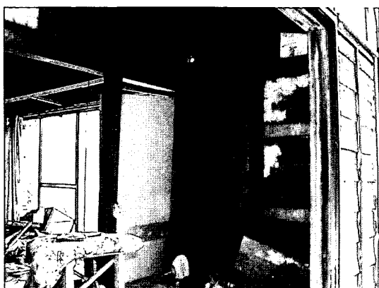
写真 10.13 木造平屋内壁の被害
