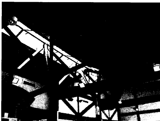
写真10.3 大断面材を用いたトラス構造
