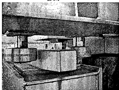
閉状態-ゲート上部
