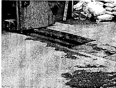
レール (鉄板カバー)
