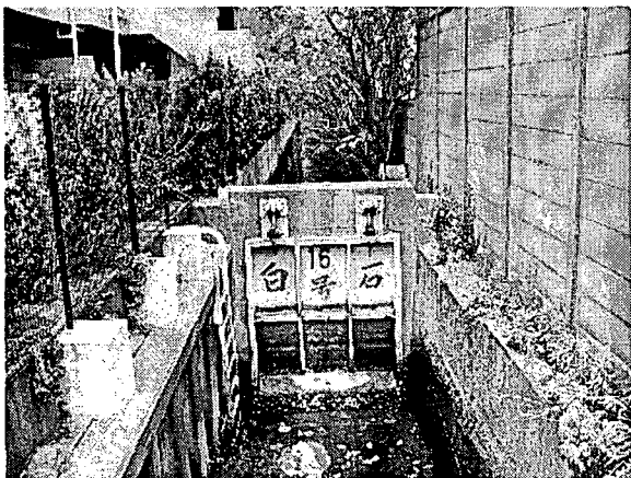
写真-2.6 川崎港白石16号樋門
