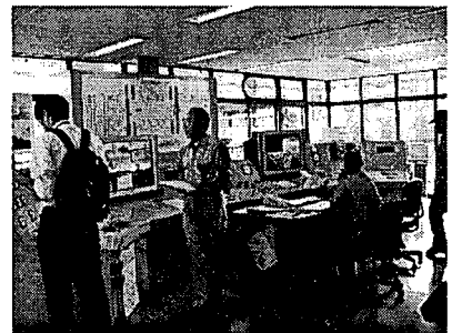
扇橋閘門操作室
