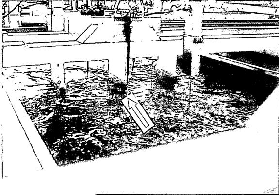
通水中（上流斜めから）
