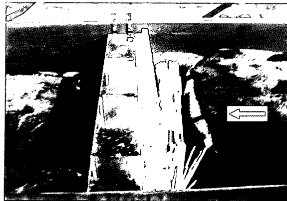
参考写真5 河床変動と流木集積を伴った場合の水位せきあげ状況
