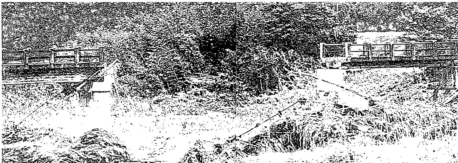
写真 2.3 被災規模3：橋桁流失、(露橋)
