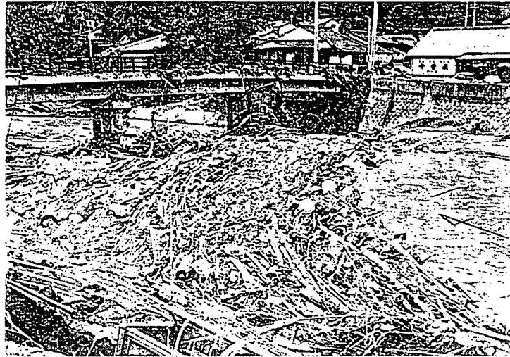
写真 2.1 被災規模 1：流木による河道閉塞、溢水有、(飯山橋)
