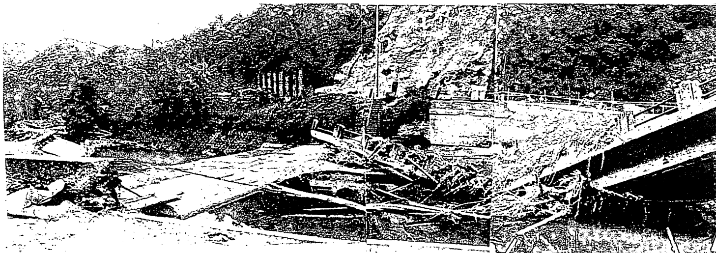
写真 2.4 被災規模 4：橋桁流失、橋脚流失、河岸欠壊、(荒平橋)
