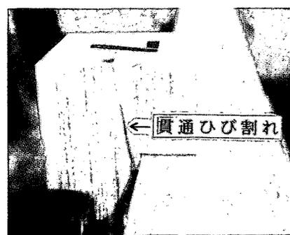
写真-2 嵌合部のひび割れ状況
