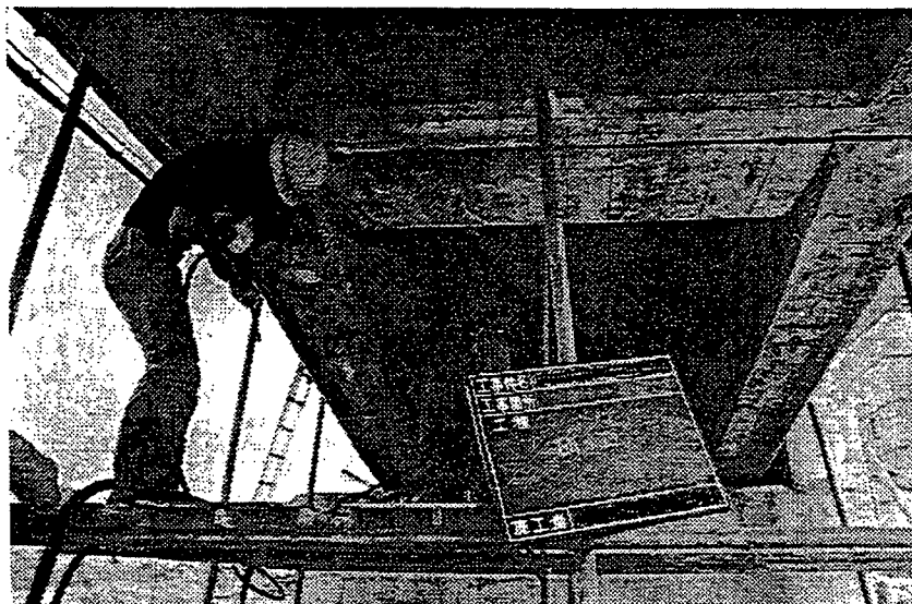
コンクリート表面の劣化部分のはつり
