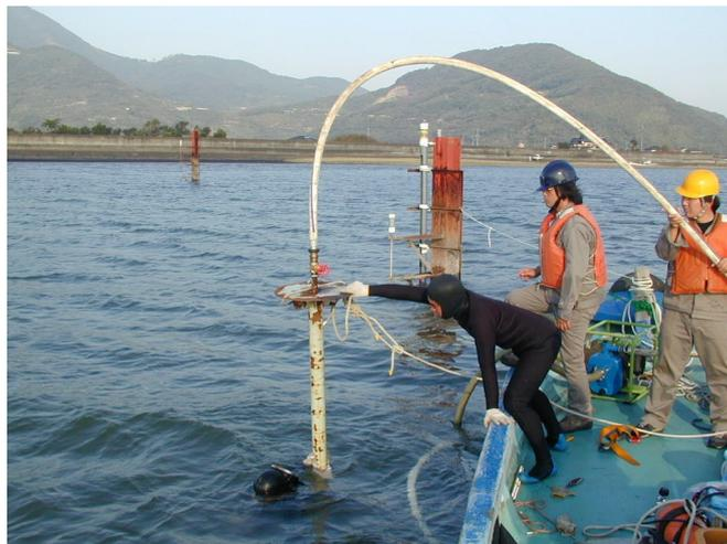
写真－6－1 超音波流速計の設置
