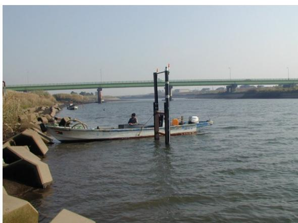
写真－6－3 河道のH鋼打設状況
