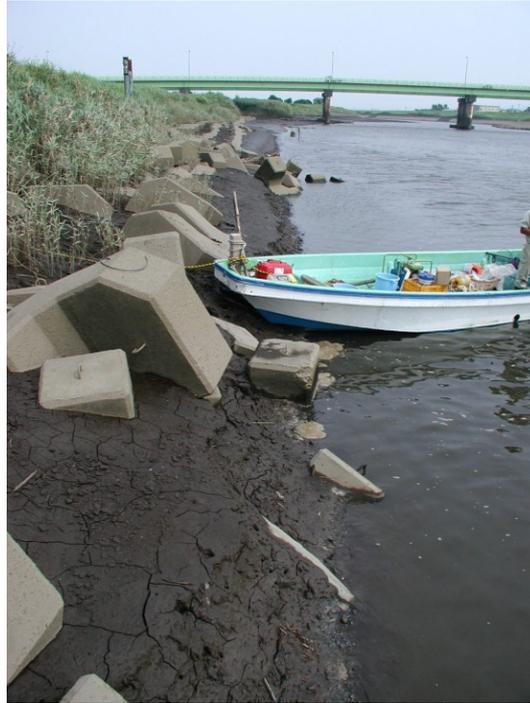
写真－２－３ 洪水による河岸泥質の侵食状況
