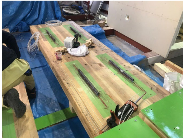
図 3.2.1 合成床の施工状況
