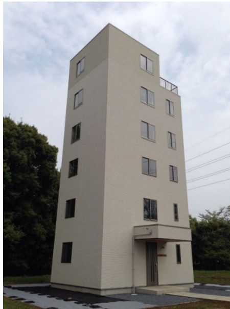
図 4.1.1 ツーバイフォー6 階建て実大実験棟
