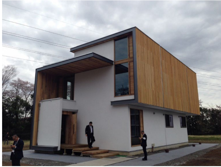
図 5.1.1 つくば CLT 実験棟
