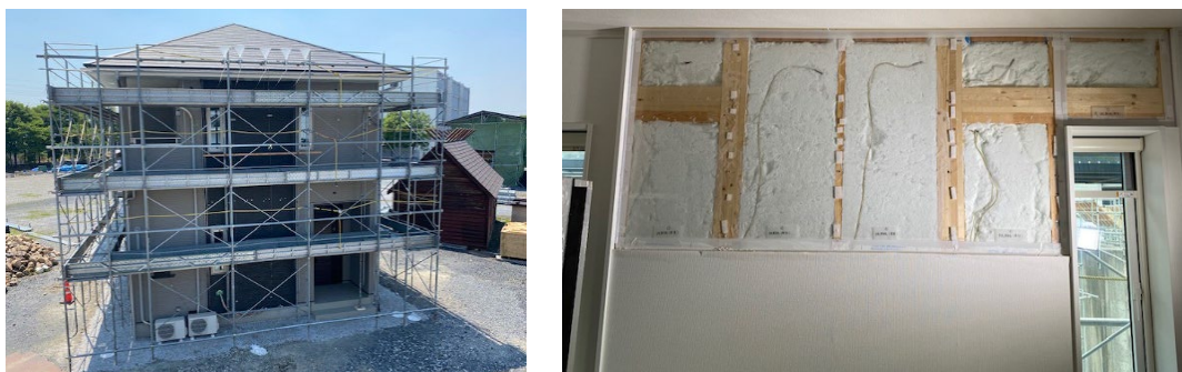
図 5.2 木造 6 階建て建物の外壁通気層内部の環境計測実験のセンサの配置と計測結果の例
