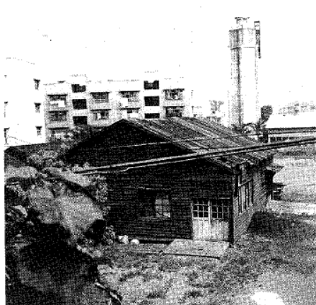
昭和34年用途廃止された木工場
