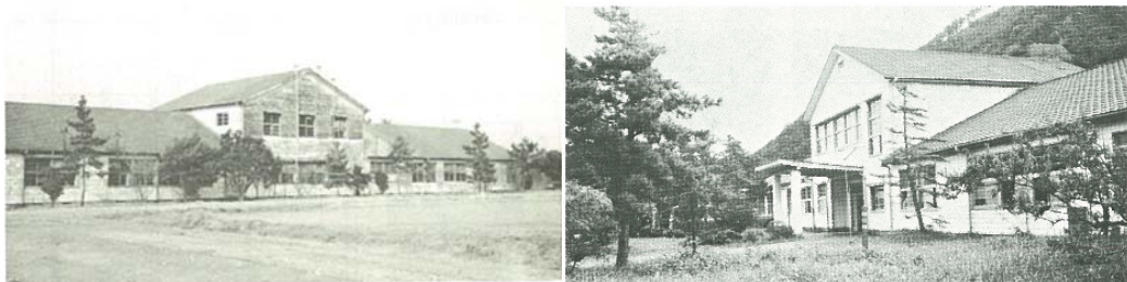
写真 4-6-2, 3 左：土木研究所沼津支所の本館 *95 右：建設大学校沼津分校の本館 *98
