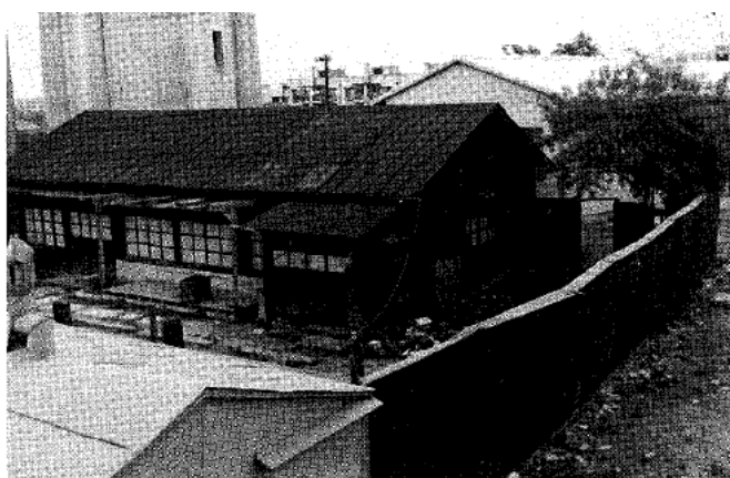
昭和36年用途廃止された宿舎（篠沢宅）
