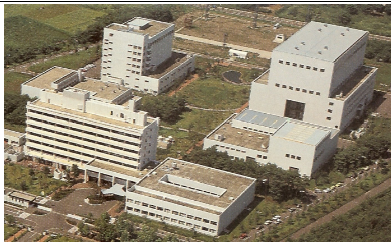
左手奥：実大火災実験棟 右手奥：実大構造実験棟 手前：管理研究本館 （右手1階：国際地震工学部）
