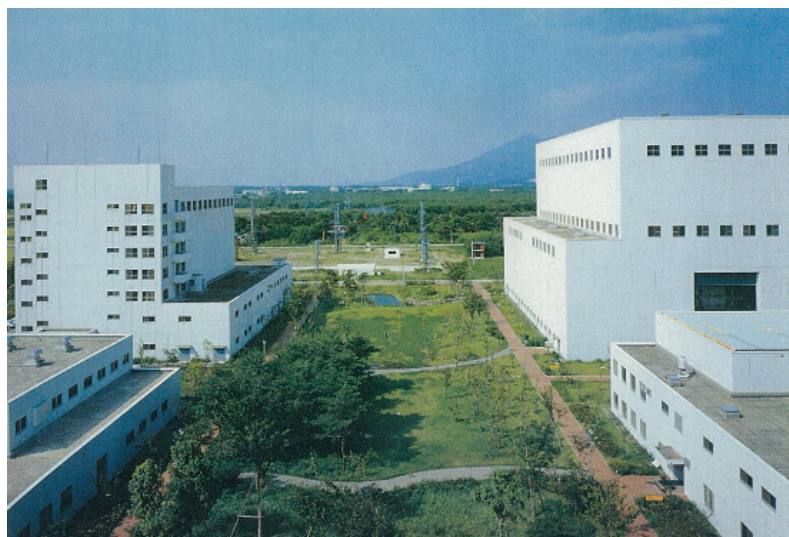
左：実大火災実験棟 右：実大構造実験棟
