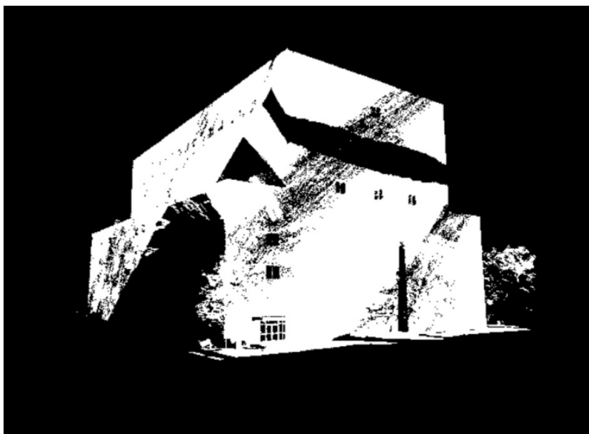
図 2-3-5 MMS で取得した建築研究所の実験棟建物の点群データ(実大構造物実験棟,2013)
