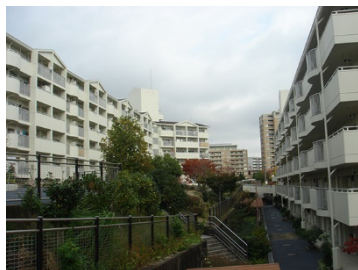
活用している団地・住棟の外観
