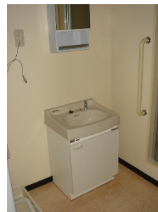
洗面所(右は浴室、左は洗濯場。浴室入り口は段差が大きいため手すり付き)
