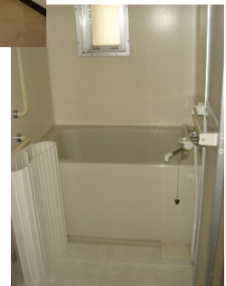
浴室(手すり付き)
