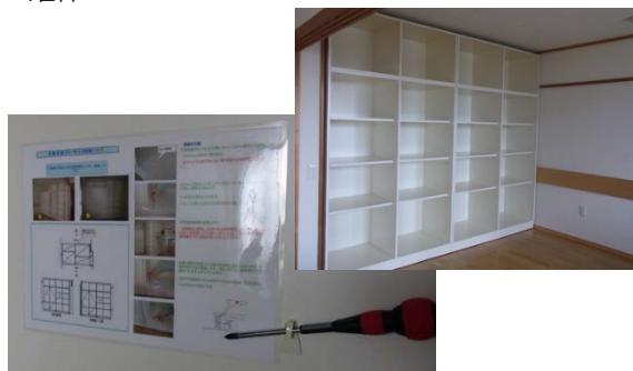
写真事例 6.2 ドライバー一本で動かせる可動間仕切り(本棚)とその操作説明書
