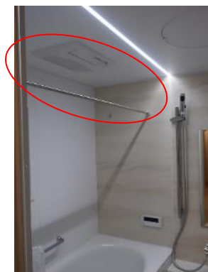
写真Ⅱ.31 浴室の換気暖房乾燥機と吊り下げ式物干し
