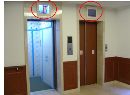
写真Ⅱ.62 エレベーターホールに設置されたエレベーターかご内の様子を把握できるモニター
