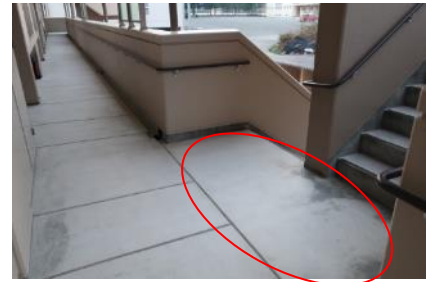
写真Ⅱ.65 共用階段と共用廊下の歩行者どうしの衝突防止に配慮された階段（階段最上段の共用廊下への食い込み、最下段の共用廊下への突出の防止）
