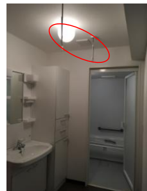
写真Ⅱ.32 洗面・脱衣室に設置された吊り下げ式物干しと洗濯物干しスペースの確保
