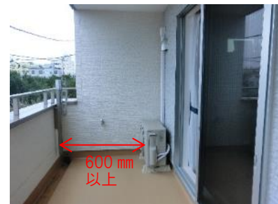
写真Ⅱ.52 手すりからの離隔距離を確保した室外機置場
