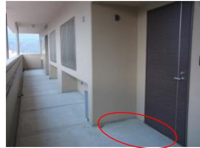
写真Ⅱ.63 アルコーブが設置された玄関前
