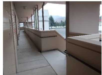
写真Ⅱ.64 子どもの使いやすさに配慮した高さに設置された手すり
