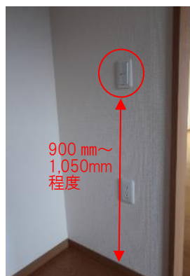
写真Ⅱ.9 子どもの手の届きやすい高さ（床上1,050mm以下）に設けられた電気スイッチ
