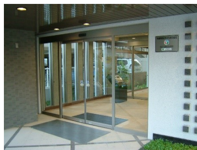
写真Ⅱ.56 オートロック式の自動エントランスドア 注1)
