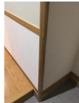
写真Ⅱ.2 出隅の角部へのカバー取り付け
