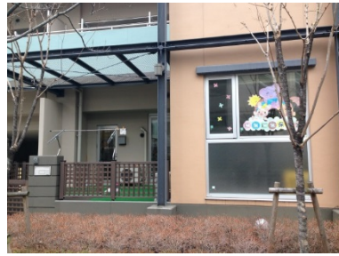
写真Ⅱ.95 地域の住宅を改修して設置された小規模保育室
