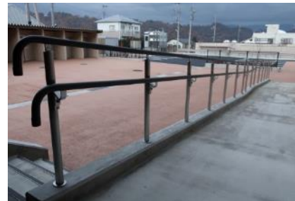
写真Ⅱ.66 子ども用手すりが設置された2段手すりのスロープ
