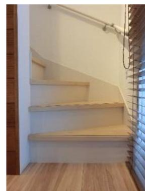
写真Ⅱ.18 昇降途中に折れ曲げを設けた折れ階段
