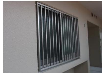
写真Ⅱ.6 共用廊下に面する窓に取り付けられた面格子
