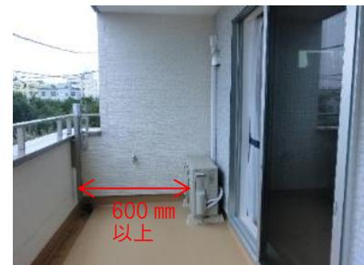
写真 II.52 手すりからの離隔距離を確保した室外機置場
