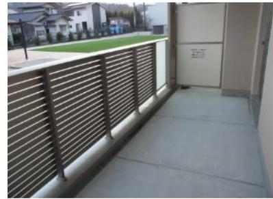
写真 II.51 バルコニーの転落防止に配慮された手すり
