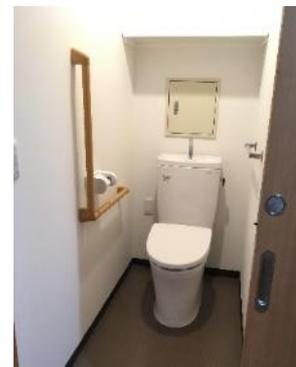
写真Ⅱ.21 トイレの手すりは、立ち座りや子どものトイレトレーニングをサポートしやすい位置に設置
