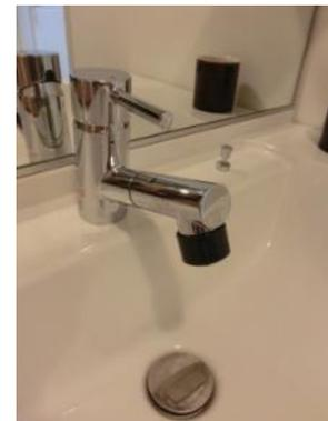
写真Ⅱ.30 洗面台のレバーハンドル式水栓。伸縮式シャワー水栓でもある
