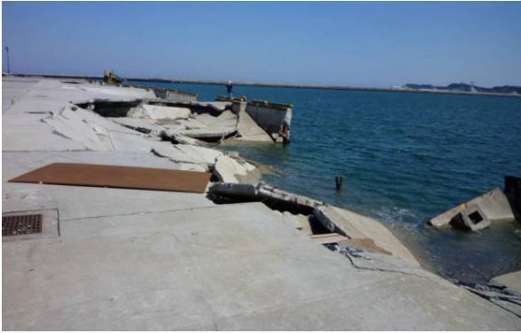
写真-3.3.7.4 相馬港における岸壁の決壊
