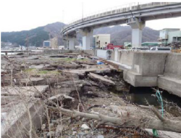
(c) 海側に洗掘された事例（釜石港海岸須賀地区） （胸壁天端高 T. P. +4. 00、近傍痕跡高 T. P. +8. 64） 写真-3. 3. 7. 9 海岸保全施設の被災事例
