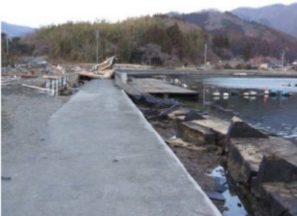
(b) 堤体が海側に倒壊した事例（大船渡港海岸永浜地区） （胸壁天端高 T. P. +3. 00、近傍痕跡高 T. P. +10. 02）
