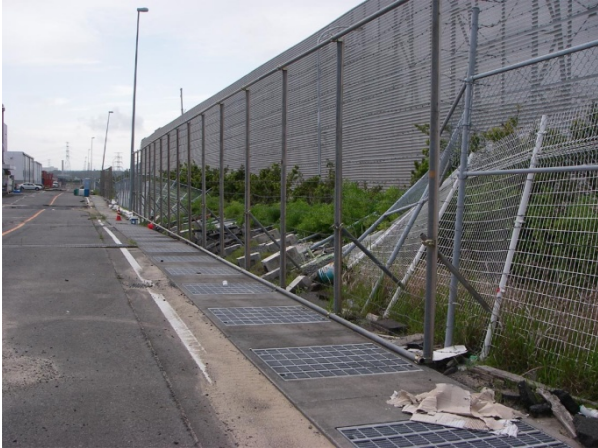
(a) フェンスの被害状況 (茨城港常陸那珂港区北ふ頭地区、流出コンテナは撤去済み)
