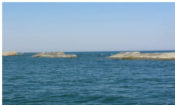
写真-3.3.7.1 相馬港防波堤被災状況
