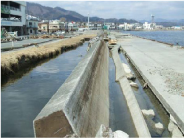
(a) 堤体が陸側に倒壊した事例（大船渡港海岸茶屋前地区） （胸壁天端高 T. P. +3. 40、近傍痕跡高 T. P. +8. 07）
