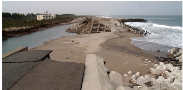
写真-3.3.5.2 全壊した海岸堤防（宮城県岩沼市二のノ倉海岸）
