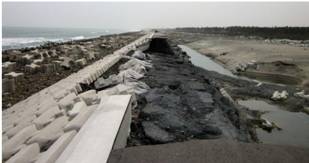
写真-3.3.5.1 半壊した三面張り構造の海岸堤防と裏法尻部における洗掘の状況（宮城県岩沼市蒲崎海岸）
