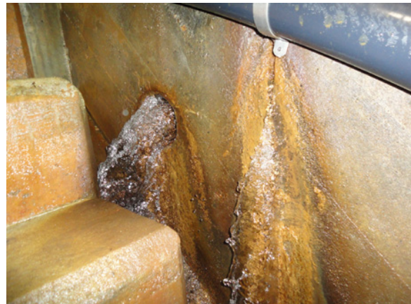
写真-3.3.4.11 横継目(J9)からの漏水の状況 (高坂ダム)
