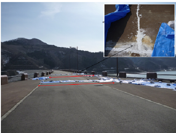
写真-3.3.4.1 ダム天端の左岸取付け部におけるクラック(摺上川ダム)
