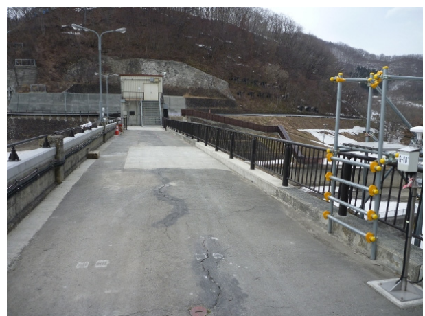
写真-3.3.4.4 石淵ダム天端（今回の地震） *舗装の補修跡は2008年の地震によるもの
