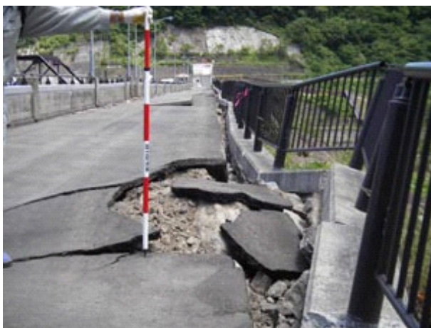
写真-3.3.4.3 石淵ダム天端（2008年の地震）
