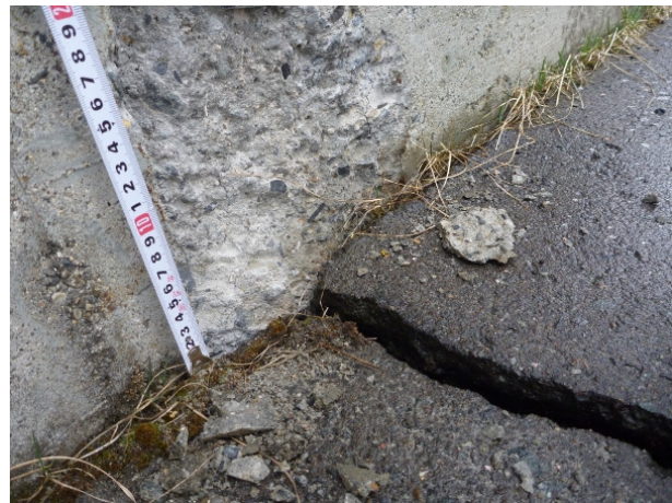
写真-3.3.4.6 天端舗装の継目の段差 (田瀬ダム)
