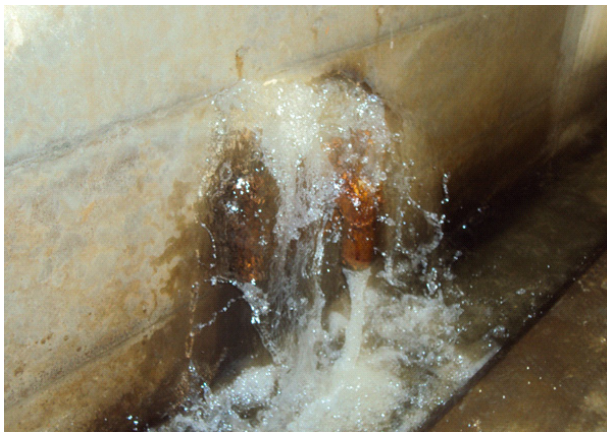
写真-3.3.4.10 横継目(2J3)からの漏水の状況 (神室ダム)
