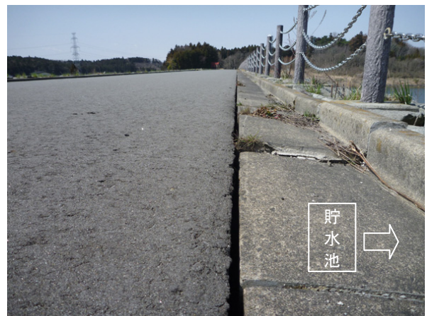
写真-3.3.4.9 天端中央部の縁石と舗装の開き（化女沼ダム）
