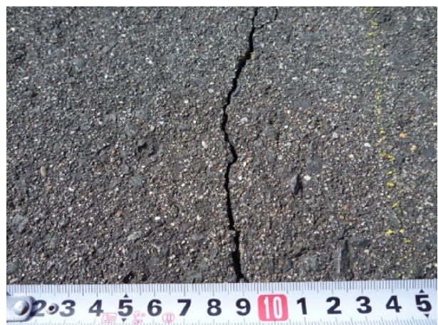
写真-3.3.4.2 ダム天端舗装クラックの接写(摺上川ダム)
