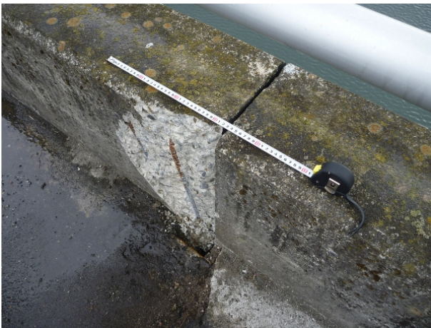
写真-3.3.4.5 天端高欄コンクリートの剥落 (田瀬ダム)
