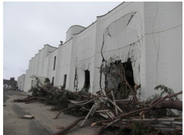
(b) 漂流物による建築物への直接被害
