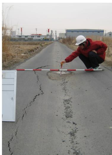
写真-3.3.2.5 液状化対策工（被害有）
