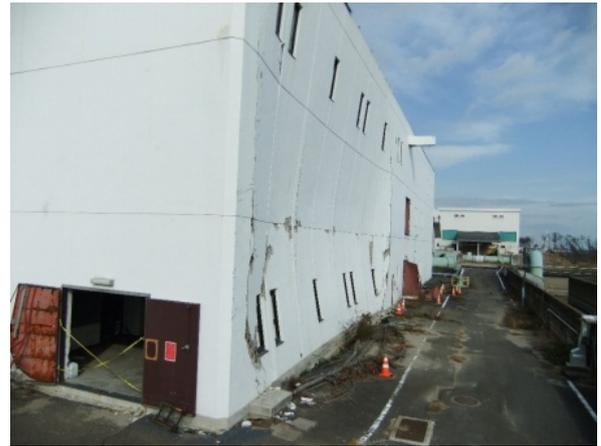
(a) 波圧による津波浸入方向の壁面被害
