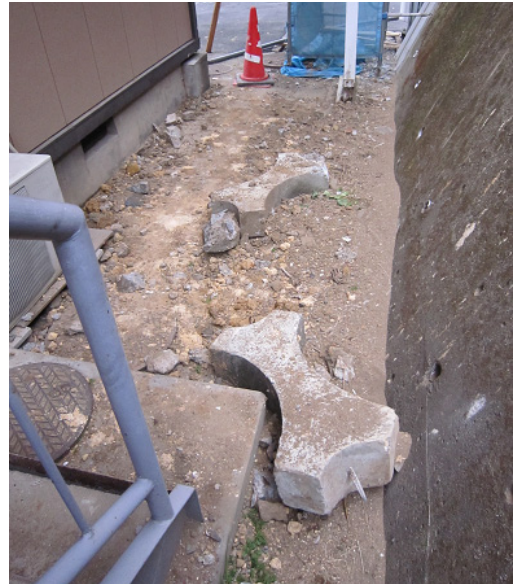
写真-3.3.1.5 斜面下部に落下したのり 枠工の破片
