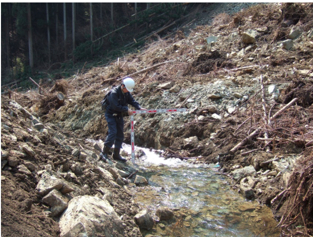
写真-3.3.1.35 開削された水路の断面（写真奥側下流）
