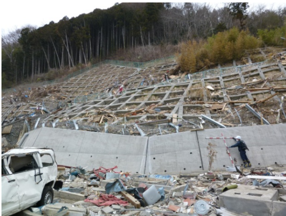
写真-3.3.1.14 ストーンガード座屈状況
