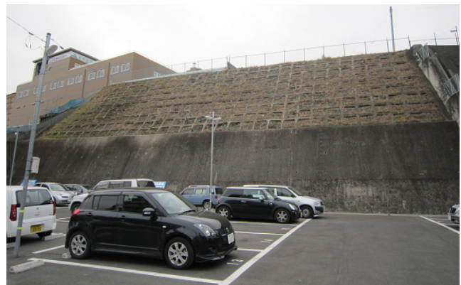
写真-3.3.1.7 擁壁工、のり枠工 (擁壁に特に異常 は見られず)
