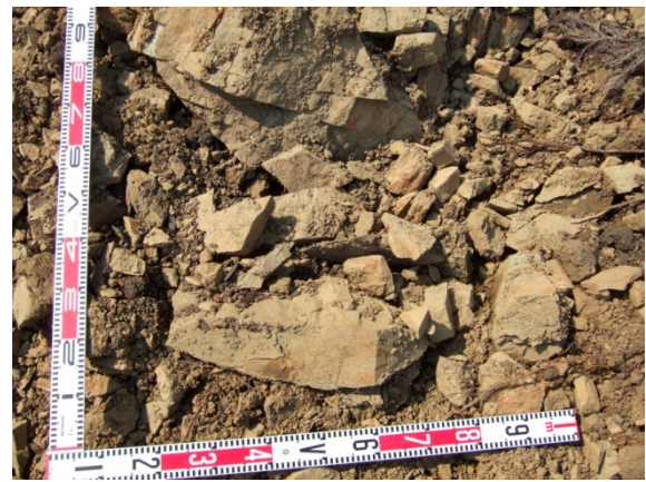
写真-3.3.1.28 テラスにおける崩壊土砂
