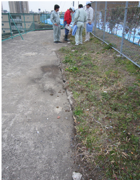
写真-3.3.1.3 駐車場にもクラック が入っている
