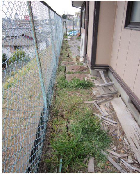
写真-3.3.1.2 クラックが入っている
