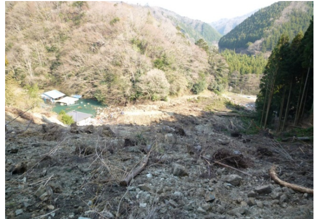
写真-3.3.1.27 人家まで到達した土砂 (崩壊中腹部のテラスから撮影)
