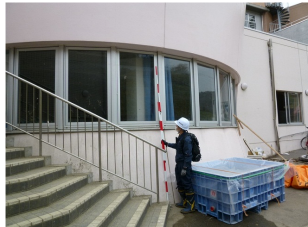
写真-3.3.1.20 老人福祉センター浸水痕（ポール先端部）
