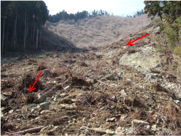
写真-3.3.1.25 左側の谷地形と摺り付き部
