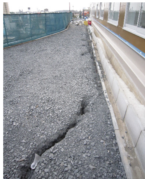
写真-3.3.1.1 建物沿いに入ったクラック
