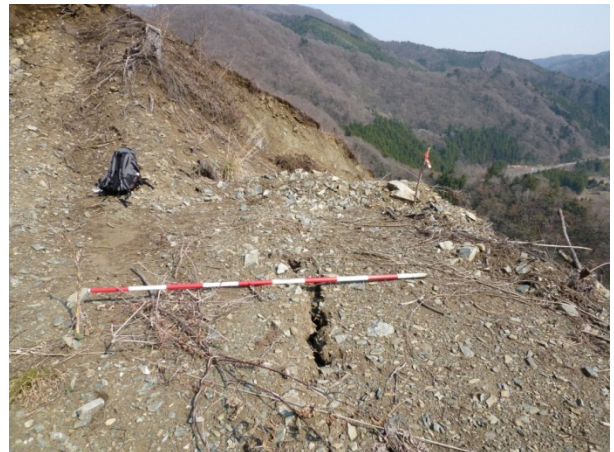
写真-3.3.1.32 斜面左側の作業道に見られたクラック
