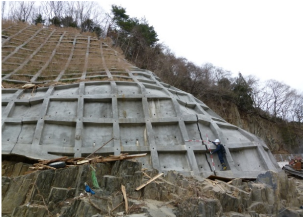
写真-3.3.1.13 法枠工目地部クラック (川尻地区)
