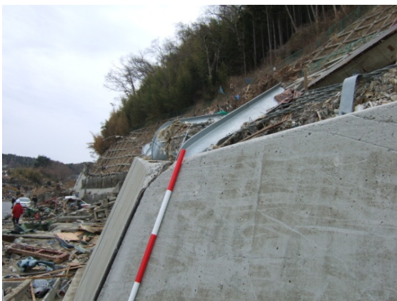
写真-3.3.1.15 擁壁工擦過痕
