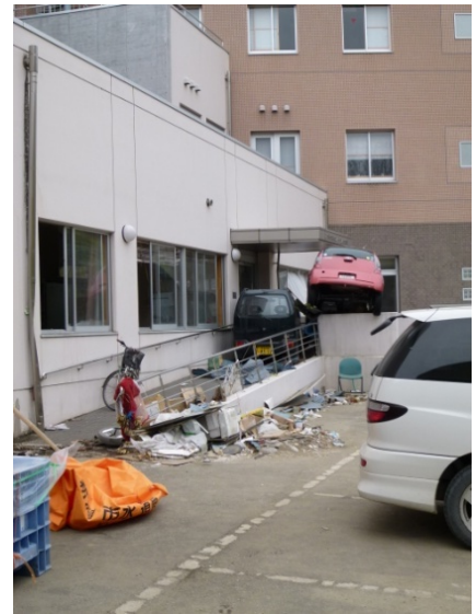
写真-3.3.1.19 老人福祉センター南側壁面
