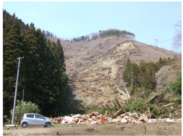
写真-3.3.1.23 崩壊全景
