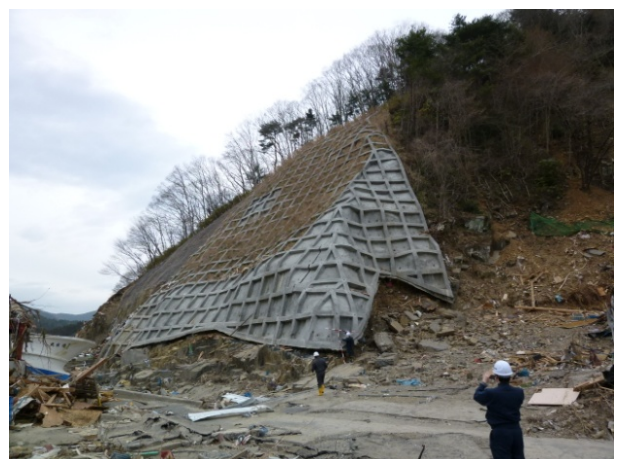
写真-3.3.1.12 法枠工脚部流出状況（川尻地区）
