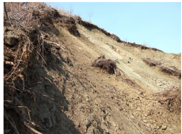
写真-3.3.1.24 崩壊源頭部 (中央部に露岩が見られる)
