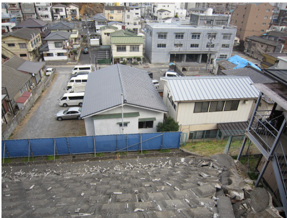
写真-3.3.1.4 斜面上端から斜面下方をのぞむ (のり枠工の破片が散乱している)
