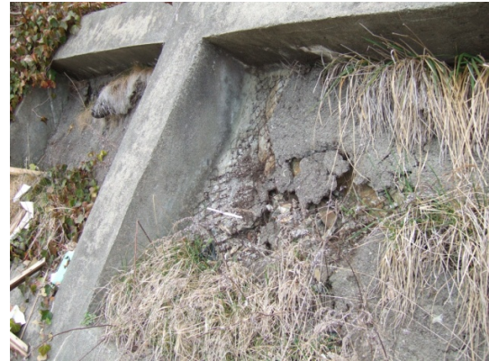
写真-3.3.1.16 吹き付け基材剥離状況
