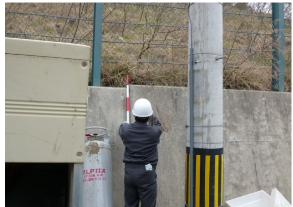
写真-3.3.1.10 擁壁工縦ズレ箇所
