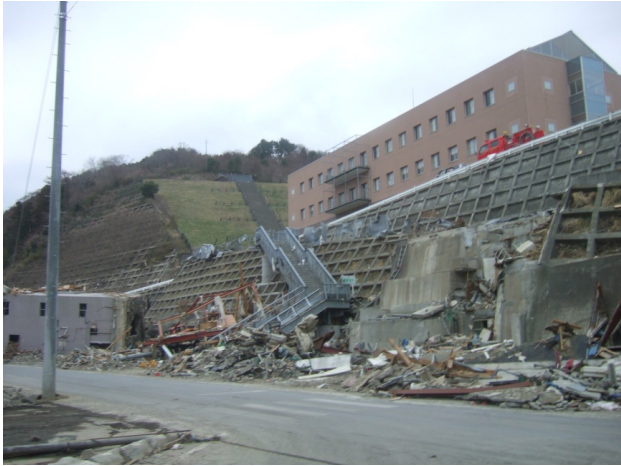
写真-3.3.1.22 津波避難用鋼製階段
