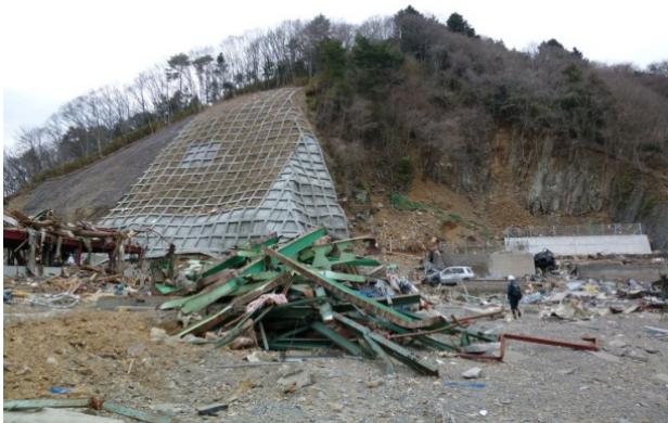
写真-3.3.1.8 法枠工右側の崩落（女川町）
