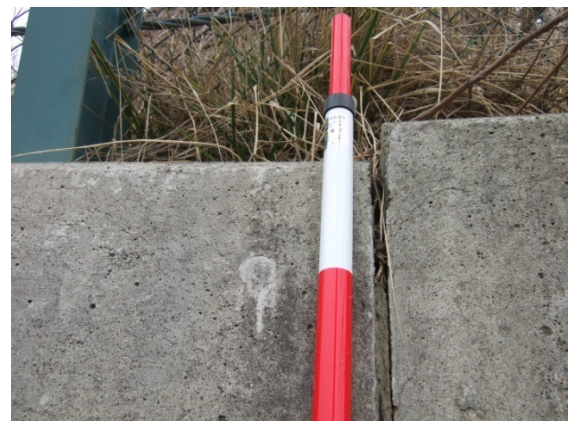
写真-3.3.1.11 擁壁工縦ズレ箇所（拡大）
