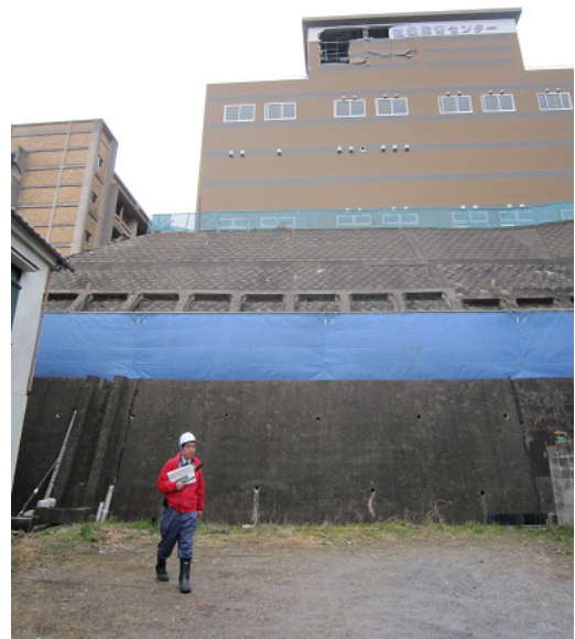
写真-3.3.1.6 擁壁工、のり枠工、張ブロック (擁壁に特に異常は見られず)
