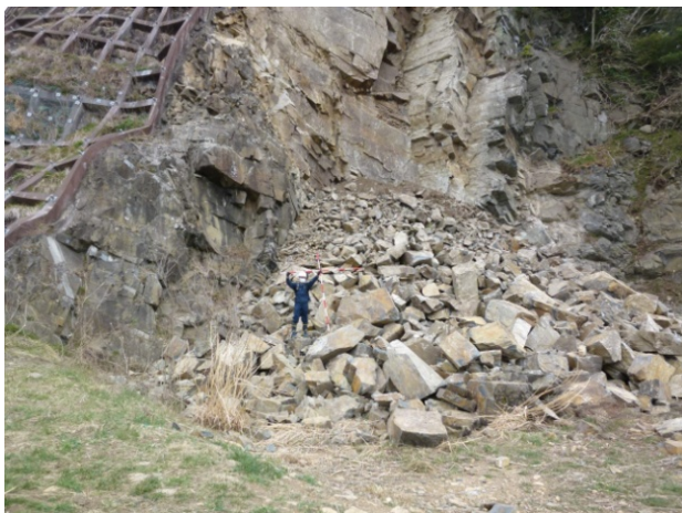
写真-3.3.1.9 法枠工右側の崩落（石巻市）
