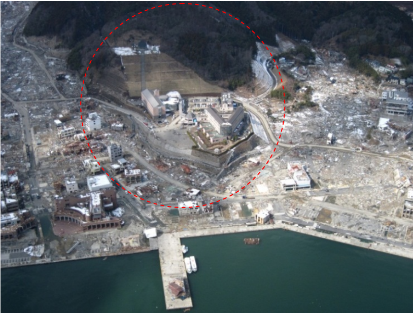
写真-3.3.1.18 堀切山特定利用斜面概況
