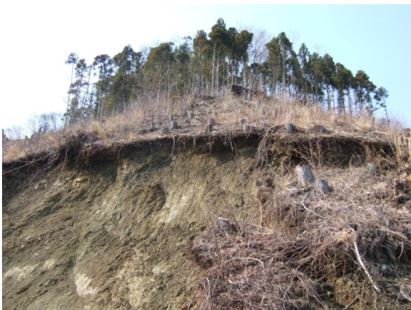
写真-3.3.1.31 最上部右側落ち残りのブロック
