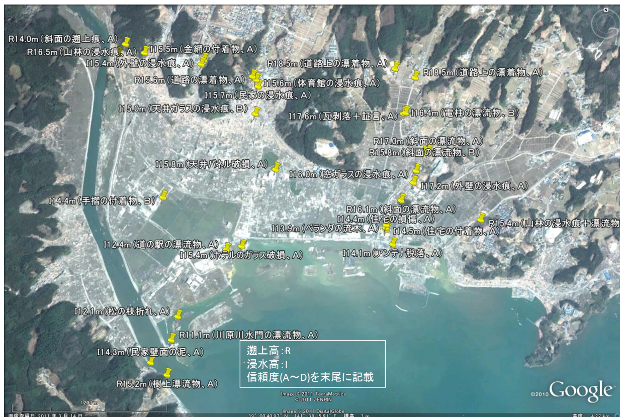
図-3.2.2.23 津波痕跡高調査測線（陸前高田）
