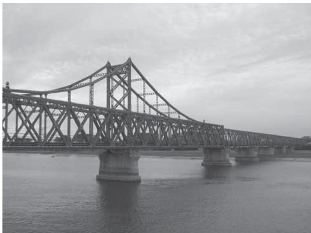
写真 A12-3 鴨緑江大橋と通過する海上コンテナ搭載車両（手前左側：中国，奥右側：北朝鮮）
