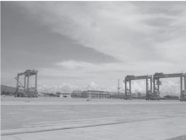
写真 A11-4 バタンガス港のコンテナヤード
