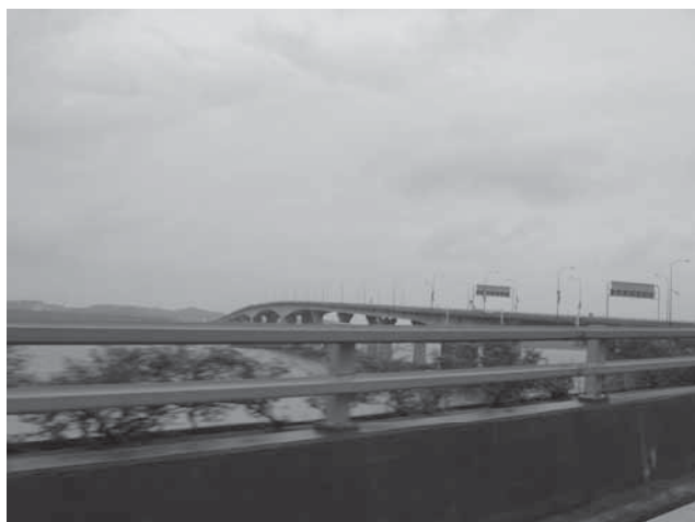
写真 A8-4 シンガポール・マレーシア国境を跨ぐ橋 (セカンド・リンク)
