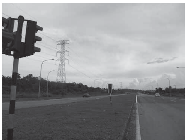
写真 A10-2 クチン港セナリ・ターミナル周辺の道路状況
