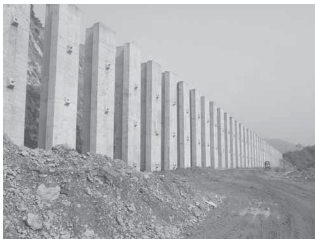
写真 A2-2 建設中の高速道路とその脇の一般道
