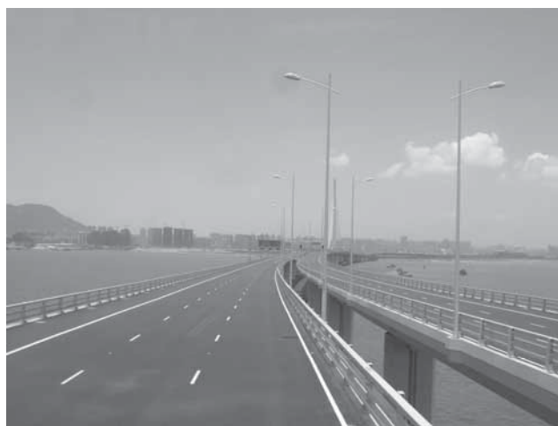
写真 A13-5 深圳湾大橋（香港側より中国本土側を望む， 2007年7月撮影）
