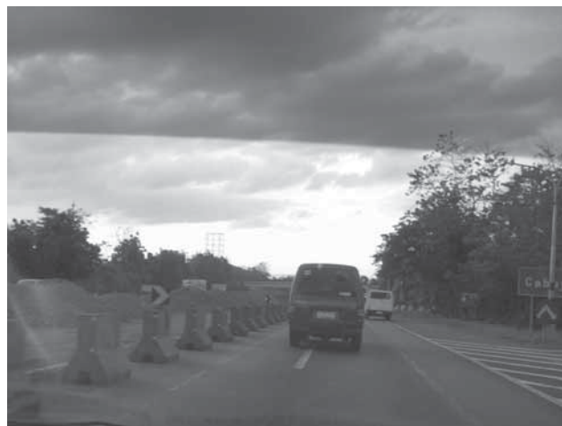
写真 A11-1 マニラ～カランバ間の高速道路（補修区間）
