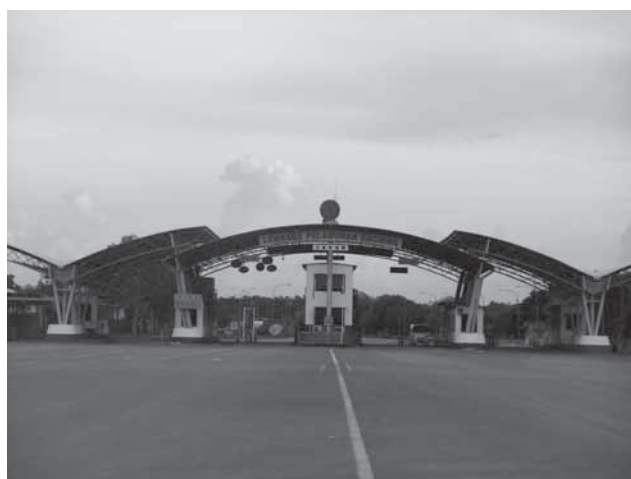
写真 A10-1 マレーシア・クチン港セナリ・ターミナル
