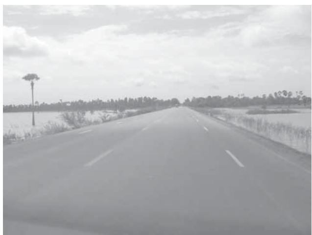
写真 A7-5 バナム～バベット間（カンボジア）の 道路状況
