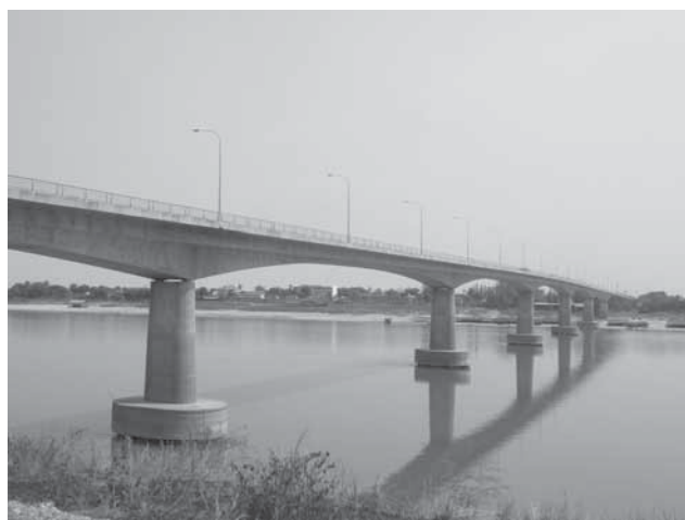
写真 A4-2 タイ・ラオス友好橋
