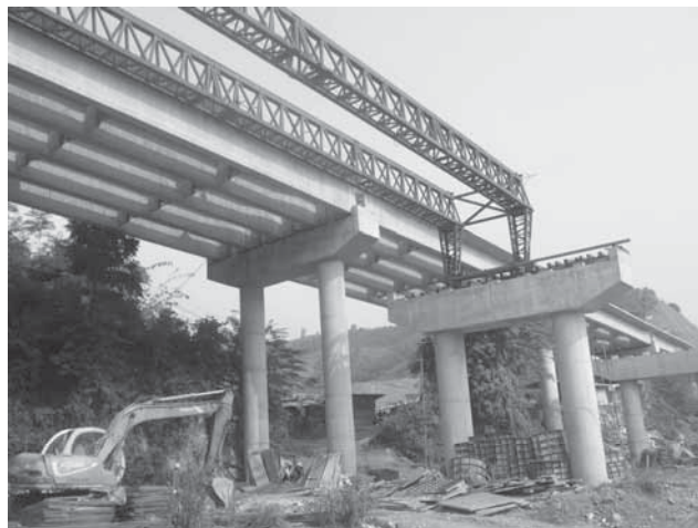
写真 A2-1 中国側国境付近における高速道路の建設状況
