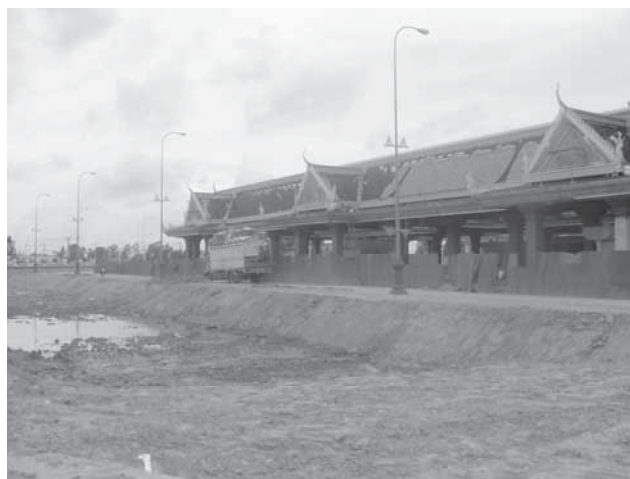
写真 A7-6 新規建設中のカンボジア税関と 脇の仮設道路を走行する物流車両
