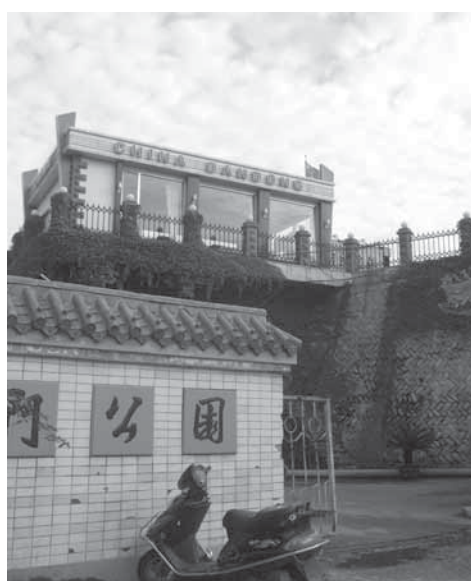
写真 A12-2 鴨緑江大橋の橋台部にある出入国ゲート
