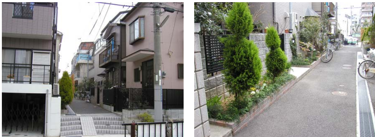
図9-3 神戸市泉通6丁目地区近隣住環境計画 （うるおいのある路地づくりタイプ）による整備の状況 （左：西側から見た計画区域、右：「うるおい空間」の状況）
