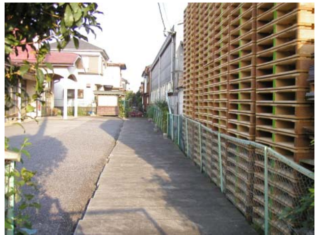
図11-14 蓋かけ整備された排水路敷の避難通路 (松伏町内前野地区)
