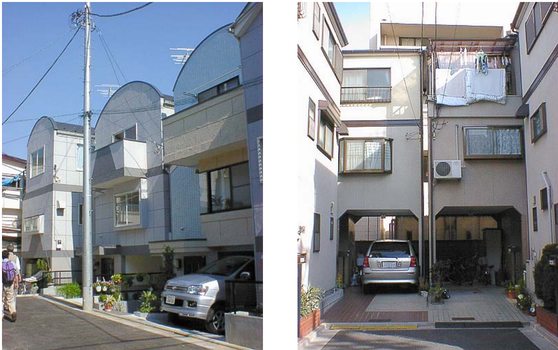
図 1-9 3階建てミニ開発住宅の事例 (左：東京都中野区の半地下形式の事例、右：大阪市の1階部分車庫の事例)
