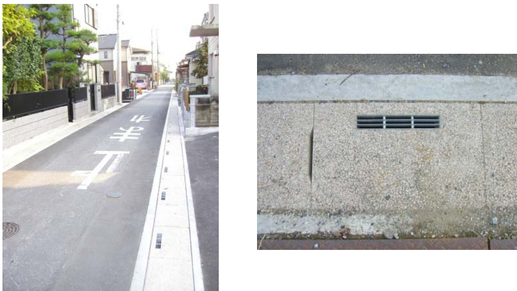
図11-12 側溝整備、門・塀の移設、生け垣整備の事例（左）と景観蓋（右） （松伏町内前野地区）
