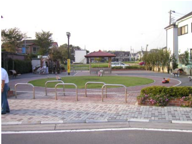
図11-13 完成した小公園 (松伏町内前野地区)
