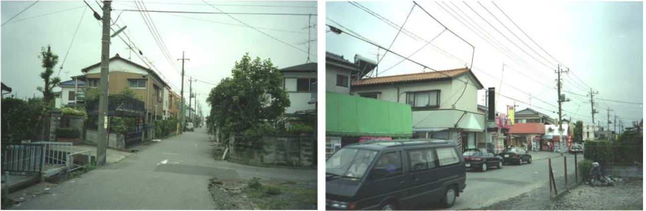
図11-7 前面道路の側溝が未整備の狭小住宅（左）と魅力の乏しい商店街（右） （松伏町内前野地区）
