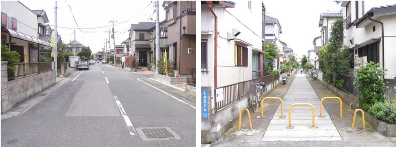
図11-5 6mに拡幅整備された市道（左）と歩行者空間化された旧農業用水路（右）
