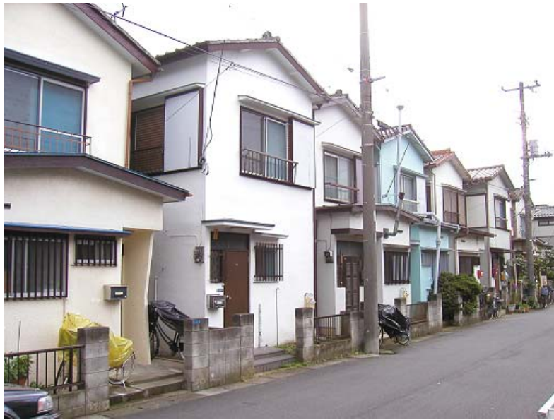
図11-4 建て替えの進まない小規模敷地の老朽住宅（春日部市備後東地区）
