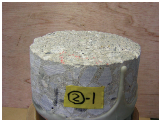
(a) 界面での破壊 (②工区)
