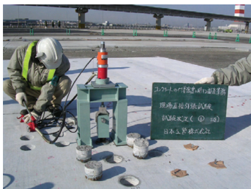
写真-6.1.1 現場直接引張試験実施状況
