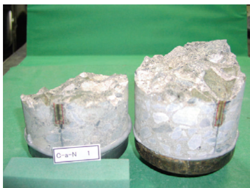
(c) 既設コンクリートでの破壊 (A-N 工区)
