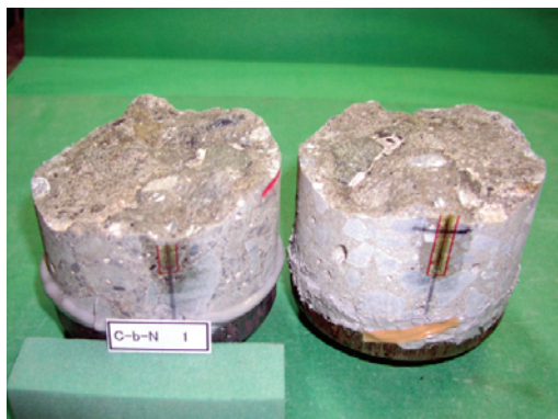
(b) 新旧両層に及ぶ破壊 (B-N 工区)
