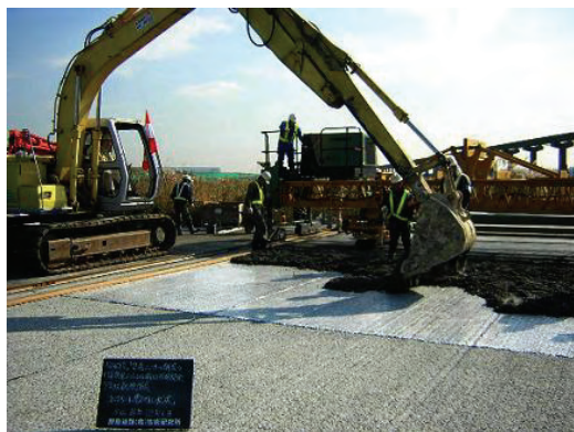
(a) 粗均し状況
