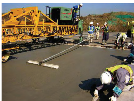
(d) フロート仕上げ状況
