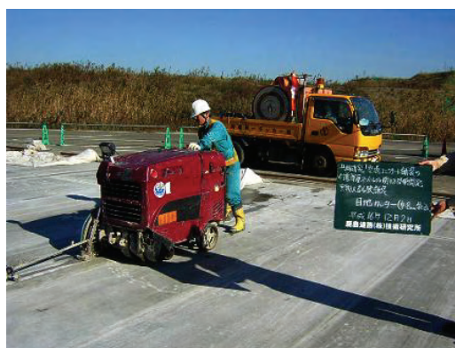
(g) カッター目地施工状況
