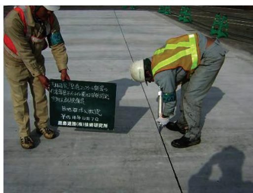
(h) 目地材注入状況
