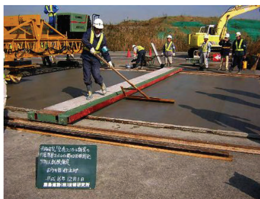
(f) ホウキ目仕上げ状況
