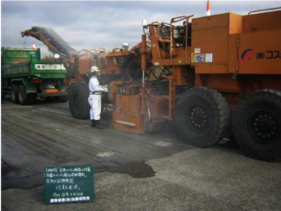
(a) 切削機による路面切削状況
