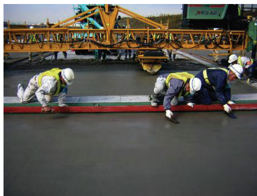
(e) 金ゴテ仕上げ状況
