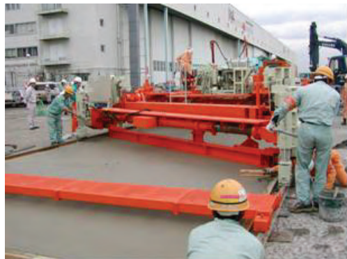
写真-4.2.12 コンクリートの平坦仕上げ（後部より）
