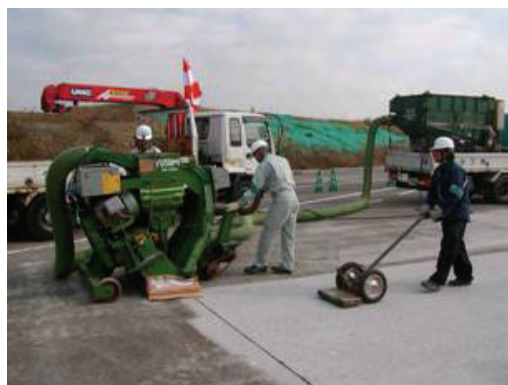
写真-4.2.16 SB 処理作業
