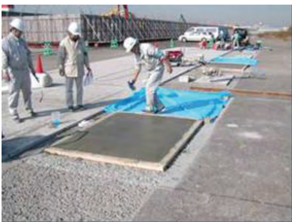
写真-4.2.19 コンクリート打設後の養生剤散布
