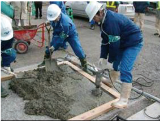
写真-4.2.18 テストピットのコンクリート打設と締固め
