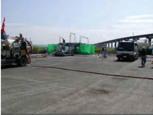
写真-4.2.2 WJ施工全景
