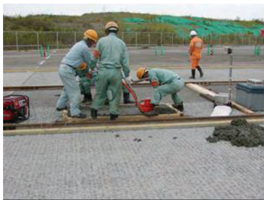
写真-4.2.15 テストピット部の打設
