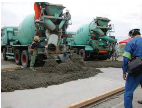
写真-4.2.9 コンクリートの荷卸し
