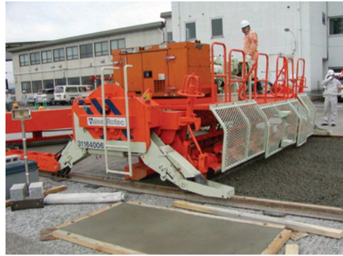
写真-4.2.11 コンクリートの締固め
