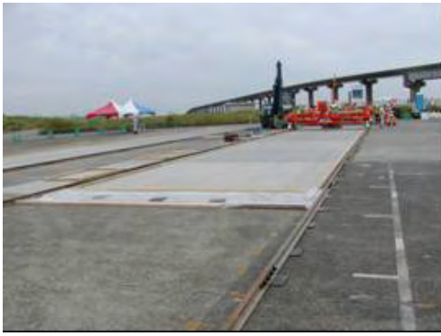
写真-4.2.8 コンクリート打設前
