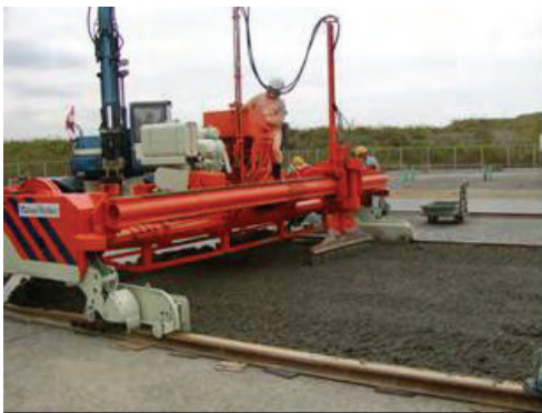
写真-4.2.10 コンクリートの敷きならし
