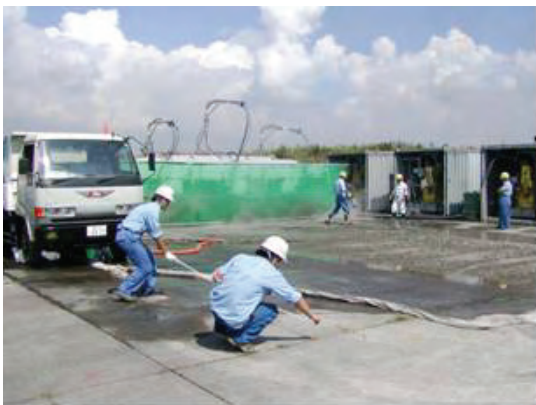
写真-4.2.4 WJ処理後の状況（後ろから）
