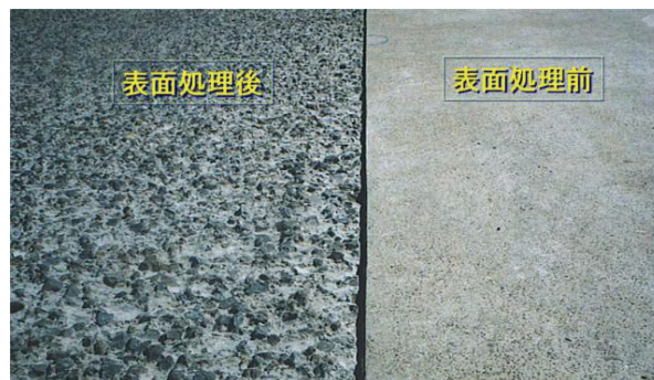
参考図-2.2.3 コンクリート表面処理の例
