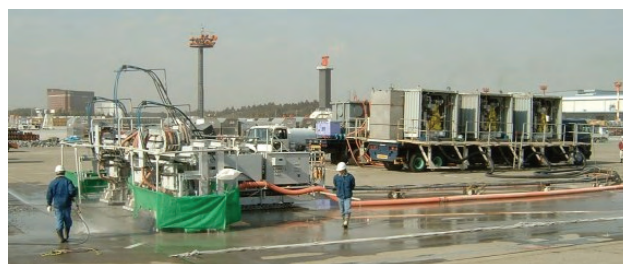
写真-2.2.1 超高压ポンプと表面処理機
