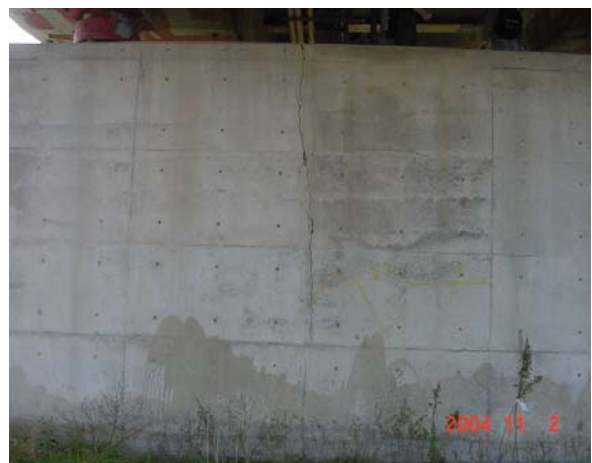
写真-8.2.37 P1 橋脚の垂直ひびわれ（越の大橋）
