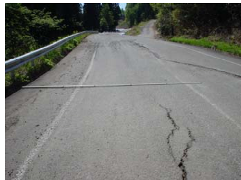
写真-8.3.47 天端の道路面の被害状況
