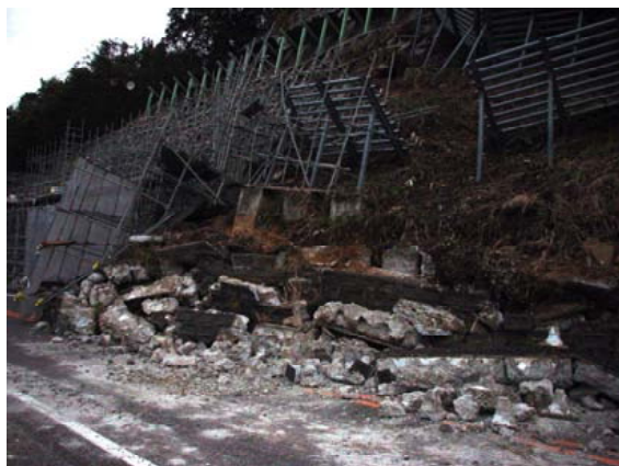
写真-8.3.29 ブロック積擁壁の倒壊（国道17号）
