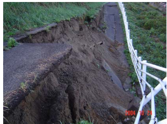
写真-8.3.3 のり面の崩壊状況（国道8号）
