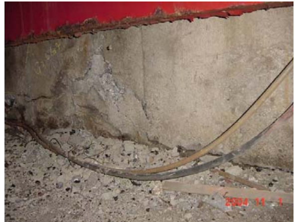
写真-8.2.35 橋台パラベットのひびわれ（和南津橋）
