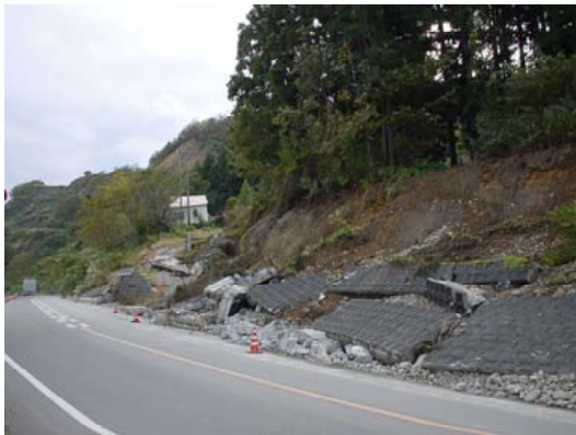
写真-8.3.31 ブロック積擁壁の倒壊（国道117号）
