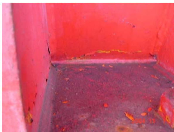
写真-8.2.32 支点上の桁ウェブ面のはらみ（堀之内橋）
