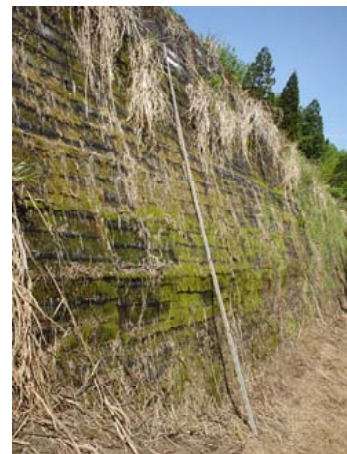
写真-8.3.48 ジオテキスタイル補強土壁の壁面の状態
