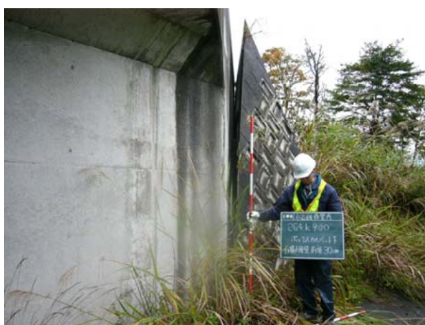
写真-8.3.53 地点 : 坑口擁壁間の開口 (30cm)
