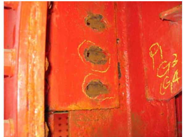
写真-8.2.36 P1-P2 ゲルバー部におけるボルトの破損（和南津橋）
