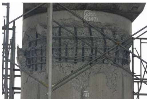
写真-8.2.4 P5橋脚の断面損傷状況（拡大）
