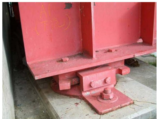
写真-8.2.56 可動支承上沓の変位制限ストッパー部分の変形（宇賀地橋）
