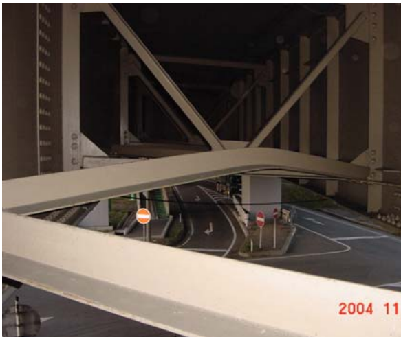
写真-8.2.40 連続鈑桁における対傾構・下横構の変形(十日町高架橋)
