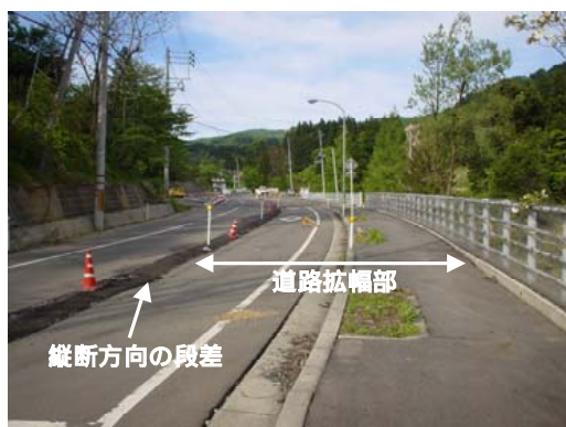
写真-8.3.43 道路面の損傷
