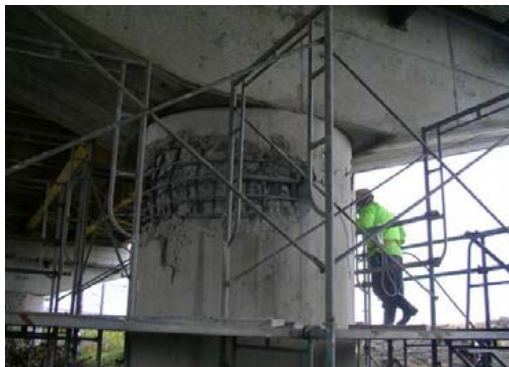
写真-8.2.3 P5橋脚の断面損傷状況
