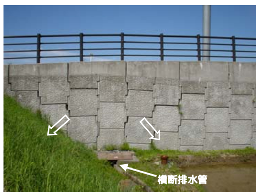
写真-8.3.42 横断排水管周辺の不同沈下
