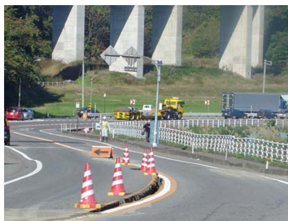
写真-8.3.7 片切片盛部の路面変状 (国道17号)
