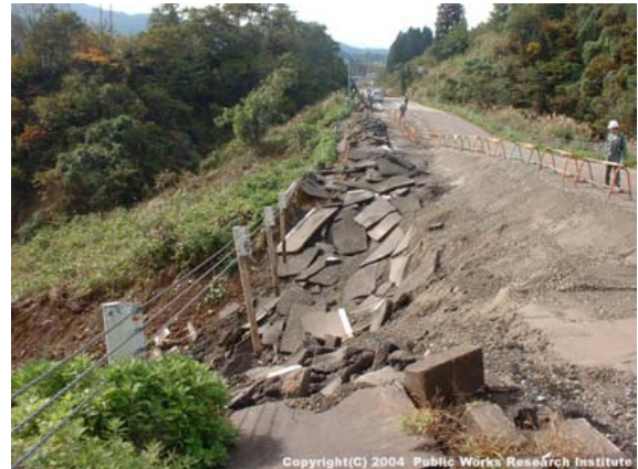
写真-8.3.17 盛土のり面の崩壊状況（国道117号）
