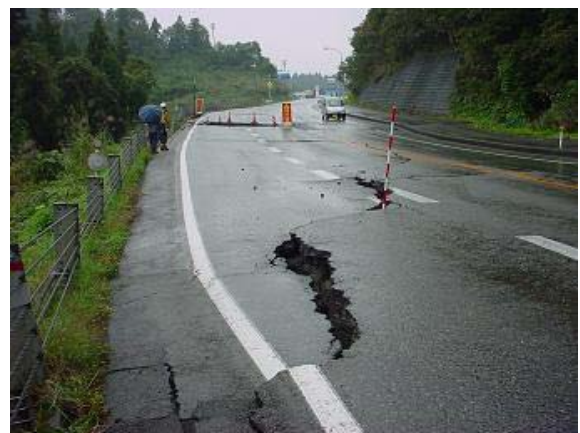
写真-8.3.9 路面の変状（国道17号）
