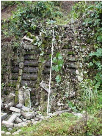
写真-8.3.38 井桁組擁壁の破壊例
