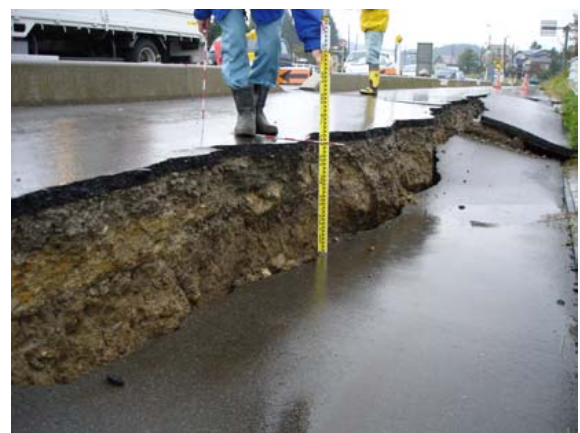
写真-8.3.5 歩道部の沈下の状況 (国道8号)
