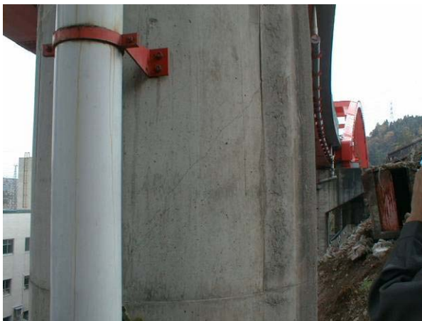
写真-8.2.23 P3橋脚短柱側面の斜めひびわれ
