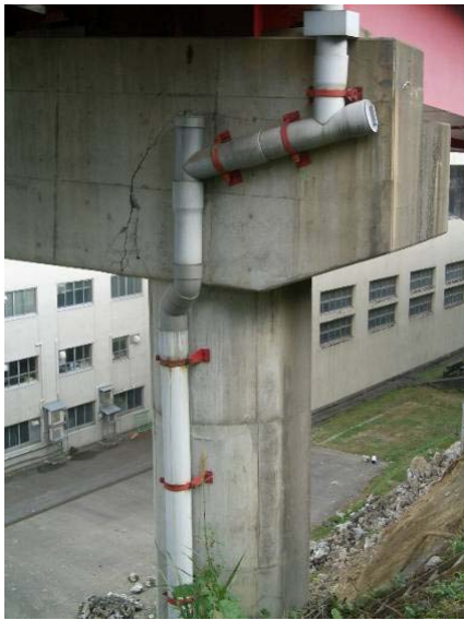
写真-8.2.22 P3橋脚梁部のひびわれ
