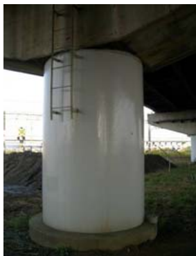
写真-8.2.2 上り線橋脚の鋼板巻立て補強
