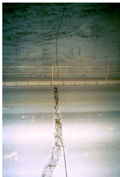
写真-8.4.5 木沢トンネルの被害状況 （舗装版のひび割れ）
