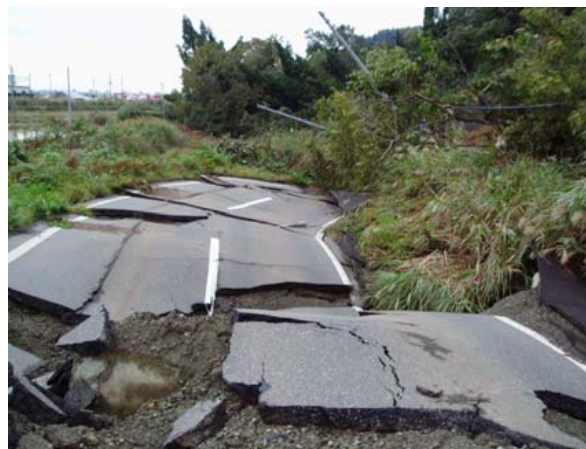
写真-8.3.61 南側の崩壊により押し出された道路 (Loc.3)
