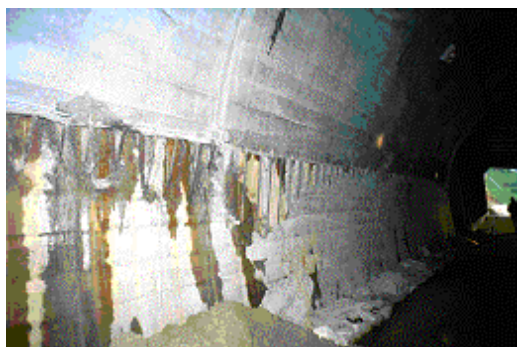
写真-8.4.10 十二平トンネルの被害状況 (側壁部の圧壊)
