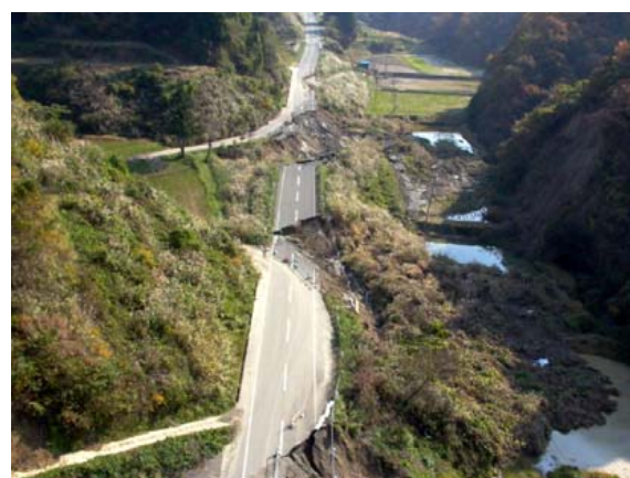
写真-8.3.27 沢埋め盛土の崩壊状況の空中写真（小国町法末）
