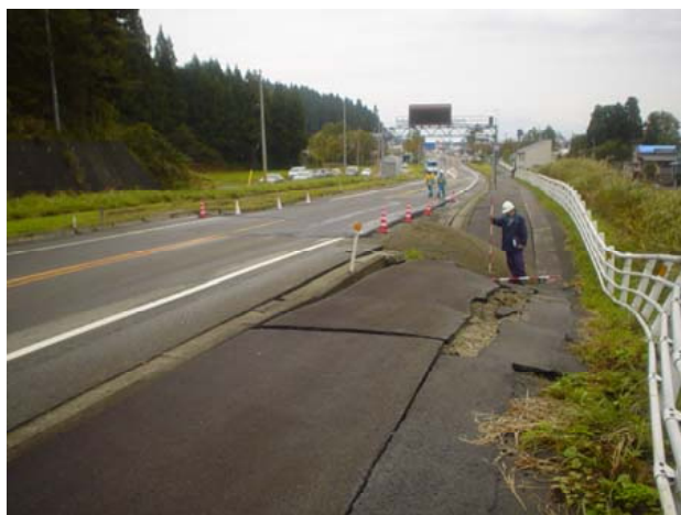
写真-8.3.51 地点 : 上部盛土の沈下 (60cm)
