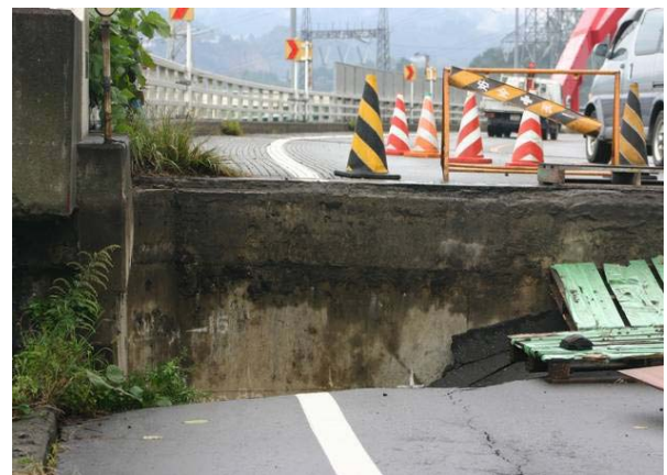
写真-8.2.26 A2橋台背面盛土の沈下
