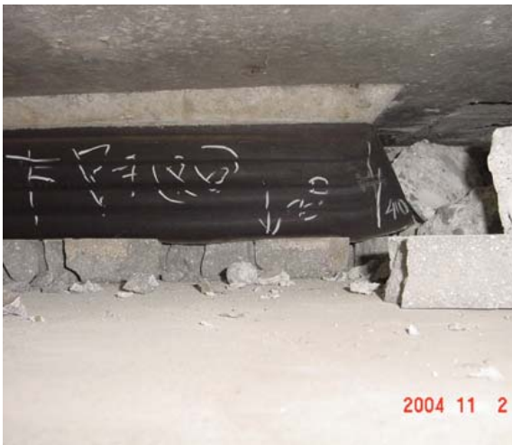
写真-8.2.39 ゴム支承の変形(十日町高架橋)
