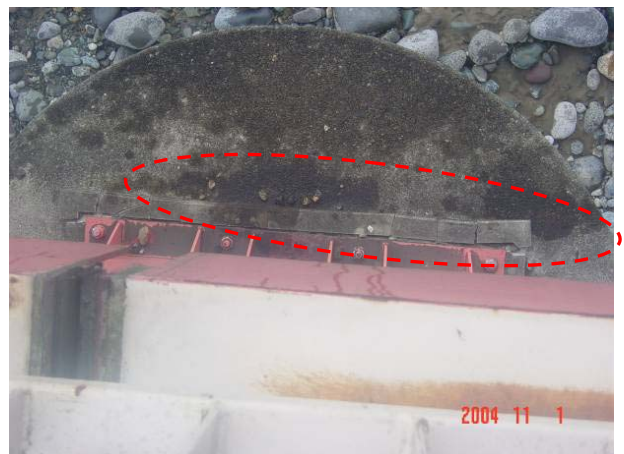
写真-8.2.55 沓座モルタルの損傷（姿大橋）
