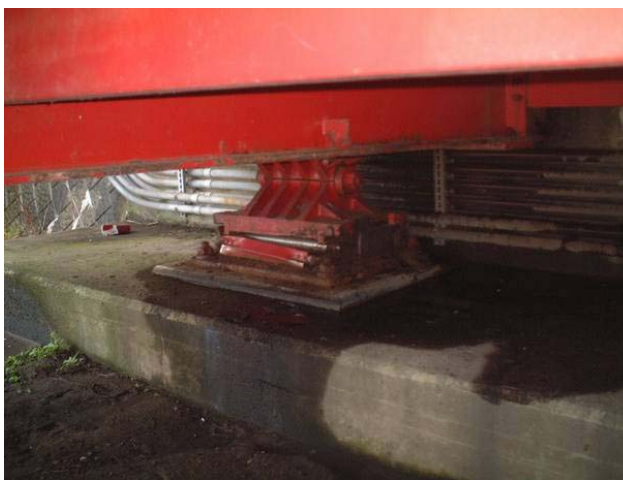
写真-8.2.12 可動支承の損傷状況 (A2 橋台)
