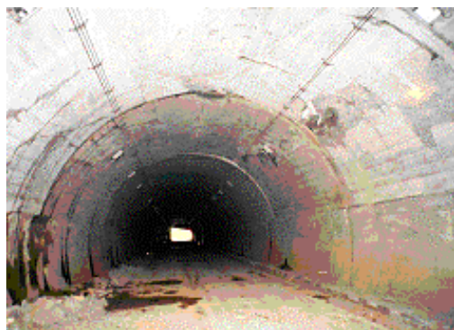
写真-8.4.9 十二平トンネルの被害状況 (アーチ肩部の圧さ、側壁部の剥落)
