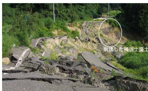
写真-8.3.25 盛土の崩壊状況（国道290号）
