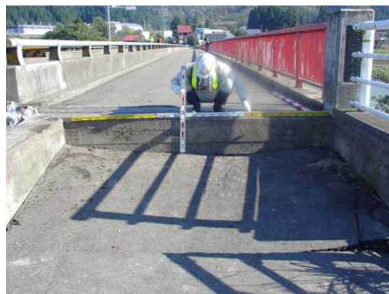
写真-8.3.6 橋梁取付部の段差状況 (国道17号)
