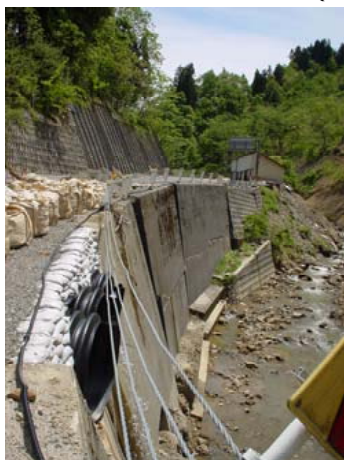
写真-8.3.35 もたれ式擁壁の被災例（国道291号）
