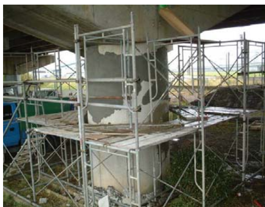
写真-8.2.5 モルタルによる断面修復後の状況（P5橋脚、この後に炭素繊維シート巻立て）
