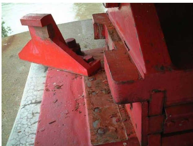
写真-8.2.13 支承サイドブロックの損傷(P6橋脚上)
