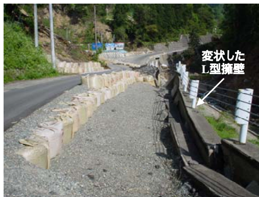
写真-8.3.36 盛土上のL型擁壁の被害例
