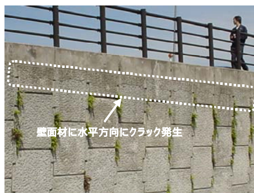
写真-8.3.41 壁面材のクラックの発生
