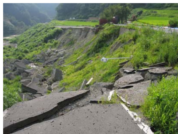
写真-8.3.28 盛土の崩壊状況（小国町法末）
