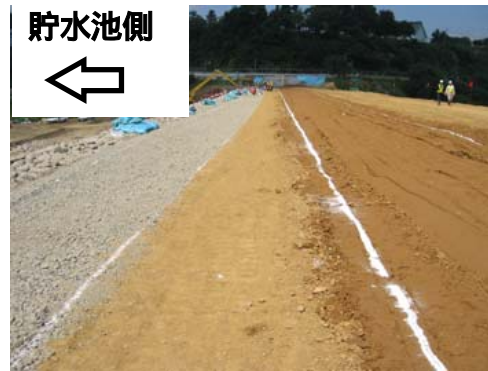
写真-7.6 粗粒フィルター～さや土～心壁材 (浅河原調整池)
