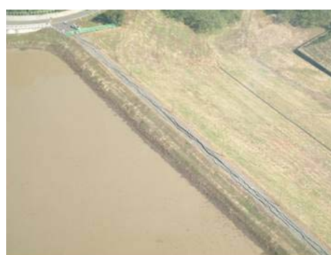
写真-7.4 地震後の水位上昇 (北陸地方整備局撮影) (浅河原調整池)
