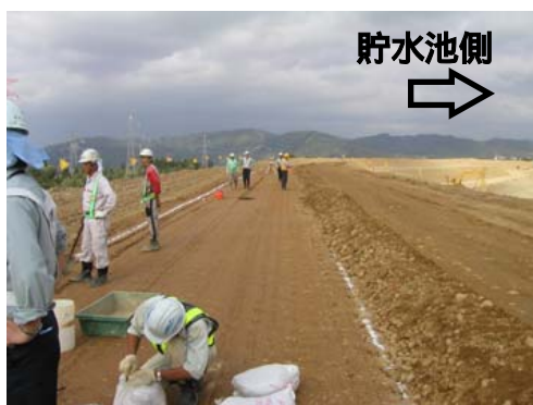
写真-7.13 コアゾーン全景 (新山本調整池)
