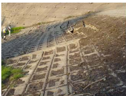
写真-7.27 上流のり面の変状（川西ダム）
