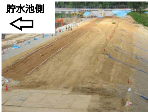
写真-7.5 堤体全景 (浅河原調整池)
