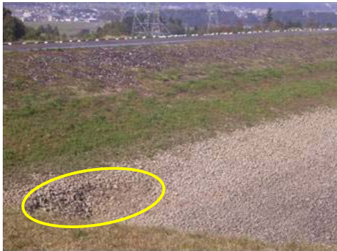
写真-7.11 貯水池側のり面リップラップの 段差 (新山本調整池)
