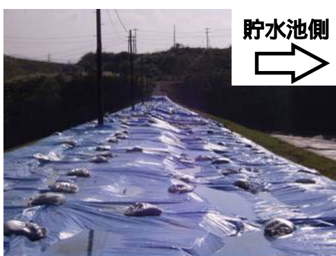
写真-7.3 天端亀裂のブルーシートによる保護 (浅河原調整池)
