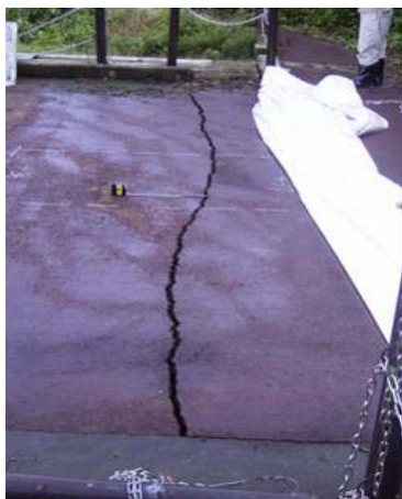
写真-7.23 天端の上下流方向に発生した亀裂 (長福寺ダム)
