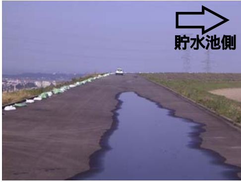
写真-7.9 天端舗装面の傾斜 (新山本調整池)
