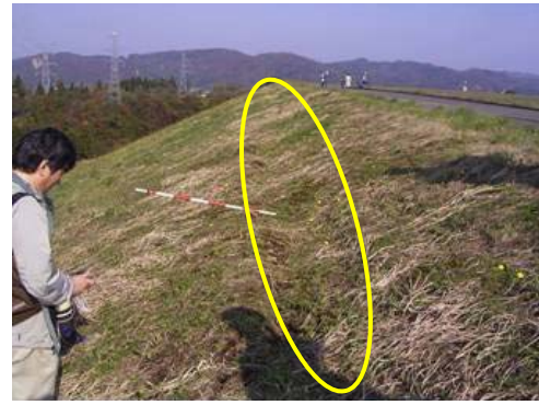
写真-7.10 貯水池外側のり面陥没 および亀裂 (新山本調整池)
