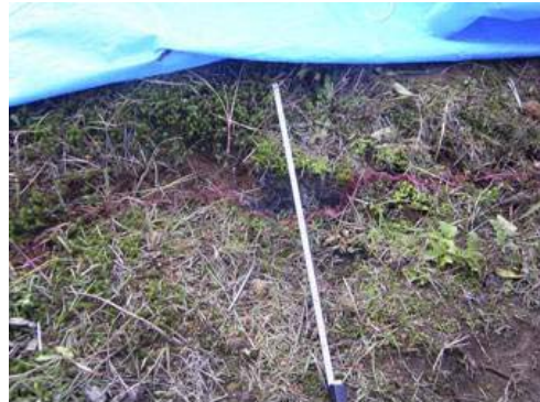
写真-7.26 下流のり面の亀裂 (坪山ダム)
