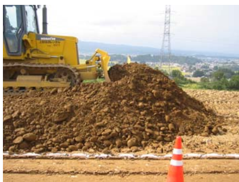
写真-7.15 フィルター材撒出し (新山本調整池)
