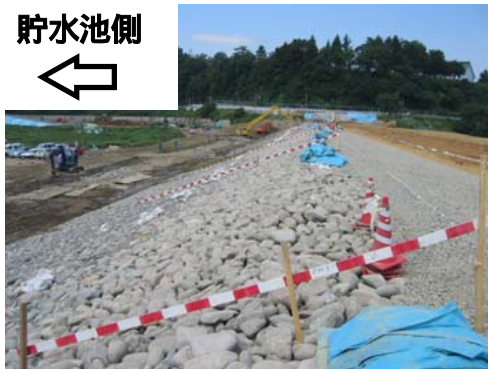
写真-7.7 上流側捨石工 (浅河原調整池)
