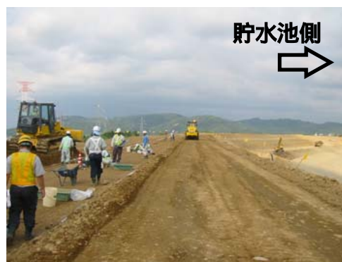
写真-7.14 フィルターゾーン全景 (新山本調整池)
