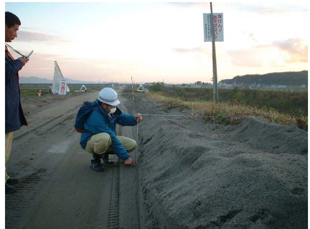
(b)のり肩と天端の段差
