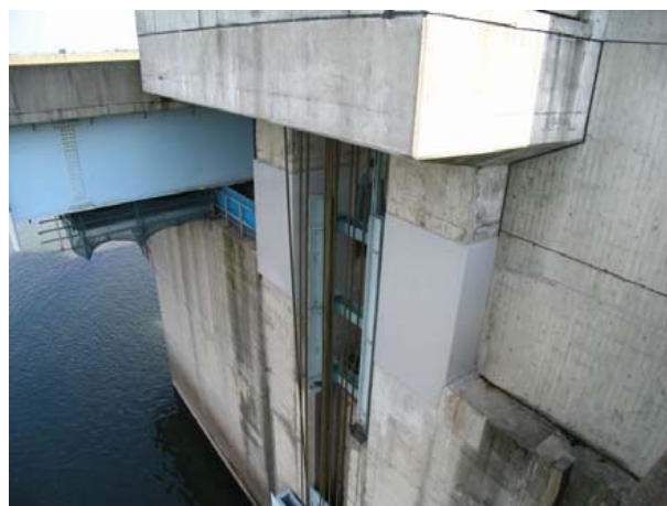
(a)門柱への鋼板巻付け
