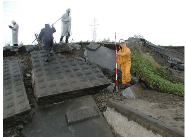
写真-6.9 信濃川左岸妙見堰上流の低水護岸の損壊
