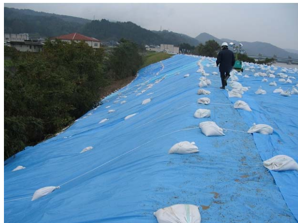
写真-6.14 緊急復旧完了後の状況（長岡市三俵野地先）
