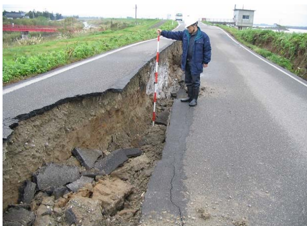
(a) 堤防天端の縦断亀裂と段差
