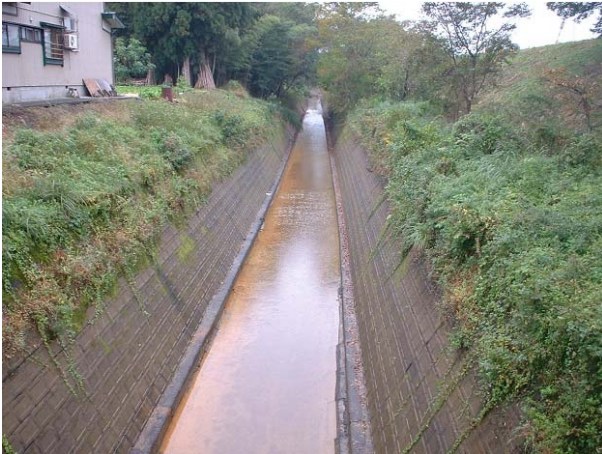
写真-6.5 信濃川右岸堤防29.0km付近（長岡市三俵野地先）のすべり崩壊箇所と並行する水路（茂みの向こう側が崩壊した区間）
