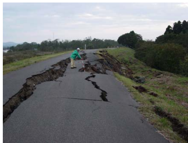
写真-6.4 信濃川右岸堤防29.2km付近(長岡市三俣野地先)のすべり崩壊(北陸地方整備局撮影)
