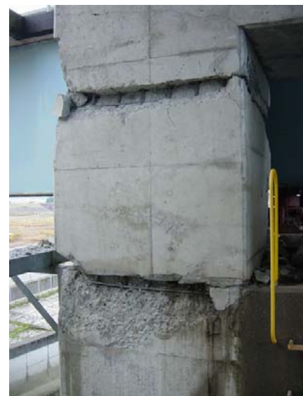
(b)P8 左岸・下流側 写真-6.7 妙見堰の門柱の損傷
