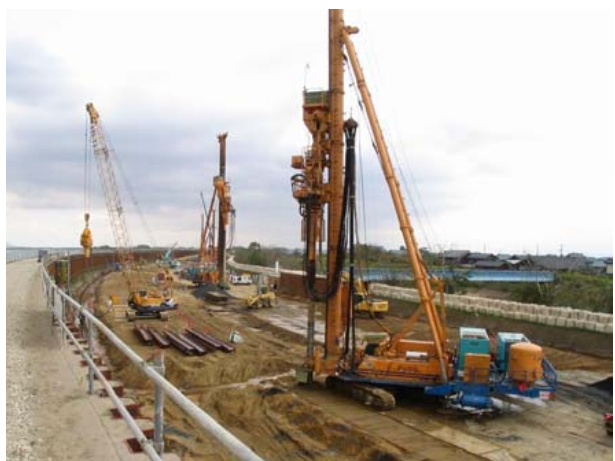
写真-6.12 サンドコンパクションパイル工法による 液状化対策（長岡市中条地先）
