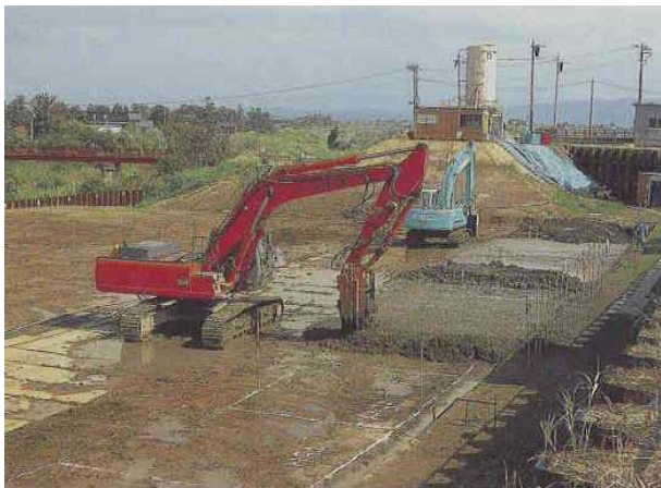
写真-6.13 表層安定処理工法施工状況（長岡市本与坂地先）（北陸地方整備局撮影） 3)
