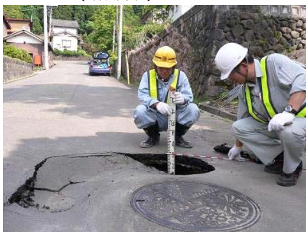
写真-5.9 マンホール付近の陥没 (旧長岡市)
