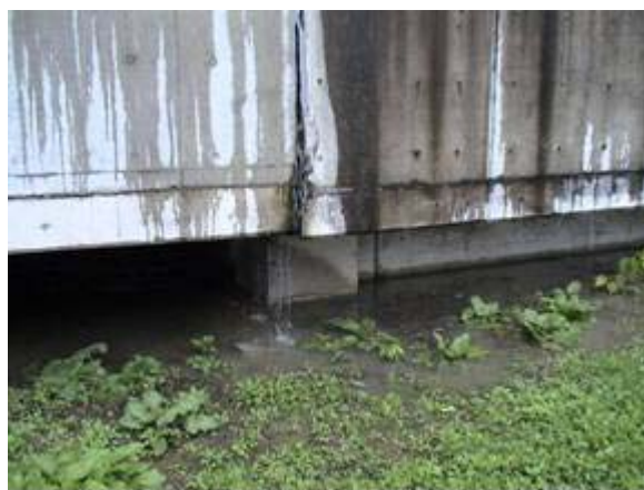
写真-5.1 水処理施設のひび割れ
