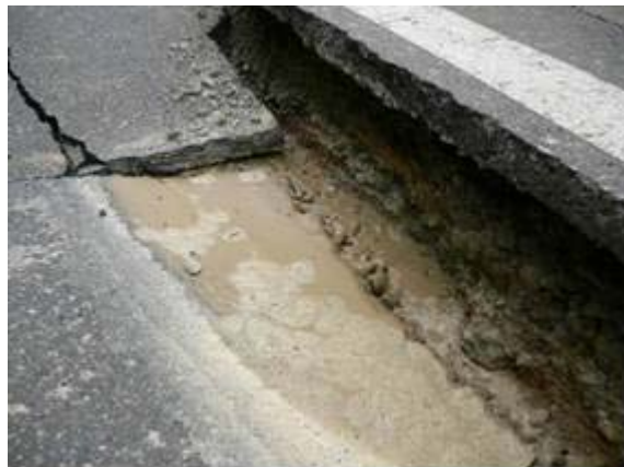
写真-5.5 アスファルトの割れ目からの噴砂 (小千谷市)
