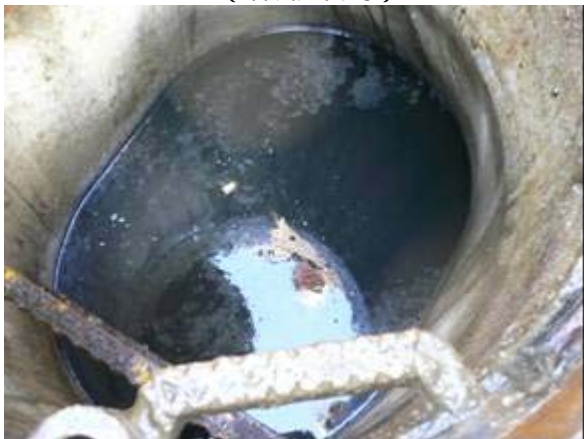
写真-5.8 マンホール内の滞水状況 (旧堀之内町)
