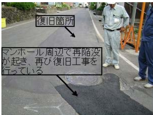
写真-5.10 管路上の陥没 (旧長岡市)
