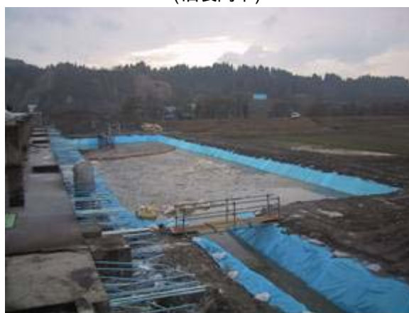
写真-5.13 仮設沈殿池 (堀之内浄化センター)
