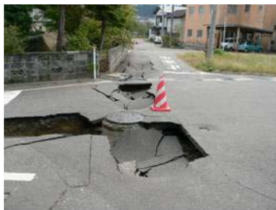
写真-5.3 管路埋設路線上の地盤沈下 (小千谷市)
