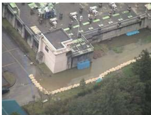
写真-5.2 流入管渠破断による下水の漏水
