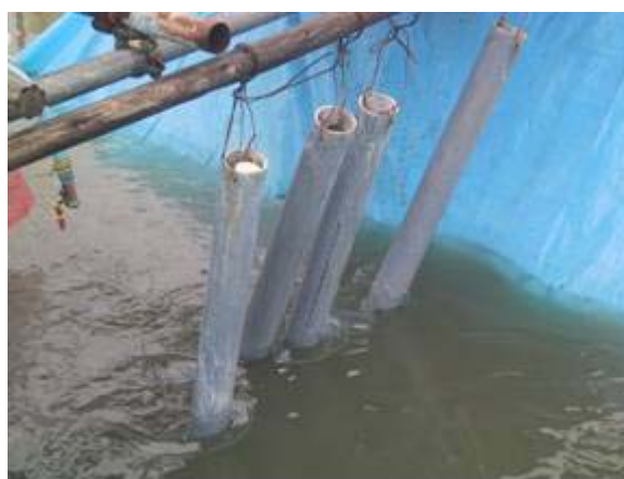
写真-5.15 固形塩素の供給 (堀之内浄化センター)
