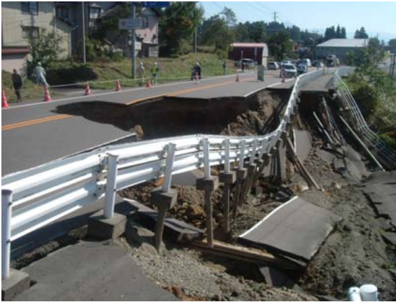
写真-8.3.14 崩壊した道路（国道17号）
