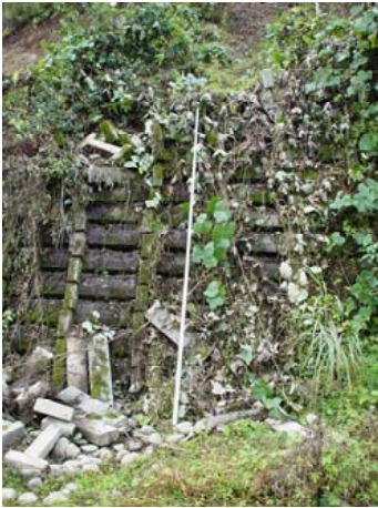
写真-8.3.38 井桁組擁壁の破壊例
