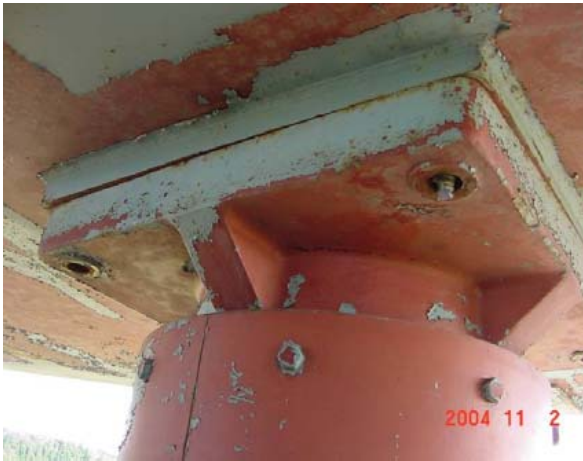
写真-8.2.38 ピボット支承セットボルトの破損 (越の大橋)
