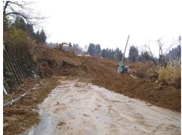
写真-8.3.58 被災1ヶ月後の道路の状況 (loc.1)
