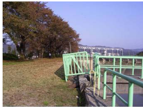
写真-7.18 取水設備周辺の地盤変状 (山本調整池)
