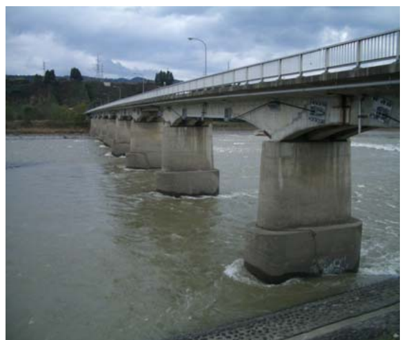
写真-8.2.43 橋軸直角方向の変位制限構造のはずれ(十日町橋)
