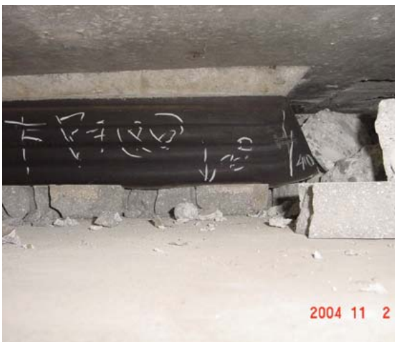
写真-8.2.39 ゴム支承の変形(十日町高架橋)
