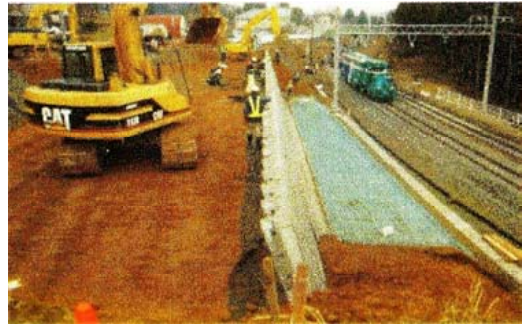
写真-8.3.50 補強土擁壁の道路復旧への適用例
