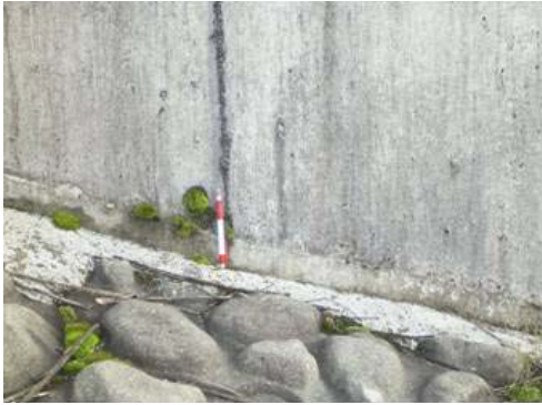
写真-7.25 洪水吐と張りブロック間の沈下 (坪山ダム)
