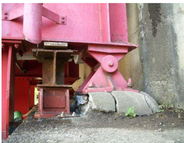
写真-8.2.46 左岸側橋台部支承部の損傷状況 (宮中橋)
