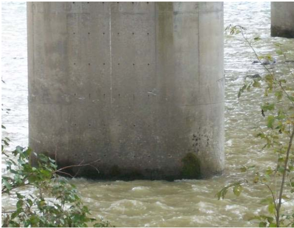
写真-8.2.51 橋脚に生じた水平ひびわれ（根小屋橋）
