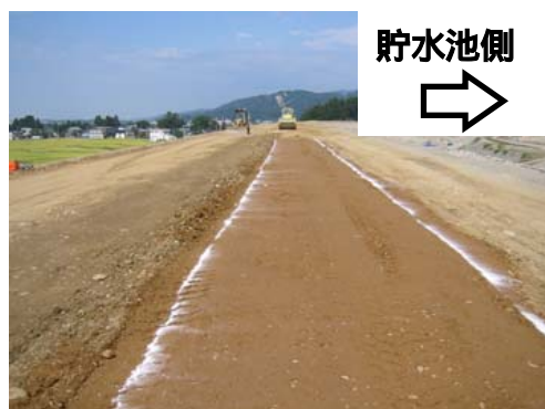
写真-7.19 コアゾーン全景 (山本調整池)
