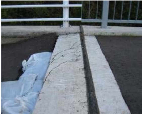
写真-8.2.30 橋台パラペットのひびわれ (観音橋側道橋)
