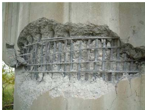
写真-8.2.9 P2橋脚の損傷状況（拡大：P1側）
