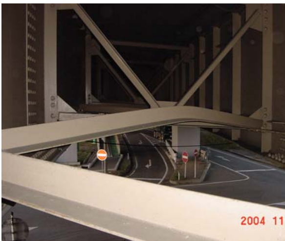
写真-8.2.40 連続鈹桁における対傾構・下横構の変形(十日町高架橋)
