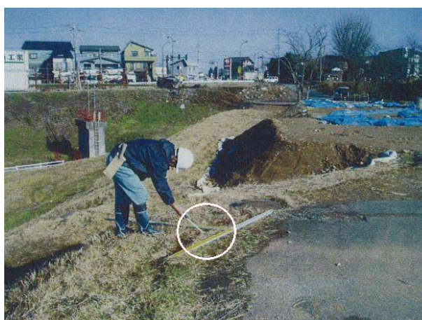
写真-6.11 継ぎ手部上部の盛土に発生した亀裂 (北陸地方整備局撮影)
