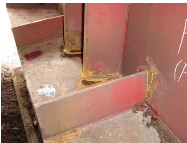
写真-8.2.15 箱桁端部支承上補剛構造の損傷状況 (P4 橋脚上)
