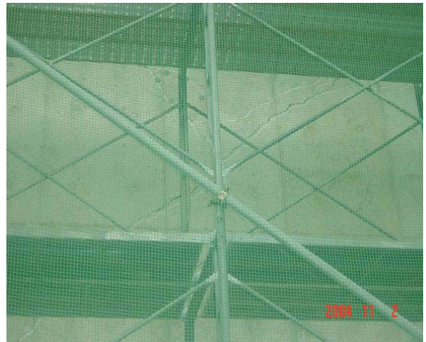
写真-8.2.49 固定橋脚に生じたせん断ひびわれ（芋川橋）
