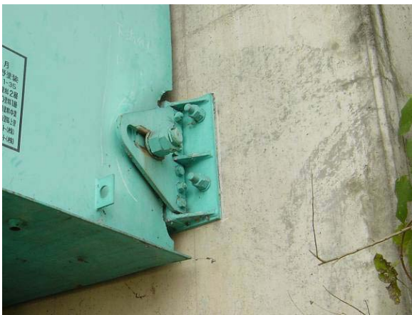
写真-8.2.58 橋台部落橋防止装置の変形状況（川井大橋）
