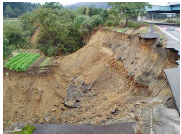
写真-8.3.59 被災直後の道路の状況 (loc.2)
