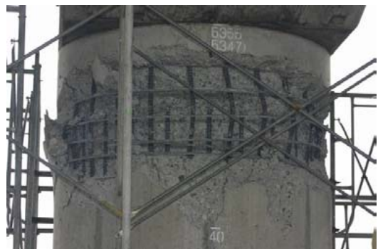
写真-8.2.4 P5橋脚の断面損傷状況（拡大）
