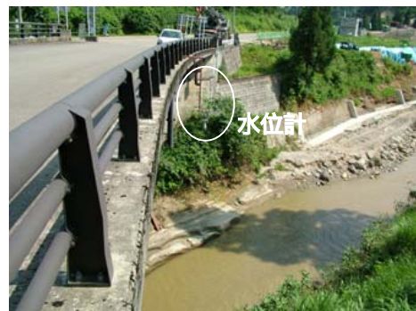
写真-4.23 水位計の設置状況（平成17年8月2日撮影）
