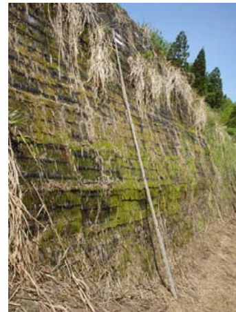
写真-8.3.48 ジオテキスタイル補強土壁の壁面の状態
