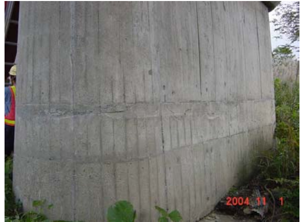
写真-8.2.33 P2 橋脚の水平ひびわれ (堀之内橋)
