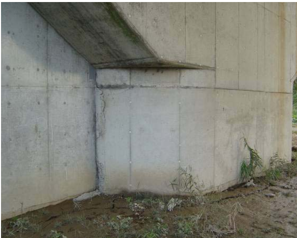
写真-8.2.47 RC 壁連結部でのかぶりコンクリートの剥離（大手大橋）
