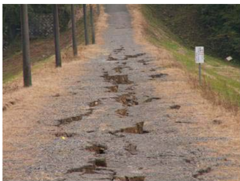
写真-7.1 天端亀裂近景 (浅河原調整池)
