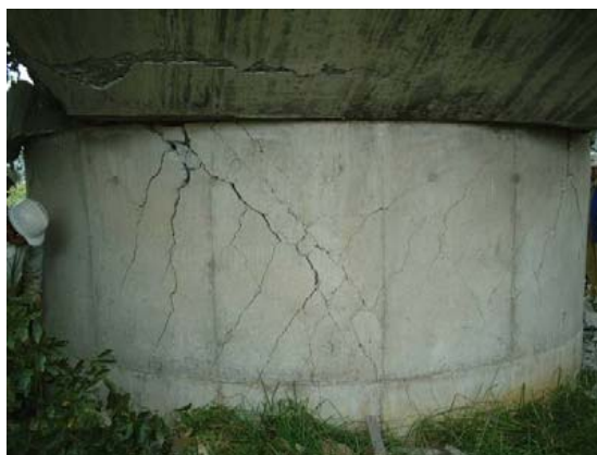
写真-8.2.10 P2橋脚の損傷状況（拡大：上流側）
