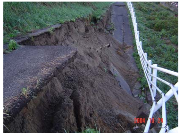
写真-8.3.3 のり面の崩壊状況（国道8号）
