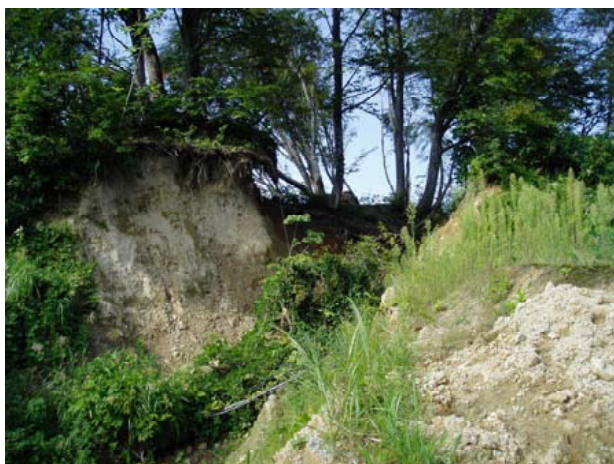
写真-4.3 地すべり斜面上部の陥没帯 (北東方向を望む)
