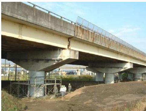
写真-8.2.1 新組跨線橋（手前が下り線）
