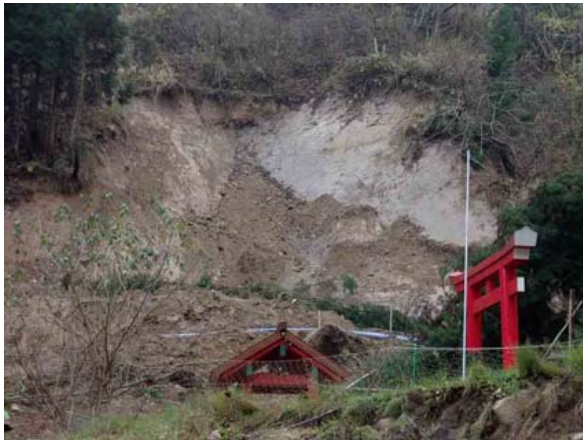
写真-8.3.68 崩壊直後の斜面の状況 (loc.6)
