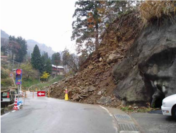
写真-8.3.74 被災1ヶ月後の道路の状況 (loc.9)
