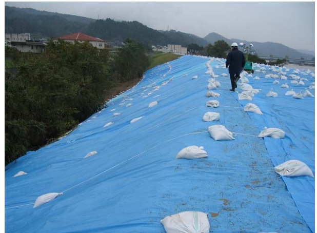
写真-6.14 緊急復旧完了後の状況（長岡市三俣野地先）
