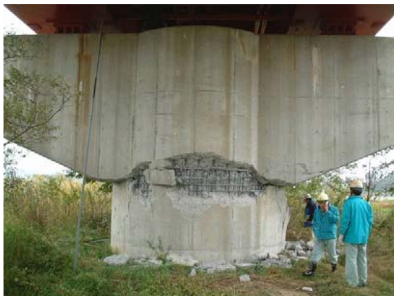
写真-8.2.8 P2橋脚の損傷状況
