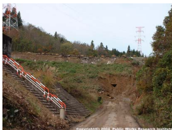
写真-8.3.19 崩壊土によるアンダーパス道路の閉塞
