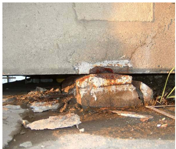
写真-8.2.42 桁コンクリートおよび支承沓座モルタルの剥離(栄橋)
