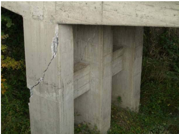
写真-8.2.57 ラーメン柱部に生じたせん断ひびわれ（浦柄橋旧橋）
