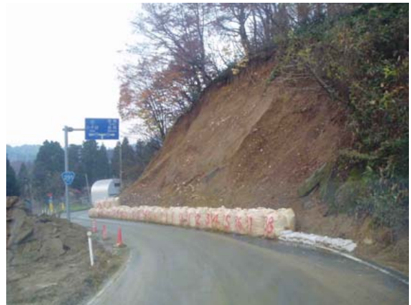
写真-8.3.72 被災1ヶ月後の道路の状況 (loc.8)
