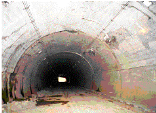
写真-8.4.9 十二平トンネルの被害状況 (アーチ肩部の圧ざ、側壁部の剥落)
