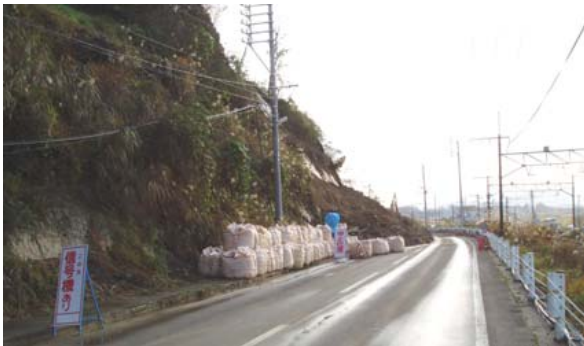
写真-8.3.69 被災1ヶ月後の道路の状況 (loc.7)
