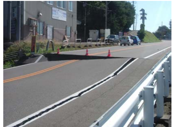
写真-8.3.10 盛土の沈下に伴う路面段差の状況（国道17号）
