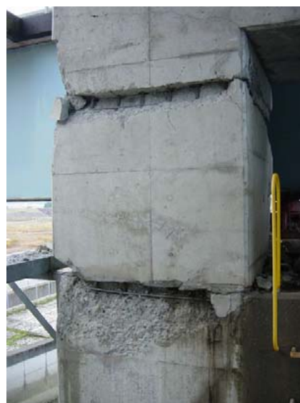
(b)P8 左岸・下流側 写真-6.7 妙見堰の門柱の損傷
