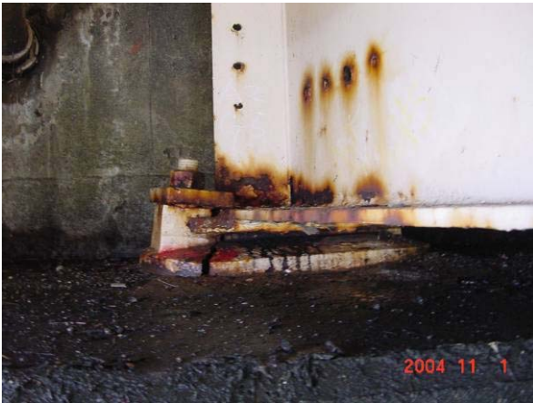
写真-8.2.31 A2 橋台部支承下沓のわれ (新佐梨橋)
