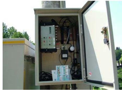
写真-4.22 データロガーの設置状況（平成17年4月14日撮影）
