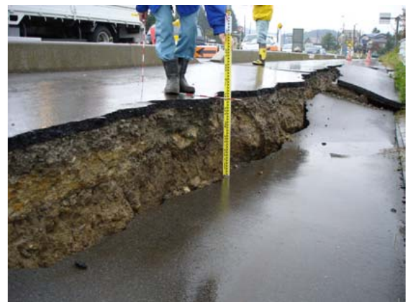
写真-8.3.5 歩道部の沈下の状況 (国道8号)
