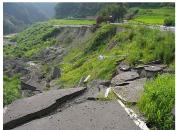
写真-8.3.28 盛土の崩壊状況（小国町法末）
