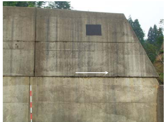
写真-4.13 打継目にずれが生じた事例
