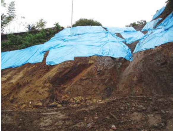
写真-8.3.66 崩壊直後の斜面の状況 (loc.5)
