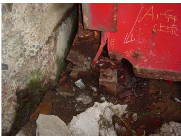
写真-8.2.34 A1 橋台上主桁の損傷（和南津橋）
