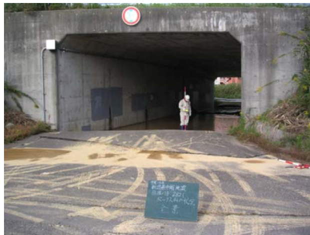
写真-8.3.54 地点 : 取付道路の隆起 (70cm)
