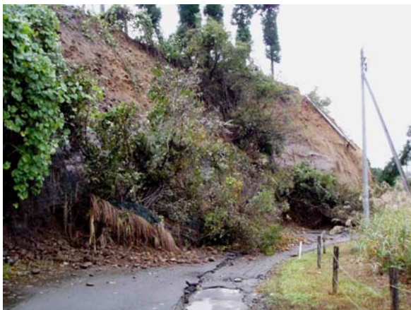
写真-8.3.76 被災直後の道路の状況 (loc.10)
