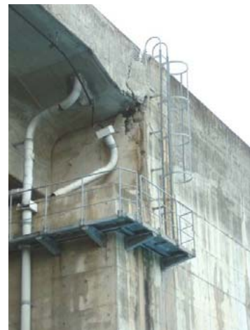
写真-8.2.50 桁衝突による高欄および橋台の損傷（芋川橋）
