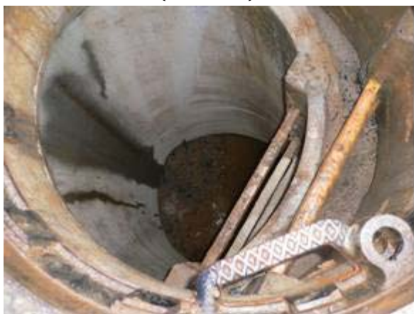
写真-5.6 マンホールの躯体のズレ (旧堀之内町)
