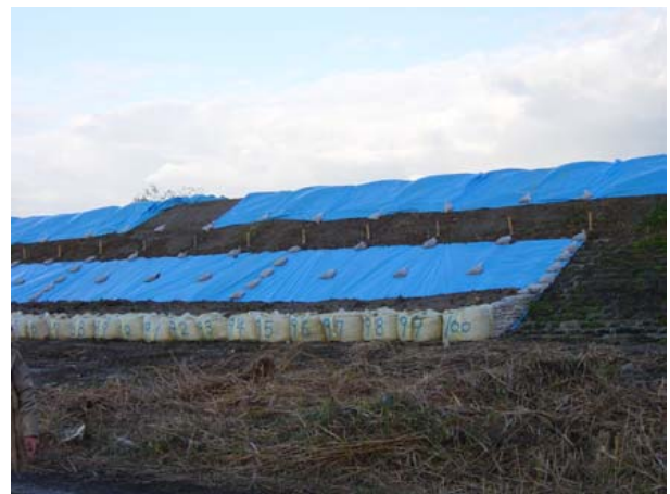
写真-6.11 大型土のうによる補強 （長岡市中条地先）
