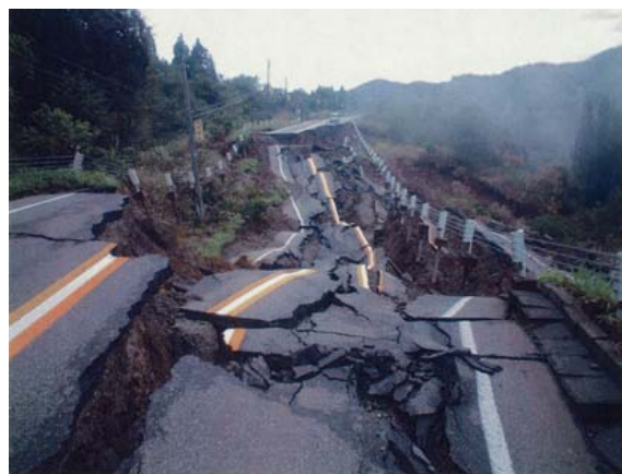
写真-8.3.23 盛土の崩壊状況（国道351号）
