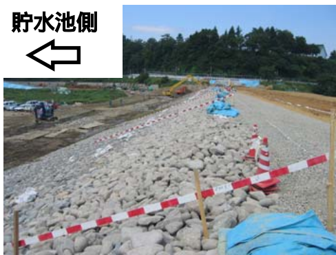
写真-7.7 上流側捨石工 (浅河原調整池)
