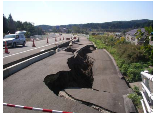
写真-8.3.4 被災した盛土の状況 (国道8号)
