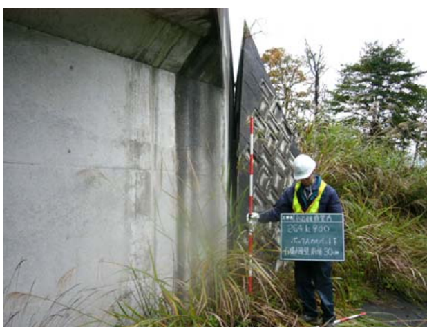
写真-8.3.53 地点 : 坑口擁壁間の開口 (30cm)
