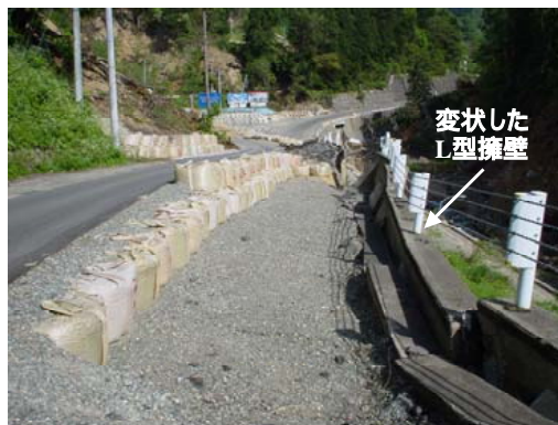
写真-8.3.36 盛土上のL型擁壁の被害例
