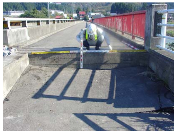
写真-8.3.6 橋梁取付部の段差状況 (国道17号)
