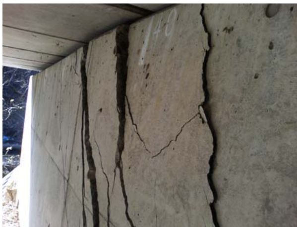
写真-8.2.44 橋台に生じた斜めひびわれ (錦鯉橋)
