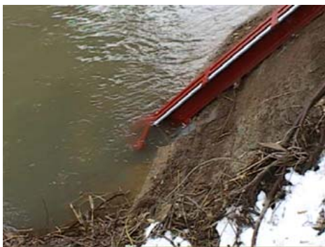
写真-4.20 濁度計の設置状況（平成17年2月23日撮影）
