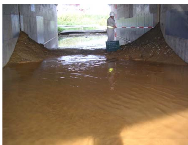
写真-8.3.56 地点 : 内部への土砂流入、噴砂
