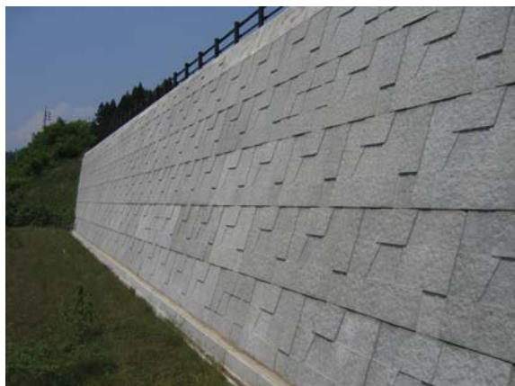
写真-8.3.16 ジオテキスタイル補強土壁による復旧状況 (国道17号)
