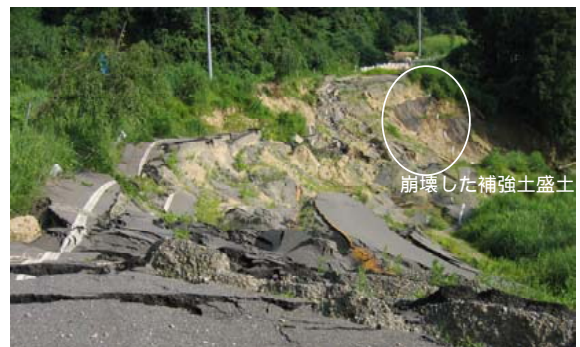
写真-8.3.25 盛土の崩壊状況 (国道290号)
