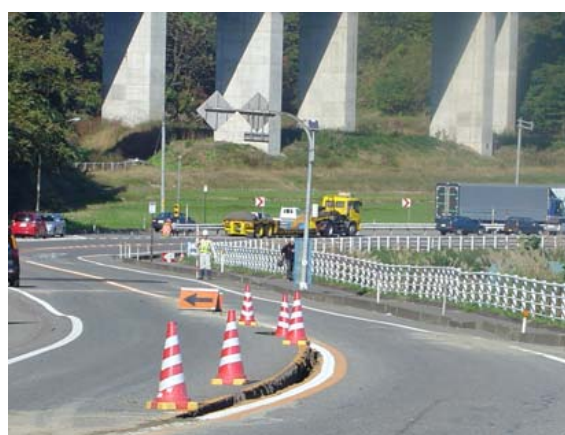
写真-8.3.7 片切片盛部の路面変状 (国道17号)
