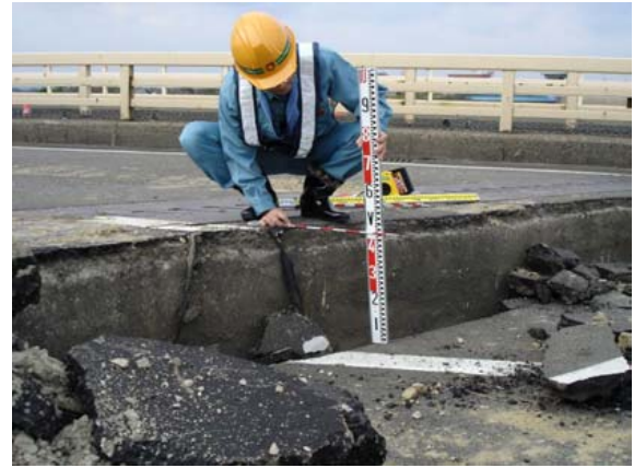
写真-8.3.2 取付盛土と橋梁部との段差（国道8号）
