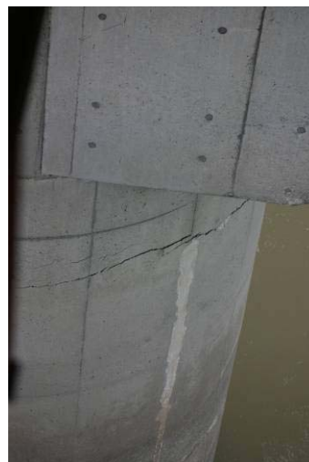
写真-8.2.11 橋脚に生じたひびわれ(P6橋脚)
