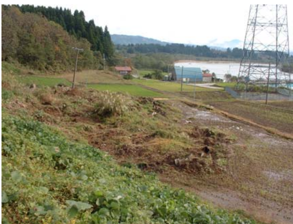
写真-8.3.21 崩壊土先端部の状況（国道117号）
