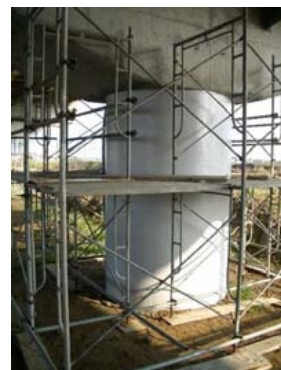
写真-8.2.6 炭素繊維シート巻立てによる応急復旧状況（P6橋脚）
