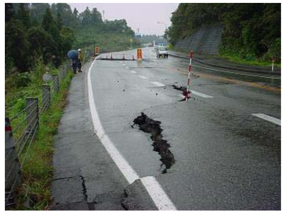
写真-8.3.9 路面の変状（国道17号）
