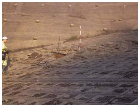
写真-7.28 上流のり尻から見た左岸上流のり面の変状 (川西ダム)
