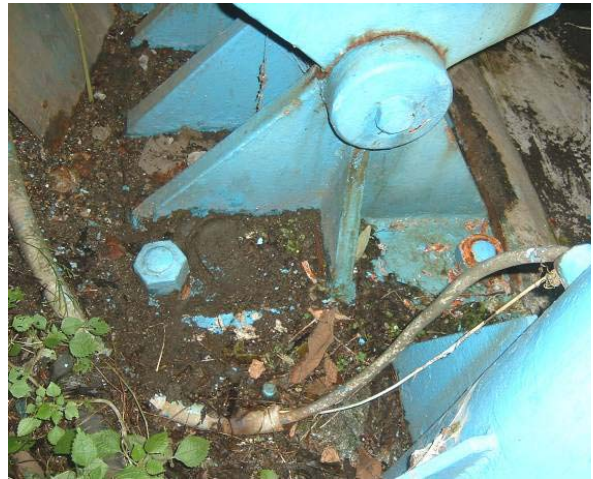
写真-8.2.41 ランガーアーチ固定支承部のアンカーボルトの引き抜け(魚沼橋)
