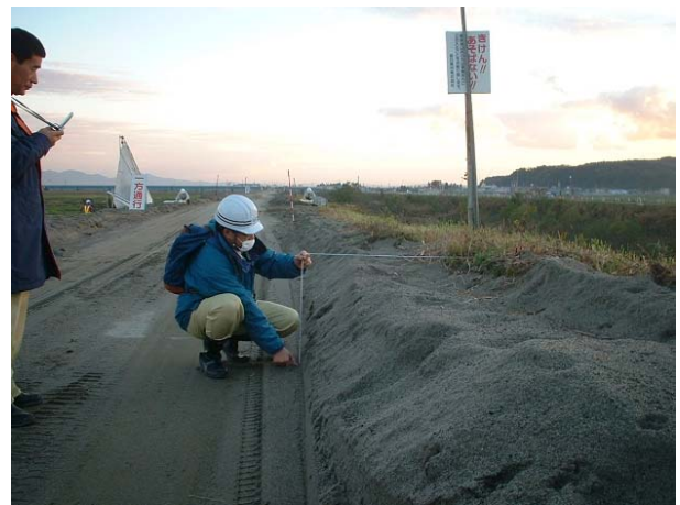
(b)のり肩と天端の段差
