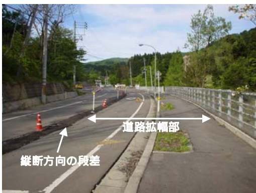
写真-8.3.43 道路面の損傷
