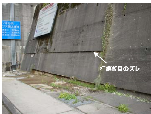
写真-8.3.34 もたれ式擁壁の被災例（国道17号）
