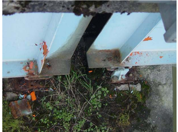
写真-8.2.54 支点上垂直補剛材の座屈（西倉橋）
