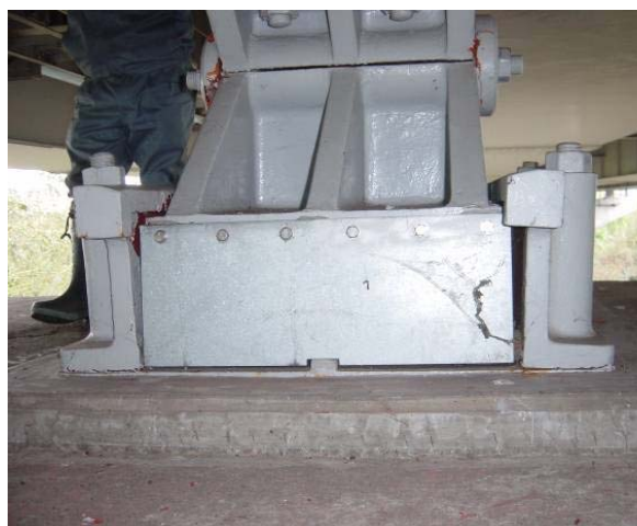
写真-8.2.28 サイドブロックの変形(長岡大橋)
