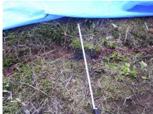
写真-7.26 下流のり面の亀裂 (坪山ダム)
