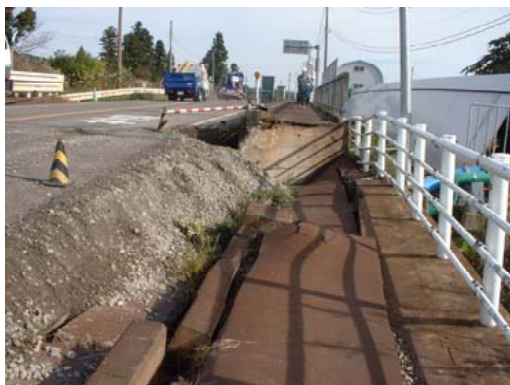
写真-8.3.33 跨線橋取付け盛土の沈下（国道351号）
