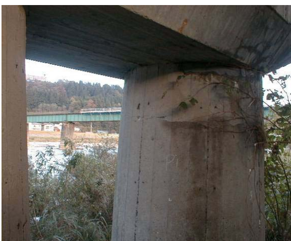
写真-8.2.53 左岸側 1 本目の橋脚の上流側柱頭部に生じた水平ひびわれ（川口橋）
