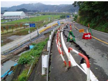
写真-8.3.65 被災直後の道路の状況 (loc.5)
