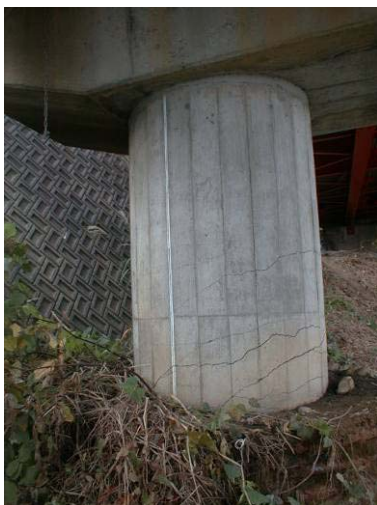
写真-8.2.24 P4橋脚（短柱側）の水平・斜めひびわれ
