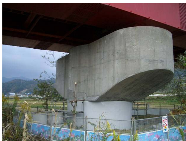
写真-8.2.16 P2橋脚の炭素繊維シート巻立てによる応急復旧状況
