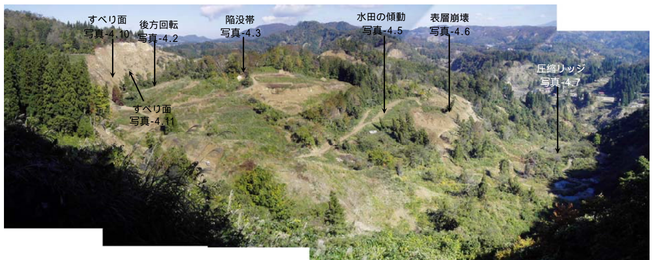
写真-4.1 塩谷神沢川地すべり全景（北東方向を望む 2005年11月1日撮影）
