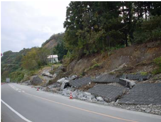
写真-8.3.31 ブロック積擁壁の倒壊（国道117号）
