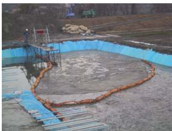
写真-5.14 汚泥引き抜き作業 (堀之内浄化センター)
