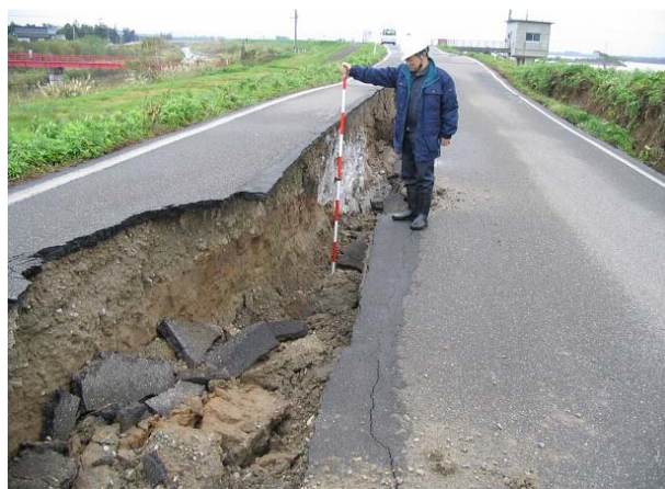
(a) 堤防天端の縦断亀裂と段差
