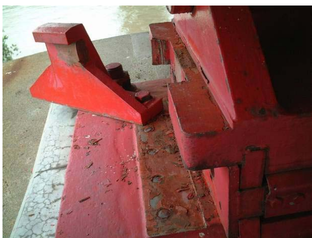
写真-8.2.13 支承サイドブロックの損傷(P6橋脚上)
