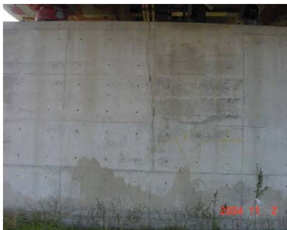
写真-8.2.37 P1 橋脚の垂直ひびわれ（越の大橋）
