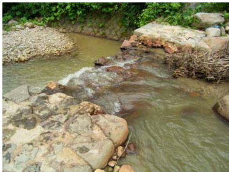
写真-4.18 床固工水通し天端の変状
