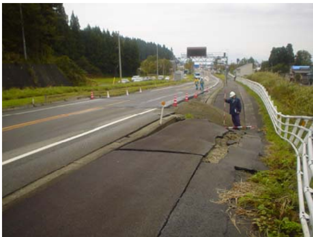
写真-8.3.51 地点 : 上部盛土の沈下 (60cm)
