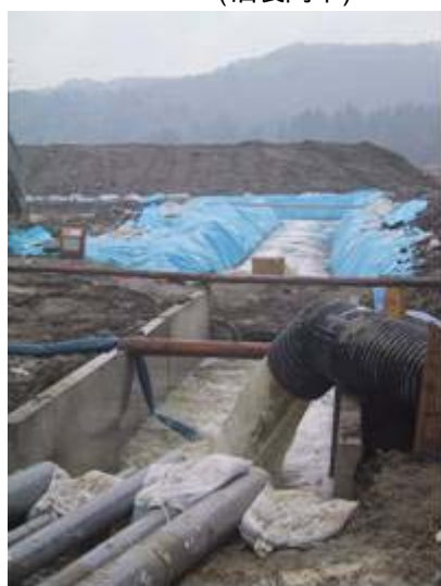
写真-5.12 仮設管渠からの流入 (堀之内浄化センター)
