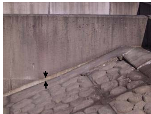
写真-7.24 洪水吐と張りブロック間の沈下 (長福寺ダム)
