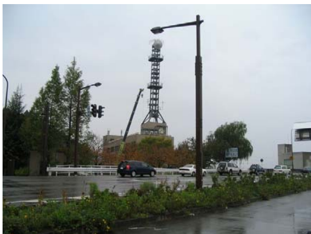
写真-6.8 妙見堰管理所建物の傾斜
