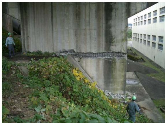
写真-8.2.18 P1橋脚の損傷(A1橋台側、かぶりコンクリートの剥落、軸方向鉄筋のはらみだし、帯鉄筋の重ね継手のはずれ)
