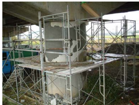
写真-8.2.5 モルタルによる断面修復後の状況（P5橋脚、この後に炭素繊維シート巻立て）
