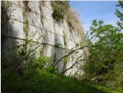
写真-8.3.45 アンカー式補強土壁の被災状況
