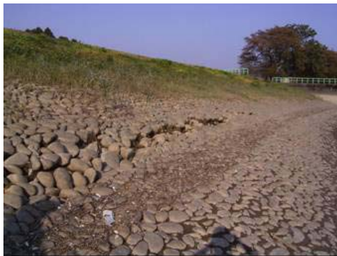
写真-7.17 貯水池側のり面のすべり変状 (山本調整池)
