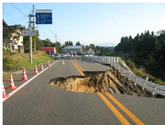
写真-8.3.13 崩壊した道路（国道17号）
