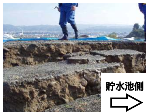
写真-7.2 天端亀裂による段差 (浅河原調整池)
