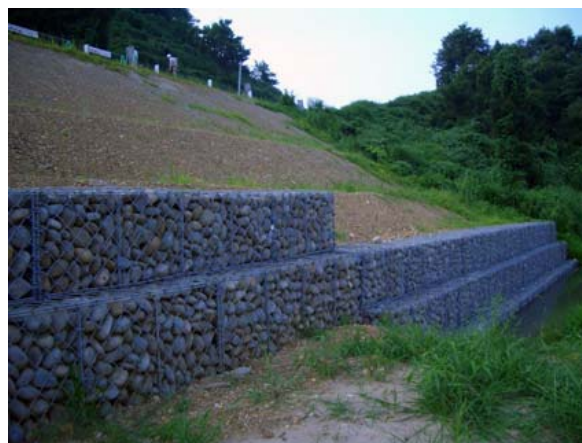
図-8.3.22 大型ふとん籠工による復旧状況（国道117号）
