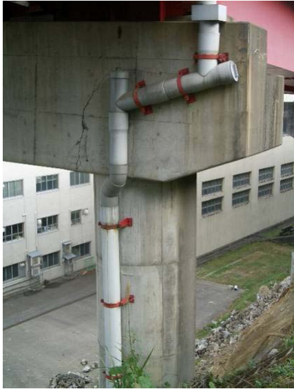
写真-8.2.22 P3橋脚梁部のひびわれ
