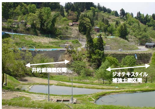
写真-8.3.49 ジオテキスタイル補強土壁の遠景
