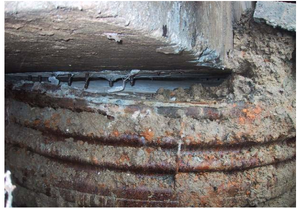
写真-8.2.25 A1橋台部における橋台躯体と深礎杭間の鉄筋の破断
