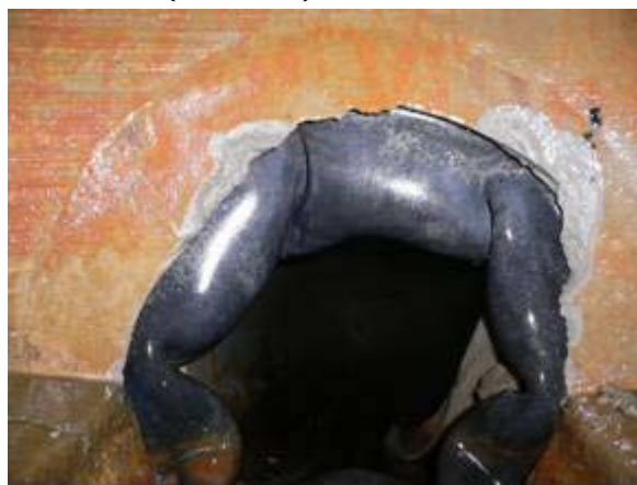
写真-5.7 マンホールと管渠の接合部のズレ (旧長岡市)
