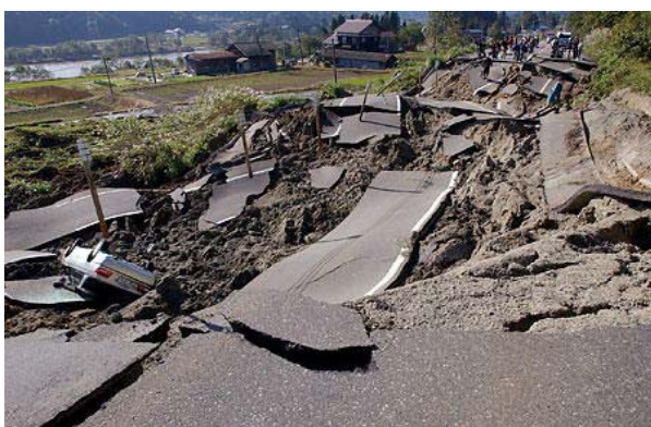
写真-8.3.20 片切片盛土のり面の崩壊状況（国道117号）
