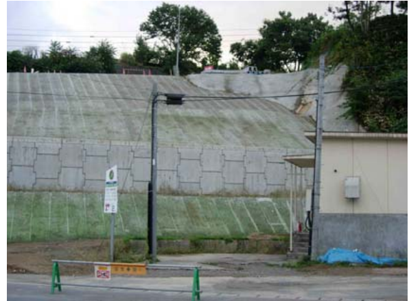
写真-8.3.67 復旧後の斜面の状況 (loc.5)
