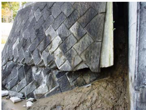
写真-8.3.32 ブロック積擁壁の躯体のせん断破壊例
