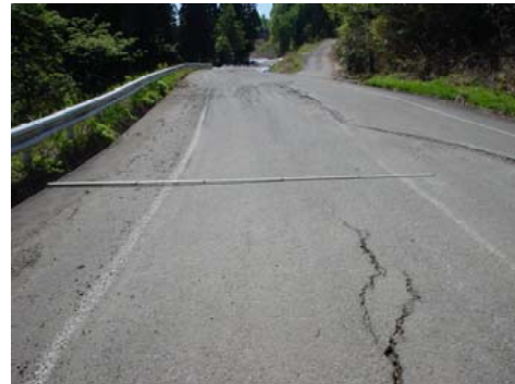
写真-8.3.47 天端の道路面の被害状況
