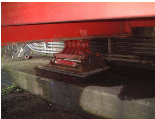
写真-8.2.12 可動支承の損傷状況 (A2 橋台)
