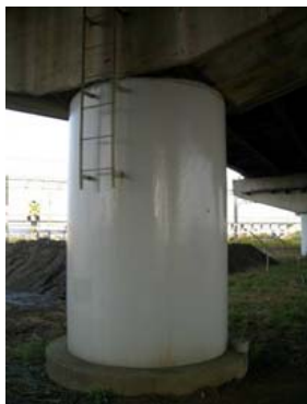
写真-8.2.2 上り線橋脚の鋼板巻立て補強
