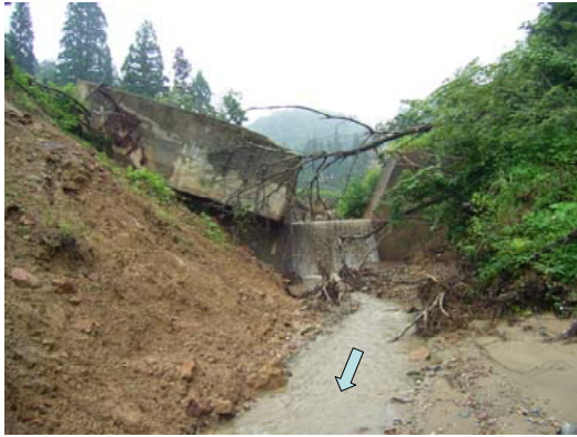
写真-4.16 地すべりにより袖部が倒壊した事例
