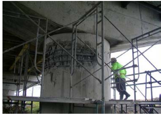
写真-8.2.3 P5橋脚の断面損傷状況
