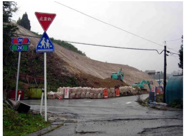
写真-8.3.73 1年後の道路の状況 (loc.8)
