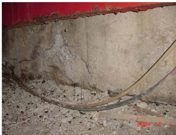
写真-8.2.35 橋台パラベットのひびわれ（和南津橋）
