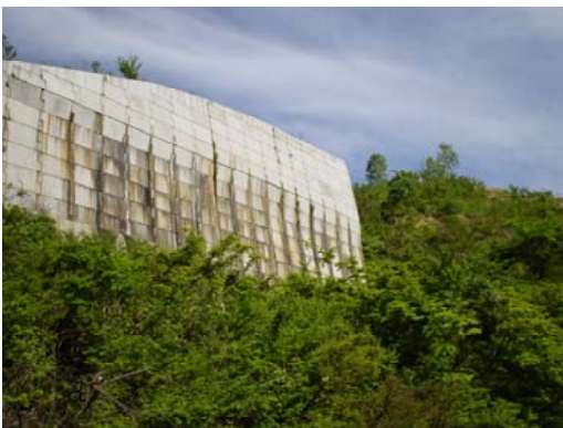
写真-8.3.46 アンカー式補強土壁の変状
