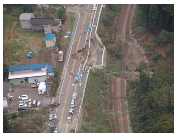
写真-8.3.12 被災箇所周辺の航空写真（国道17号）
