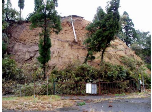
写真-8.3.77 崩壊直後の斜面の状況 (loc.10)
