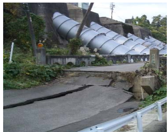
写真-8.2.27 旧山辺橋（左）の橋台背面盛土
