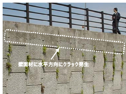
写真-8.3.41 壁面材のクラックの発生
