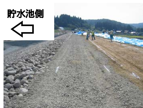
写真-7.20 フィルターゾーン全景 (山本調整池)
