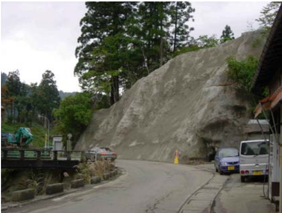
写真-8.3.75 1年後の道路の状況 (loc.9)
