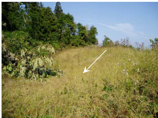
写真-4.5 地すべり斜面中間部の水田の傾動 (東方向を望む)
