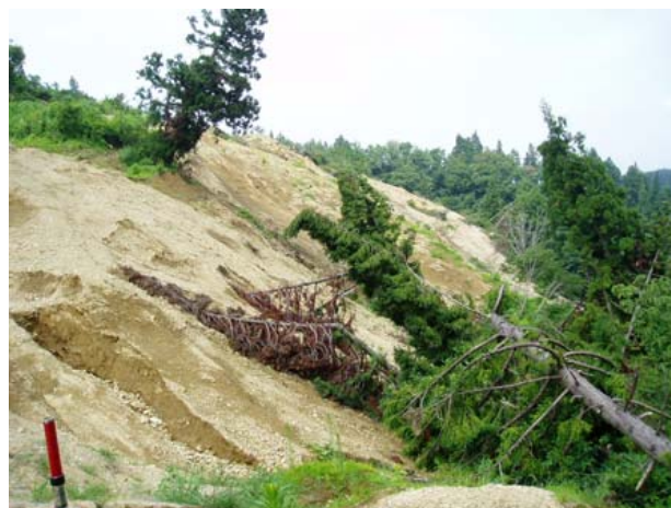
写真-4.6 地すべり斜面中間部の表層崩壊 (東方向を望む)
