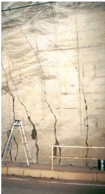
写真-8.4.4 木沢トンネルの被害状況 （横断方向のひび割れ）
