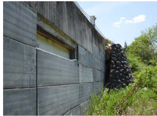
写真-8.3.40 EPSを用いた擁壁の被害
