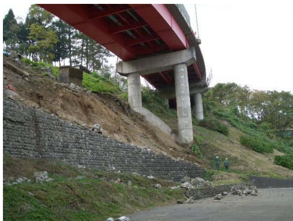
写真-8.2.21 P3橋脚 (P2橋脚側)
