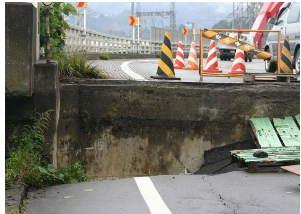
写真-8.2.26 A2橋台背面盛土の沈下
