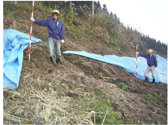
写真-8.3.8 盛土のり面の変状（国道17号）
