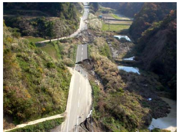
写真-8.3.27 沢埋め盛土の崩壊状況の空中写真（小国町法末）
