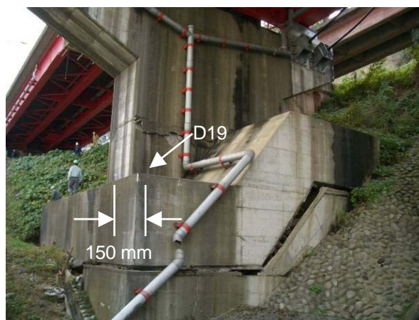
写真-8.2.19 P1橋脚の損傷(P2橋脚側)
