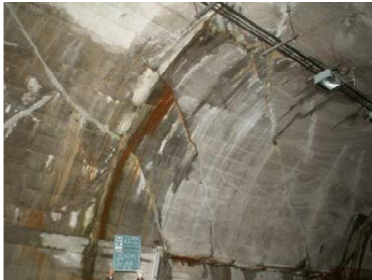
写真-8.4.6 荒谷トンネルの被害状況 (斜め方向ひび割れ)
