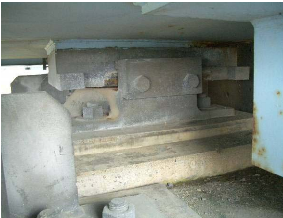
写真-8.2.52 BP 支承に生じた擦過痕（越路橋）
