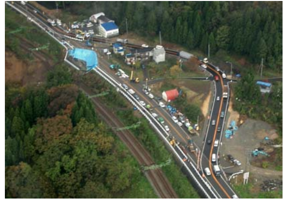
写真-8.3.15 山側に設置した緊急迂回路（国道17号）
