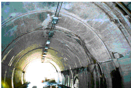
写真-8.4.7 荒谷トンネルの被害状況 (天端の圧さ、側壁部の圧壊)
