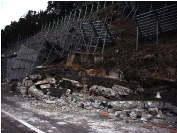
写真-8.3.29 ブロック積擁壁の倒壊（国道17号）
