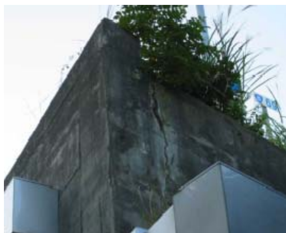
写真-8.2.29 A2橋台ウイング部のひびわれ(宮本橋)
