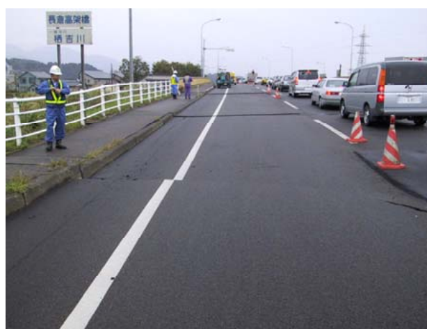
写真-8.3.55 地点 : 上部道路の段差 (25cm)
