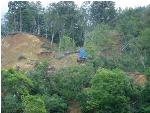
写真-4.2 地すべり斜面上部の陥没帯 (滑落崖附近から南東方向を望む)
