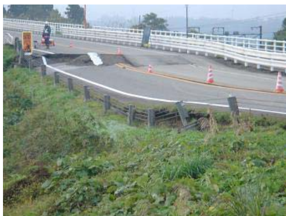
写真-8.3.11 石田川上流側盛土のり面の変状（国道17号）
