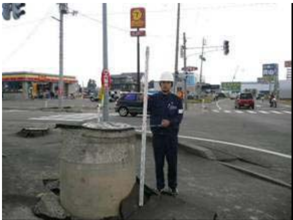
写真-5.4 マンホールの浮上がり (小千谷市)
