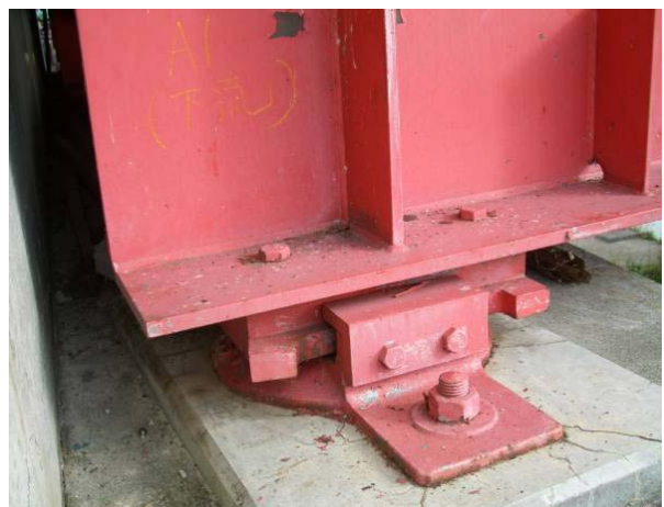
写真-8.2.56 可動支承上沓の変位制限ストッパー部分の変形（宇賀地橋）
