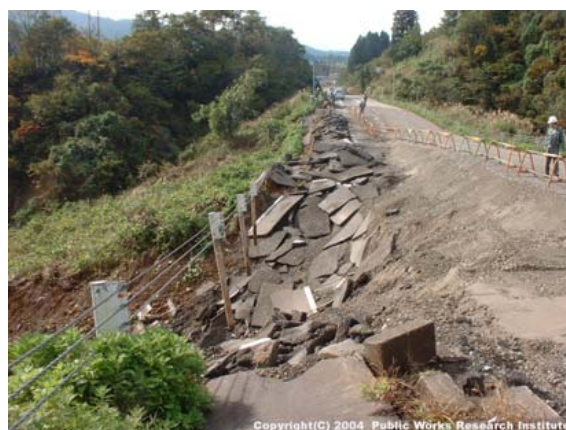
写真-8.3.17 盛土のり面の崩壊状況 (国道117号)
