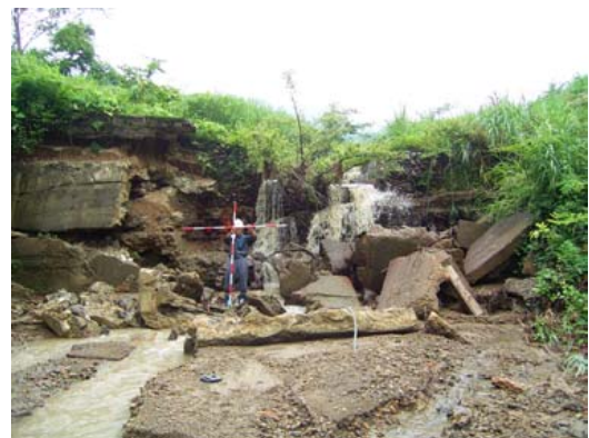
写真-4.15 堤体本体が破壊された事例
