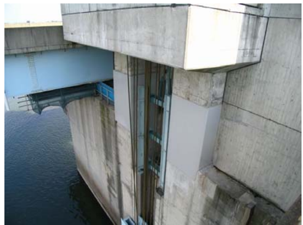
(a)門柱への鋼板巻付け
