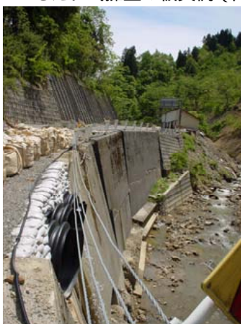
写真-8.3.35 もたれ式擁壁の被災例（国道291号）
