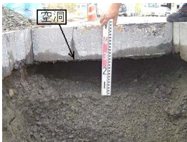
写真-5.11 アスファルト舗装下の空洞 (旧長岡市)
