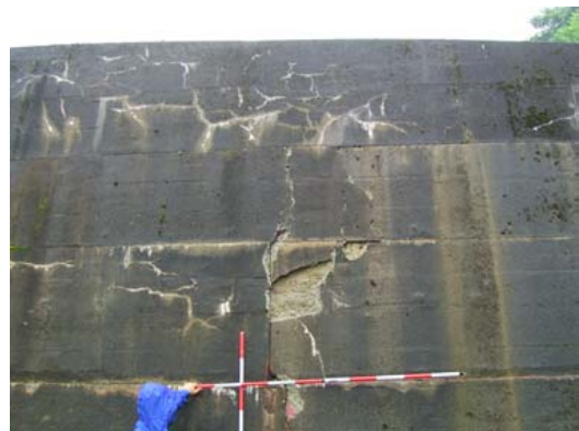
写真-4.14 堤体の表面が一部剥離した事例
