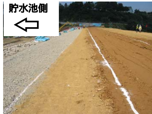
写真-7.6 粗粒フィルター～さや土～心壁材 (浅河原調整池)
