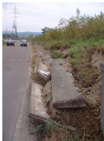
写真-8.3.37 倒壊したL型擁壁（関越道小千谷市内）
