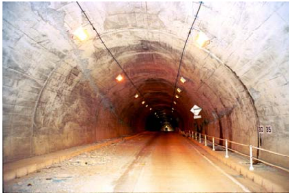
写真-8.4.3 木沢トンネルの被害状況 （側壁部からアーチ部のひび割れ）
