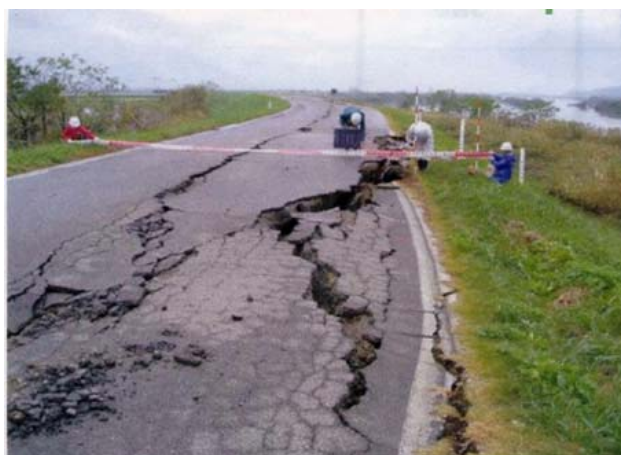
写真-6.1 信濃川右岸堤防2.0km付近（長岡市中条地先）の堤防天端の縦断亀裂と段差（北陸地方整備局撮影）
