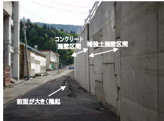
写真-8.3.44 補強土擁壁とコンクリート擁壁の変状
