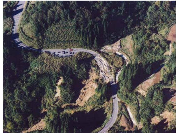
写真-8.3.24 盛土崩壊箇所周辺の航空写真 (国道290号)
