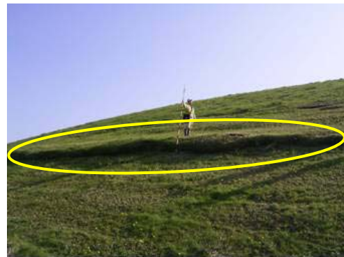
写真-7.12 貯水池外側のり面のはらみだし部 (新山本調整池)
