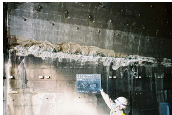
写真-8.4.2 和南津トンネルの被害状況 （側壁の押し出し）
