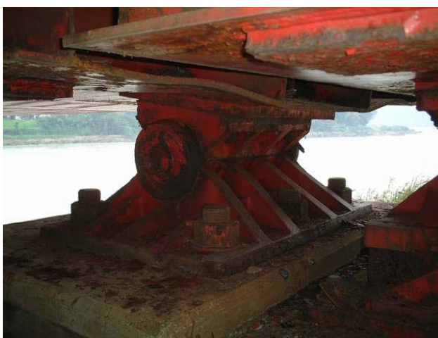
写真-8.2.14 箱桁下フランジの変形(P5橋脚上)
