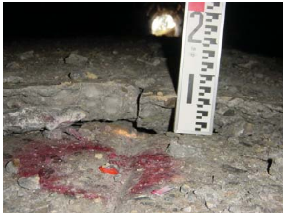
写真-8.4.8 羽黒トンネルの被害状況 (舗装版の隆起)
