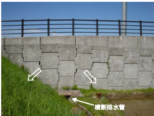
写真-8.3.42 横断排水管周辺の不同沈下
