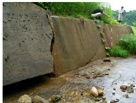
写真-4.19 砂防えん堤側壁の変状
