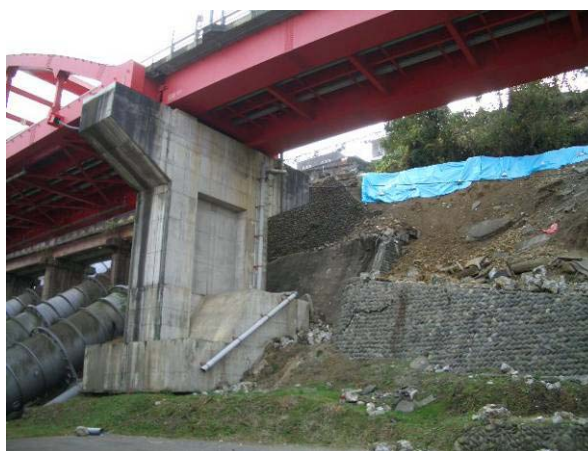
写真-8.2.20 P2橋脚 (P3橋脚側)
