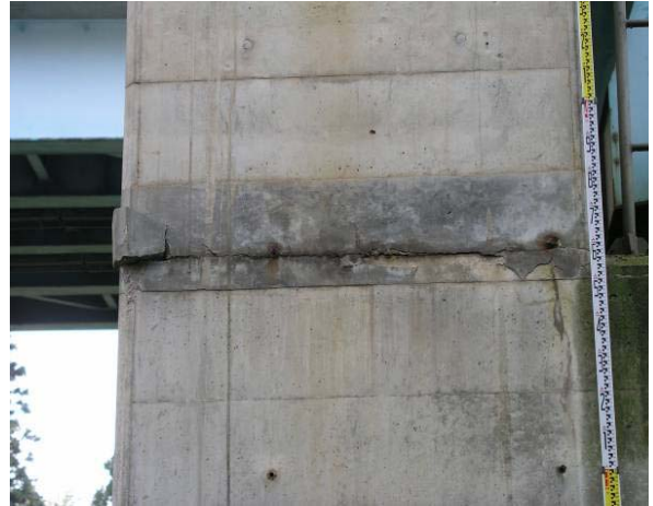
写真-8.2.48 橋脚かけ違い部の水平ひびわれ（塩殿橋）
