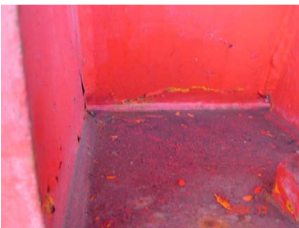
写真-8.2.32 支点上の桁ウェブ面のはらみ (堀之内橋)
