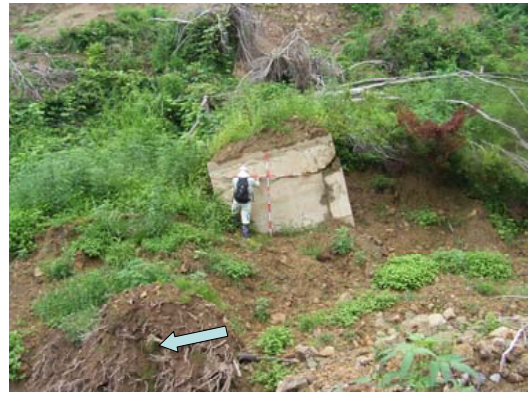
写真-4.17 地すべりにより袖部が倒壊した事例
