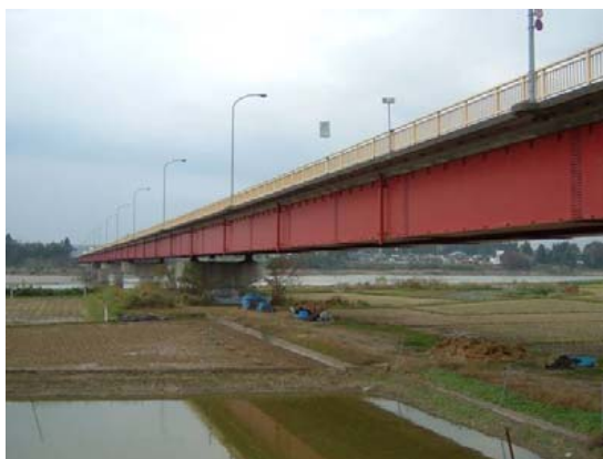
写真-8.2.7 小千谷大橋（手前が起点側）
