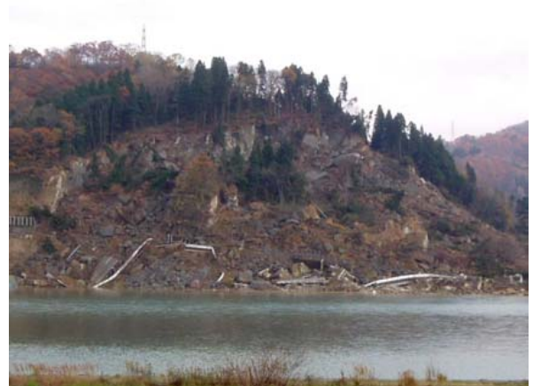
写真-8.3.64 崩壊直後の斜面の状況 (loc.4)
