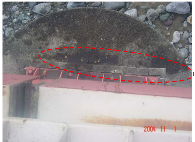
写真-8.2.55 沓座モルタルの損傷（姿大橋）
