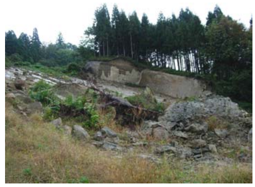
写真-8.3.63 北側の崩壊状況 (loc.3)
