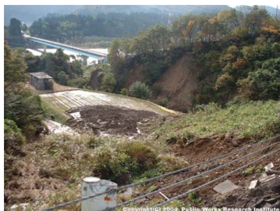
写真-8.3.18 崩壊土先端部の状況 (国道117号)
