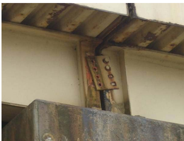
写真-8.2.45 桁間連結プレートとボルトのはずれ (旭橋)
