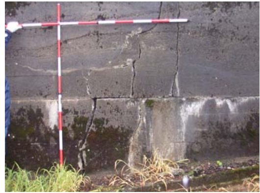
写真-4.12 堤体にクラックが生じた事例
