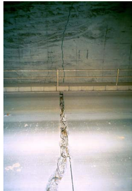
写真-8.4.5 木沢トンネルの被害状況 （舗装版のひび割れ）
