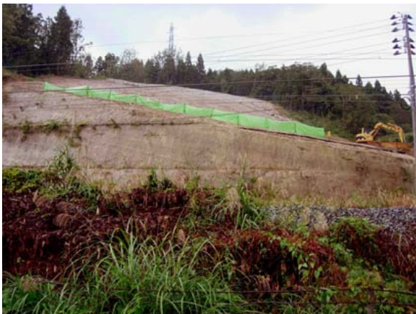
写真-8.3.71 1年後の斜面の状況 (loc.7)
