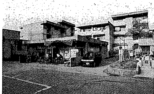
写真補-7 人工地盤上の改良住宅
