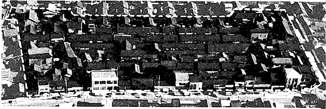
写真 補-3 従前の様子（点線内に建設された）
