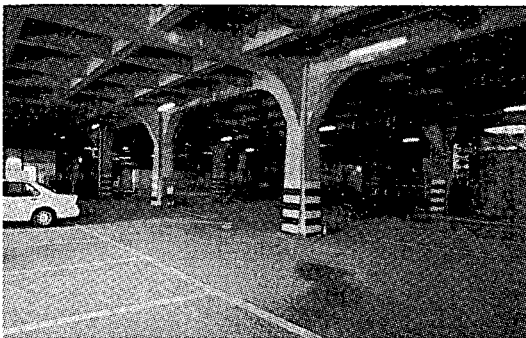
写真補-6 人工地盤下の駐車場
