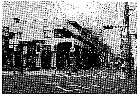
写真 補-9 反対側から見た第二期の部分
