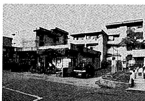
写真 1-2 人工地盤上の共同住宅
