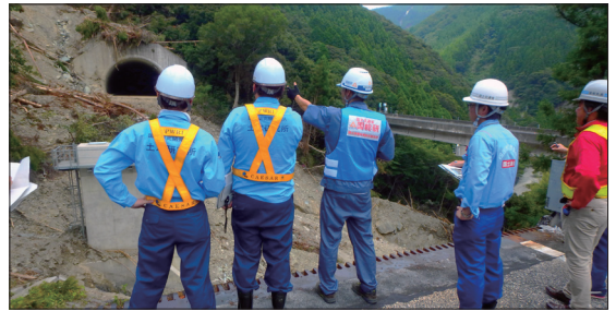
高知自動車道立川橋の被災状況調査の実施状況
