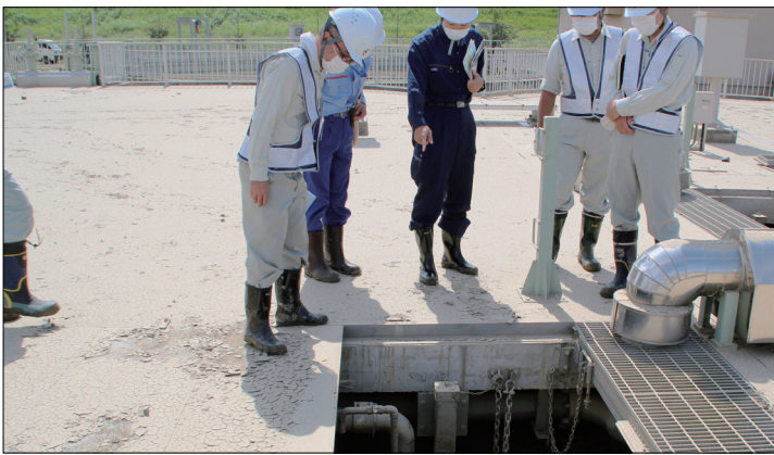
真備浄化センター被災状況調査の実施状況
