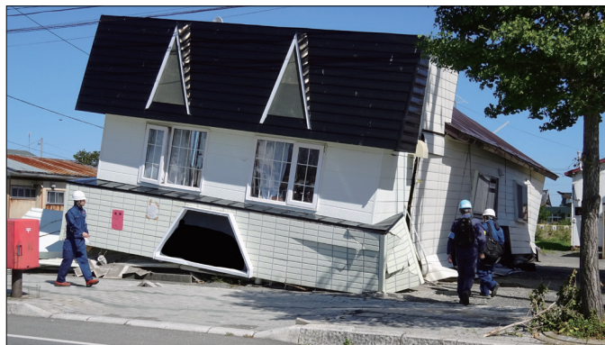
倒壊した店舗併用住宅(むかわ町)
